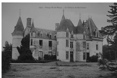
Vue de la façade antérieure Phot. Elise Lauranceau, Autr. Henri Laurent IVR53_20035604291NUCB
