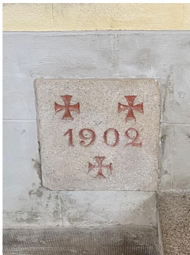
Date de la reconstruction de l'édifice Phot. Baptiste Oligo IVR53_20255610469NUCA
