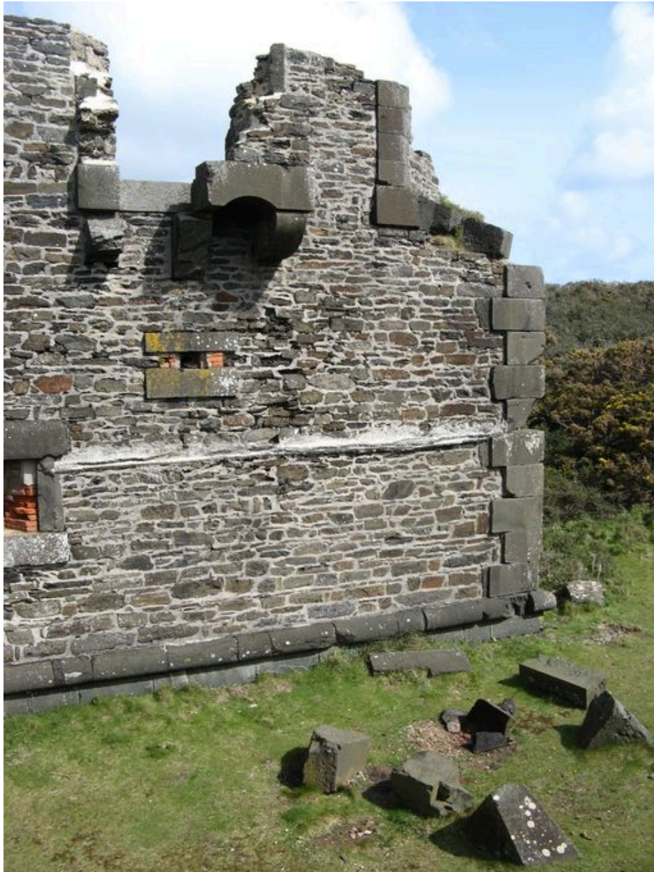
Balustrade effondrée du fort de l'Aber
