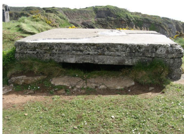
Batterie de mortier allemande à l'ouest de l'île de l'Aber Phot. Guillaume Marie IVR53_20082908333NUCA
