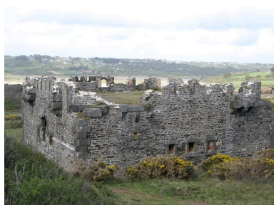
Vue postérieure du fort de l'Aber Phot. Guillaume Marie IVR53_20082908332NUCA
