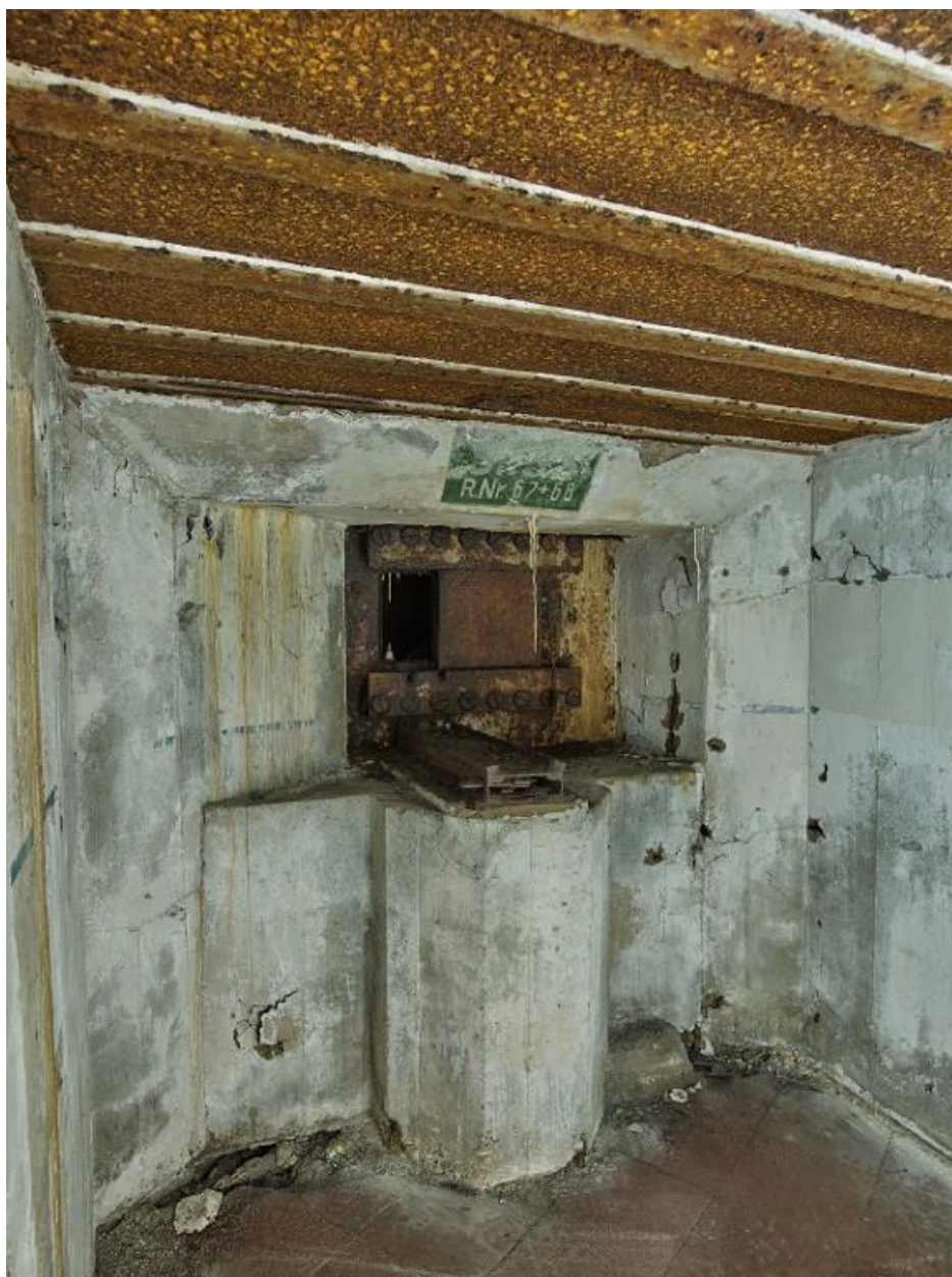
Vue de la chambre de combat sud-ouest : support d'affût de la mitrailleuse et créneau blindé ; au-dessus du poste de tir, cartouche avec marquage. L'embrasure est murée. La peinture des murs, avec liseré, est d'origine
