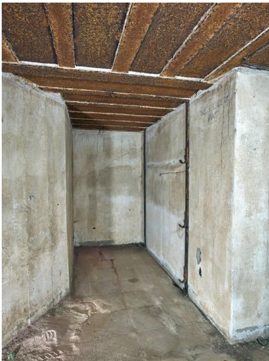
Vue du logement des soldats de la chambre de combat nord : fixation murale et crochets de suspension pour trois couchettes tubulaires
