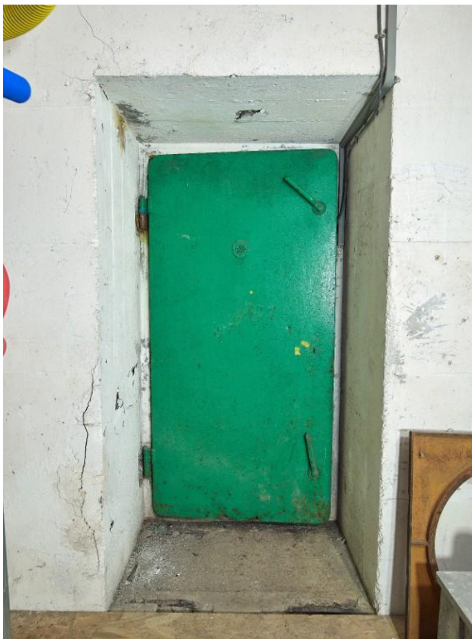
Vue de la porte étanche du vestibule depuis l'extérieur
