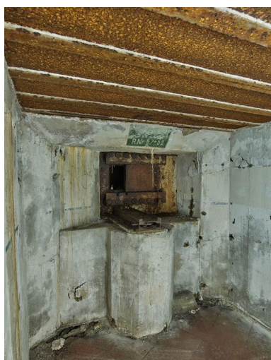
Vue de la chambre de combat sud-ouest : support d'affût de la mitrailleuse et créneau blindé ; au-dessus du poste de tir, cartouche avec marquage. L'embrasure est murée. La peinture des murs, avec liseré, est d'origine Phot. Bernard Bègne IVR53_20235600696NUCA
