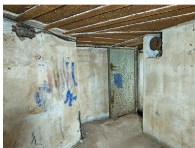
Vue de la chambre de combat nord : porte étanche et bouche réglable à vis d'arrivée d'air (Zuluft Leitung) Phot. Bernard Bègne IVR53_20235600716NUCA
