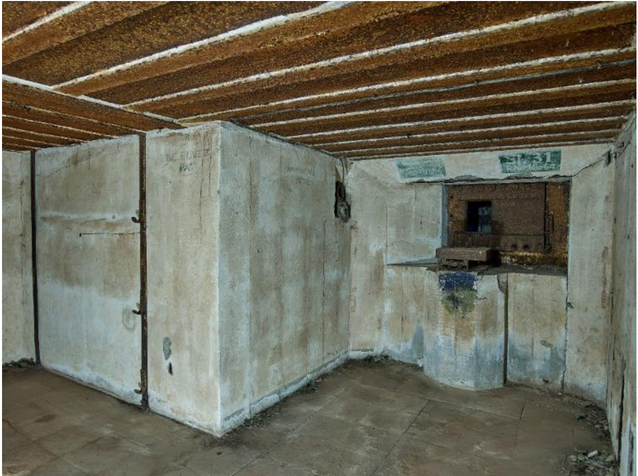
Vue de la chambre de combat nord : support d'affût de la mitrailleuse et créneau blindé ; à gauche, logement des soldats : fixation murale et crochets de suspension pour trois couchettes tubulaires. Au-dessus du poste de tir, deux cartouches avec marquage
