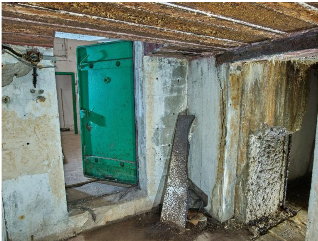
Vue du vestibule avec sa porte étanche. A droite, le mur en béton est élargi afin de permettre un passage plus aisé
