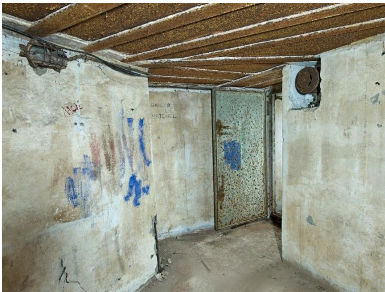
Vue de la chambre de combat nord : porte étanche et bouche réglable à vis d'arrivée d'air (Zuluft Leitung)
