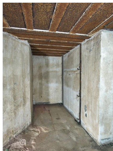
Vue du logement des soldats de la chambre de combat nord : fixation murale et crochets de suspension pour trois couchettes tubulaires Phot. Bernard Bègne IVR53_20235600715NUCA
