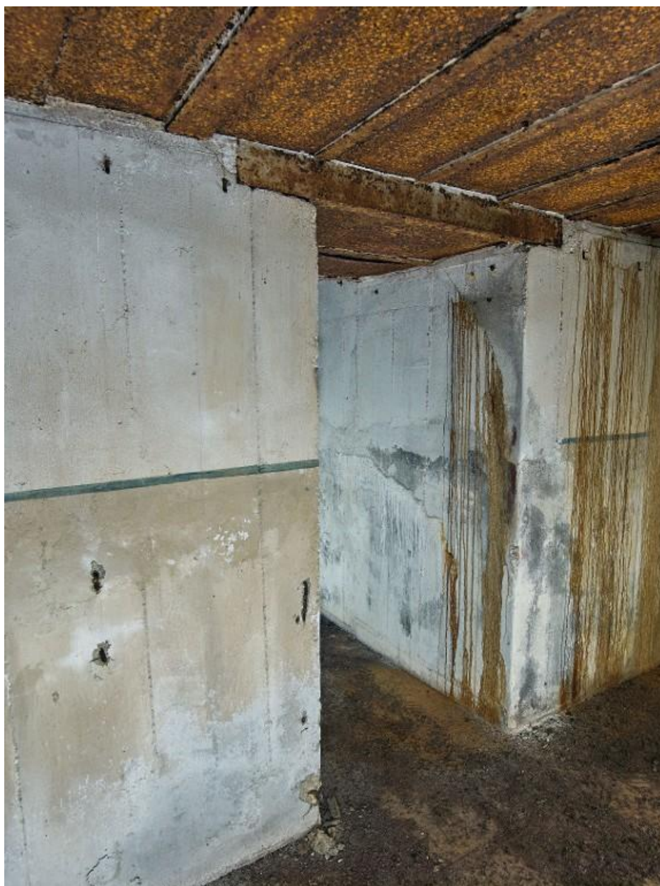
Vue de l'entrée du logement des soldats de la chambre de combat sud-ouest. La peinture des murs, avec liseré, est d'origine
