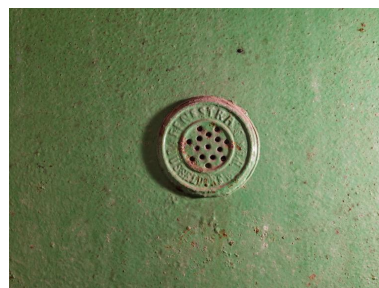
Vue de détail de la porte étanche du vestibule : #illeton. On peut lire : FENESTRA DUSSELDORF Phot. Bernard Bègne IVR53_20235600710NUCA
