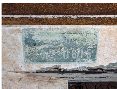
Vue de la chambre de combat nord : l'un des deux cartouches avec marquage
