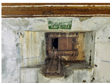
Vue de la chambre de combat sud-ouest : support d'affût de la mitrailleuse et créneau blindé ; au-dessus du poste de tir, cartouche avec marquage. L'embrasure est murée. La peinture des murs, avec liseré, est d'origine Phot. Bernard Bègne IVR53_20235600697NUCA
