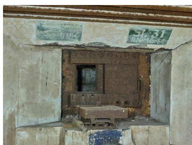
Vue de la chambre de combat nord : support d'affût de la mitrailleuse et créneau blindé ;
