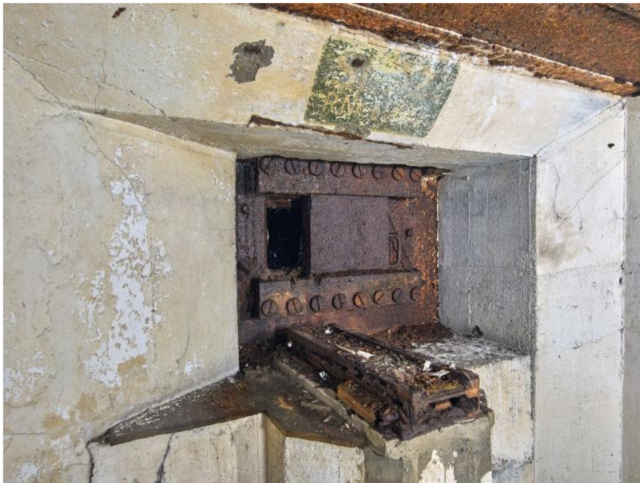
Vue de la chambre de combat nord-ouest : support d'affût de la mitrailleuse et créneau blindé ; au-dessus, cartouche avec marquage. Cette chambre de combat est partiellement inondée. L'embrasure est murée
