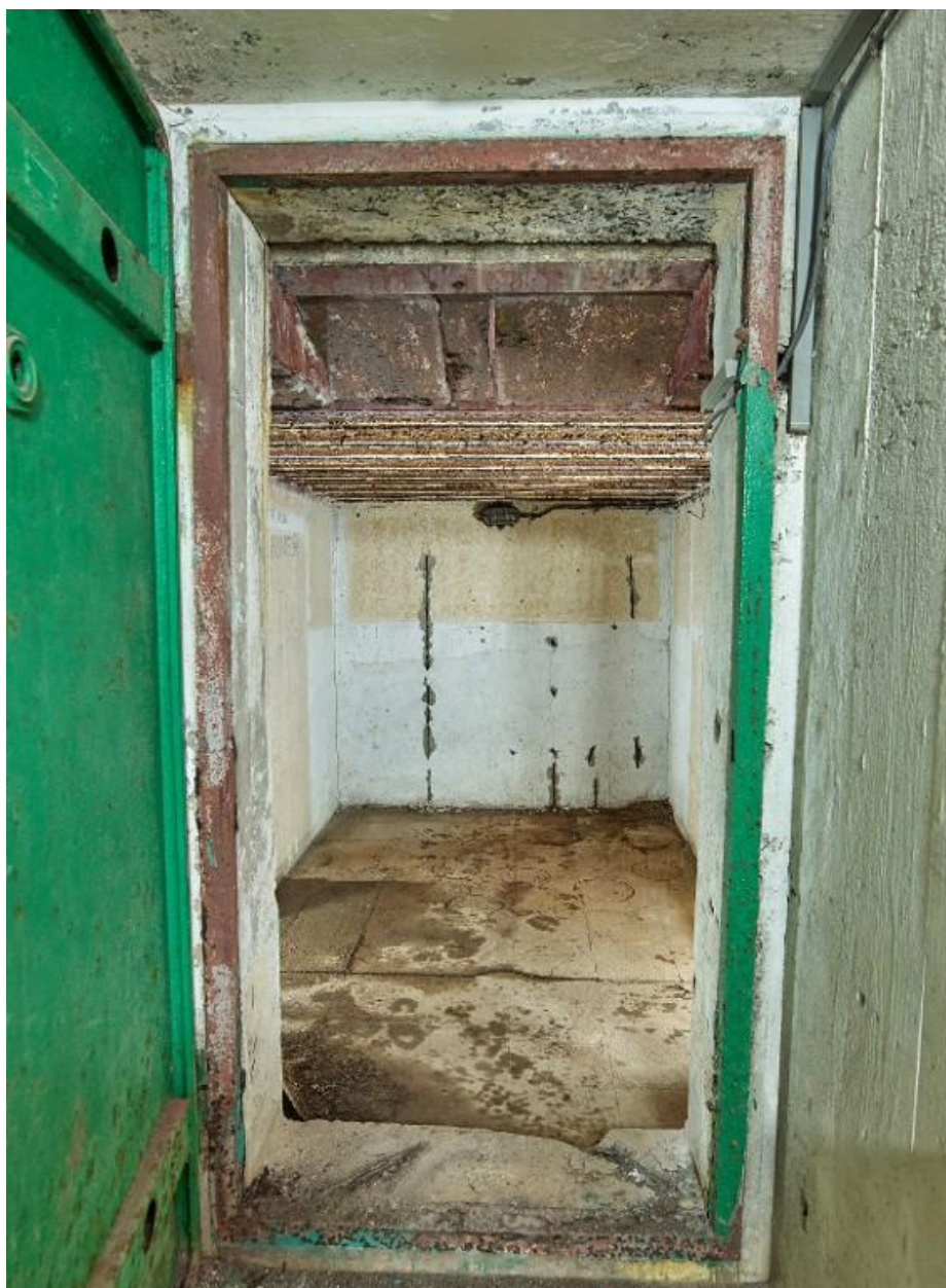
Vue du vestibule depuis l'extérieur : à gauche, la porte étanche
