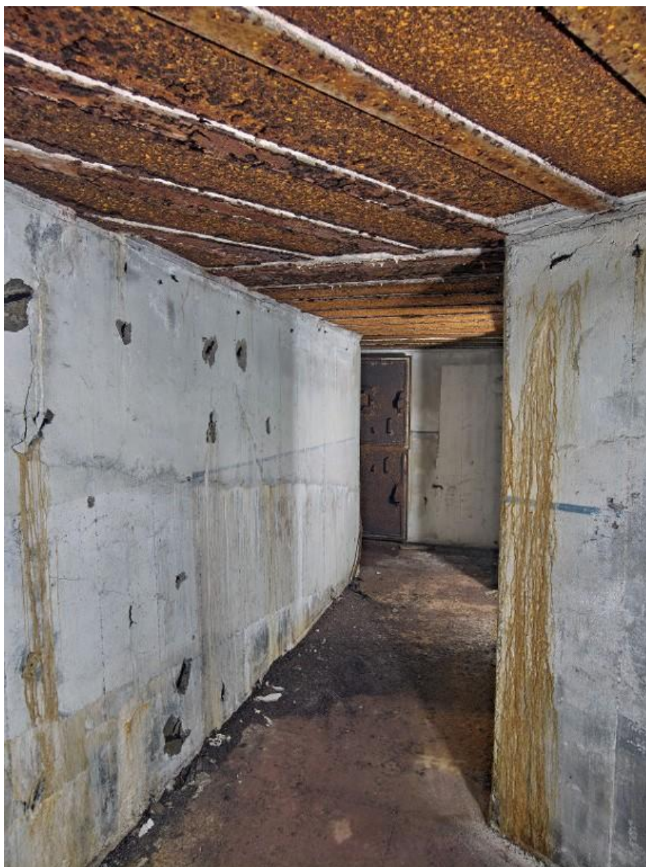
Vue du couloir d'accès au logement des soldats et à la chambre de combat sud-ouest. La peinture des murs, avec liseré, est d'origine
