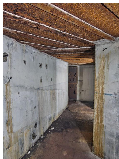
Vue du couloir d'accès au logement des soldats et à la chambre de combat sud-ouest. La peinture des murs, avec liseré, est d'origine Phot. Bernard Bègne IVR53_20235600699NUCA
