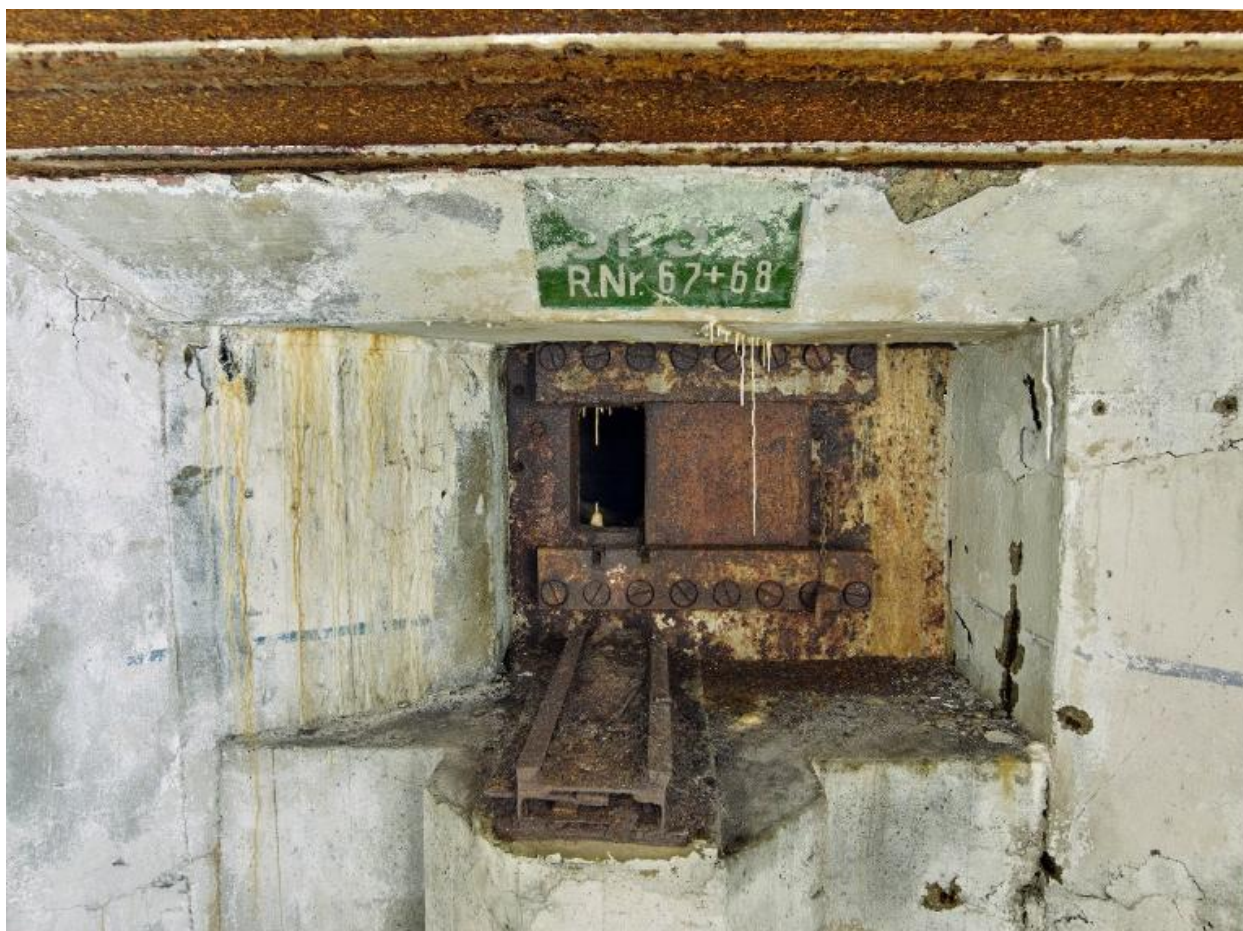
Vue de la chambre de combat sud-ouest : support d'affût de la mitrailleuse et créneau blindé ; au-dessus du poste de tir, cartouche avec marquage. L'embrasure est murée. La peinture des murs, avec liseré, est d'origine
