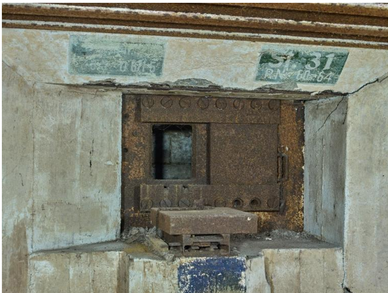
Vue de la chambre de combat nord : support d'affût de la mitrailleuse et créneau blindé ; au-dessus, deux cartouches avec marquage. Le volet blindé est déposé. L'embrasure est murée
