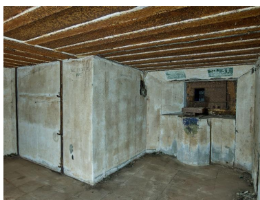
Vue de la chambre de combat nord : support d'affût de la mitrailleuse et créneau blindé ; à gauche, logement des soldats : fixation murale et crochets de suspension pour trois couchettes tubulaires. Au-dessus du poste de tir, deux cartouches avec marquage Phot. Bernard Bègne IVR53_20235600714NUCA
