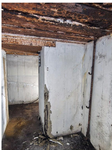
Vue du logement des soldats de la chambre de combat sud-ouest : fixation murale et crochets de suspension pour trois couchettes tubulaires Phot. Bernard Bègne IVR53_20235600700NUCA
