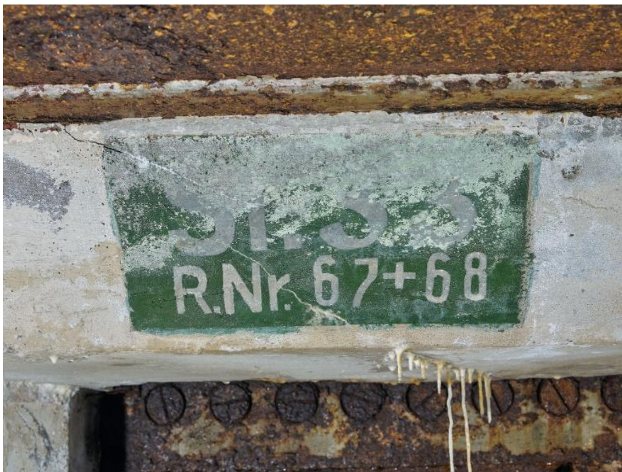
Vue de la chambre de combat sud-ouest : cartouche avec marquage. On peut lire : St. 33 ; R.Nr. 67+68
