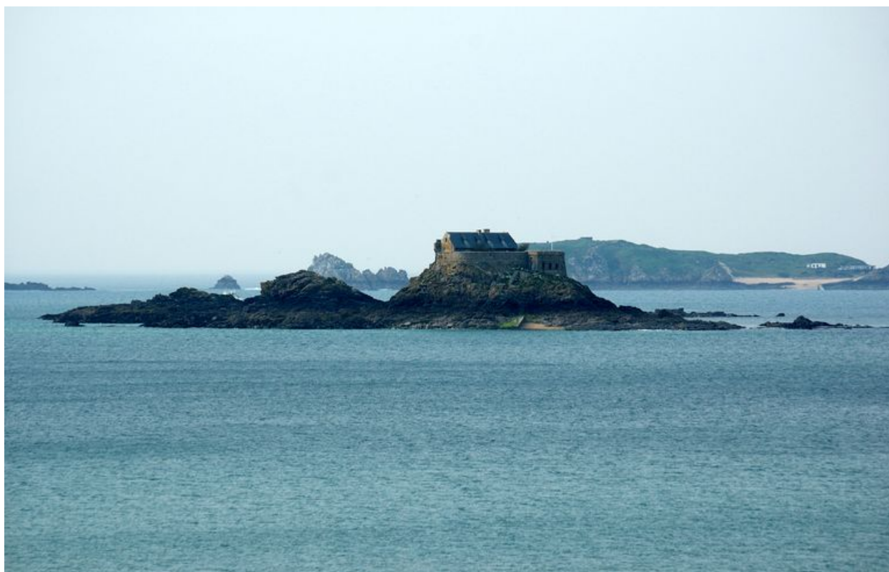
Vue générale du fort de l'île Harbour
