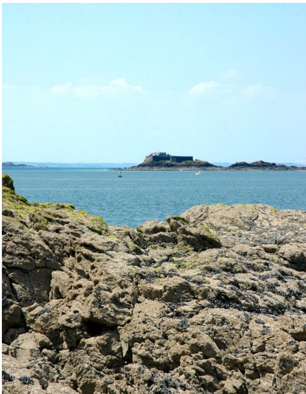
Vue générale du fort de l'île Harbour depuis le fort du Petit Bé
