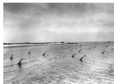
Obstacles de plage : les asperges de Rommel à marée haute. Une mine est accrochée à l'extrémité du poteau, 19 juin 1944, Grandcamp Maisy, Calvados (Archives Normandie : 1939-1945) Repro. Guillaume Lécueillier IVR53_20042904046NUCA
