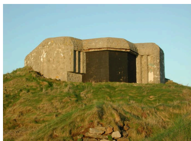
Vue générale d'un bunker du Mur de l'Atlantique : casemate de type 671 de l'ensemble fortifié de Toulbroc'h à Locmaria-Plouzané (défense des approches du goulet de Brest) Phot. Guillaume Lécueillier IVR53_20022901659NUCA
