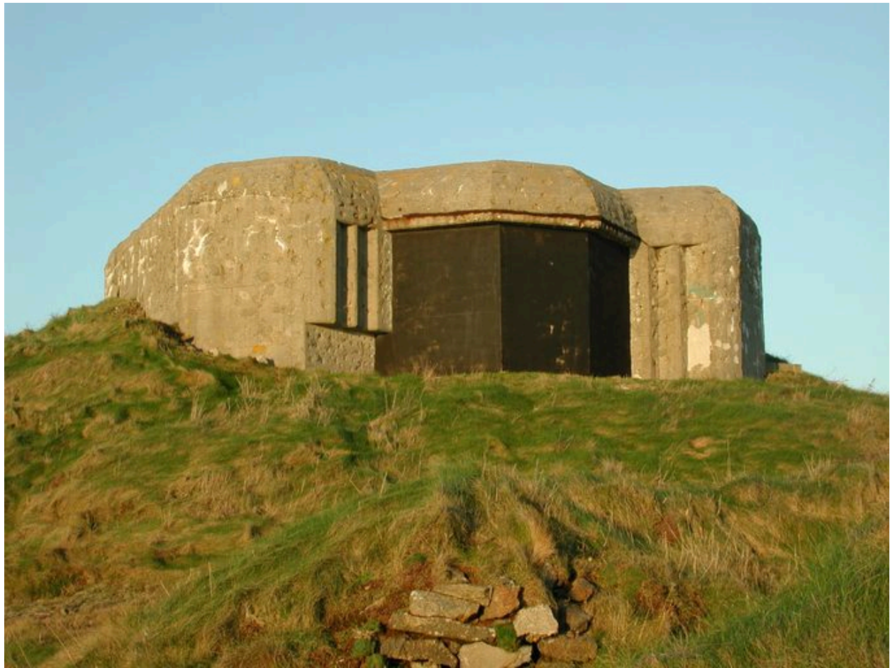
Vue générale d'un bunker du Mur de l'Atlantique : casemate de type 671 de l'ensemble fortifié de Toulbroc'h à Locmaria-Plouzané (défense des approches du goulet de Brest)
