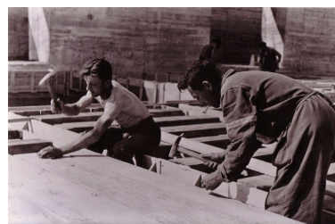
Image de propagande nazie : "Des luxembourgeois à la construction du plafonnage de bois pour l'entrevoûte de béton dans une soute d'atelier" [travailleurs de l'organisation Todt] Repro. Andrea Santangelo IVR53_20042903592NUCA
