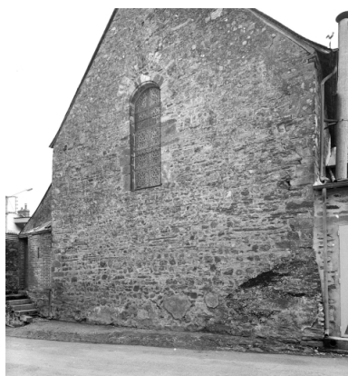
Transept, bras nord, fenêtre du pignon. Phot. François Dagorn IVR53_19703500320V
