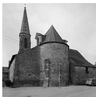
Chevet, vue prise du nord-ouest. Phot. François Dagorn IVR53_19703500322V
