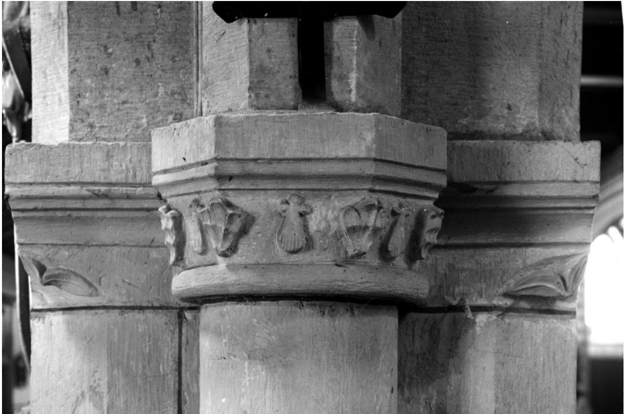
Choeur, arcade, vue de détail du chapiteau.
