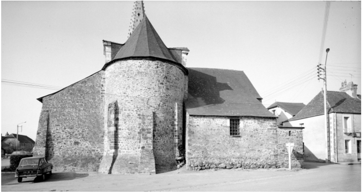
Elévation Est : vue générale
