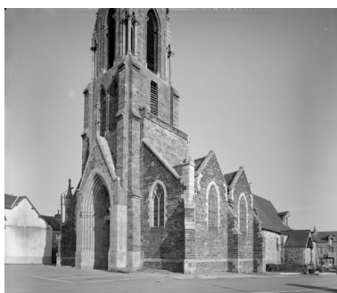
Elévation Sud-Ouest : vue générale Phot. François Dagorn IVR53_19673500132V
