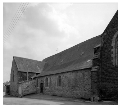
Elévation Nord, partie Est : vue générale Phot. François Dagorn IVR53_19703500318V
