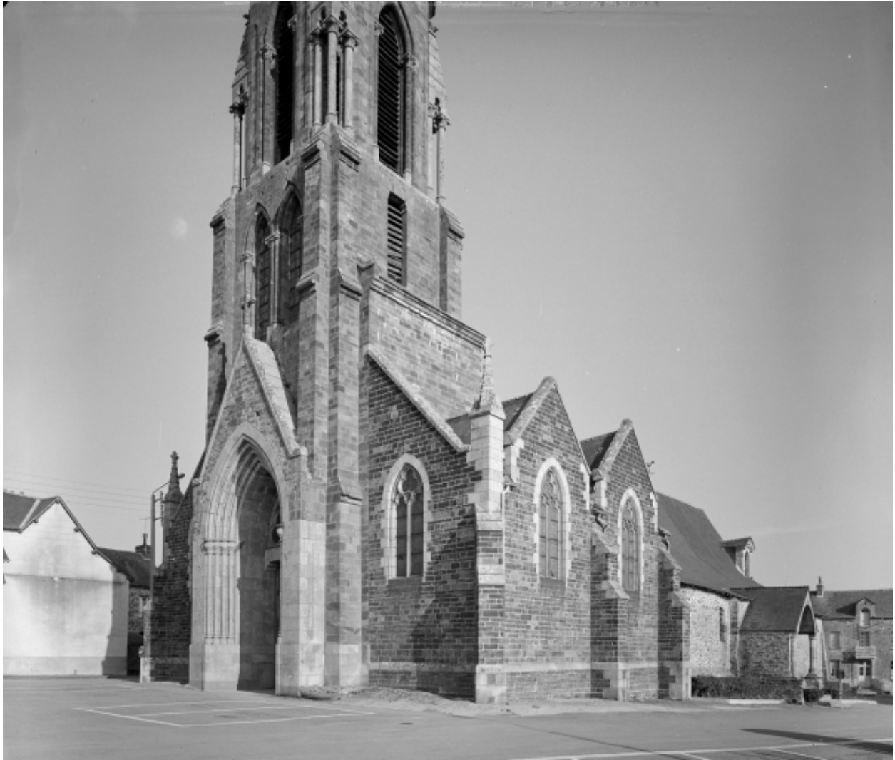
Elévation Sud-Ouest : vue générale
