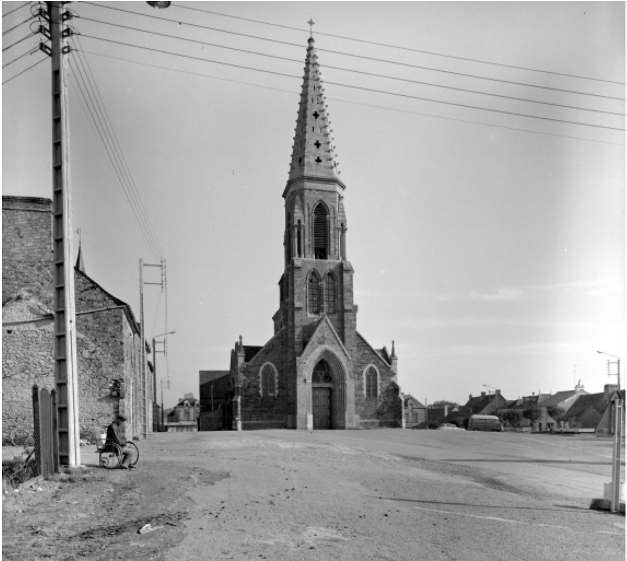
Elévation Ouest : vue générale
