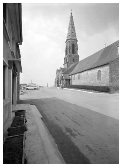
Elévation Sud-Est : vue générale Phot. François Dagorn IVR53_19703500319V
