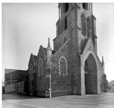
Elévation Nord-Ouest : vue générale Phot. François Dagorn IVR53_19673500131V
