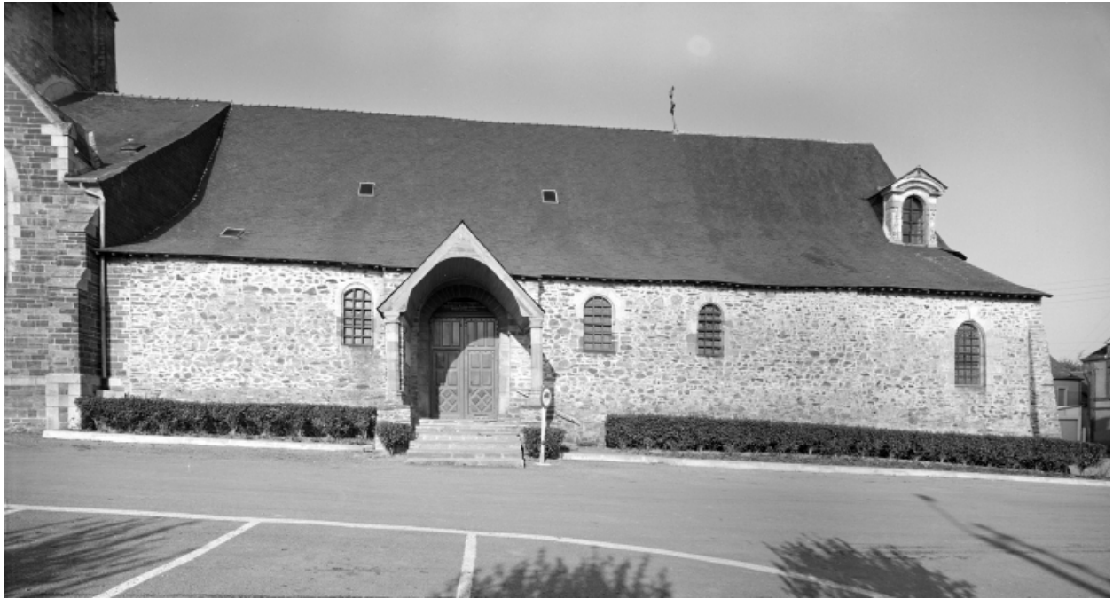
Elévation Sud, partie Est : vue générale
