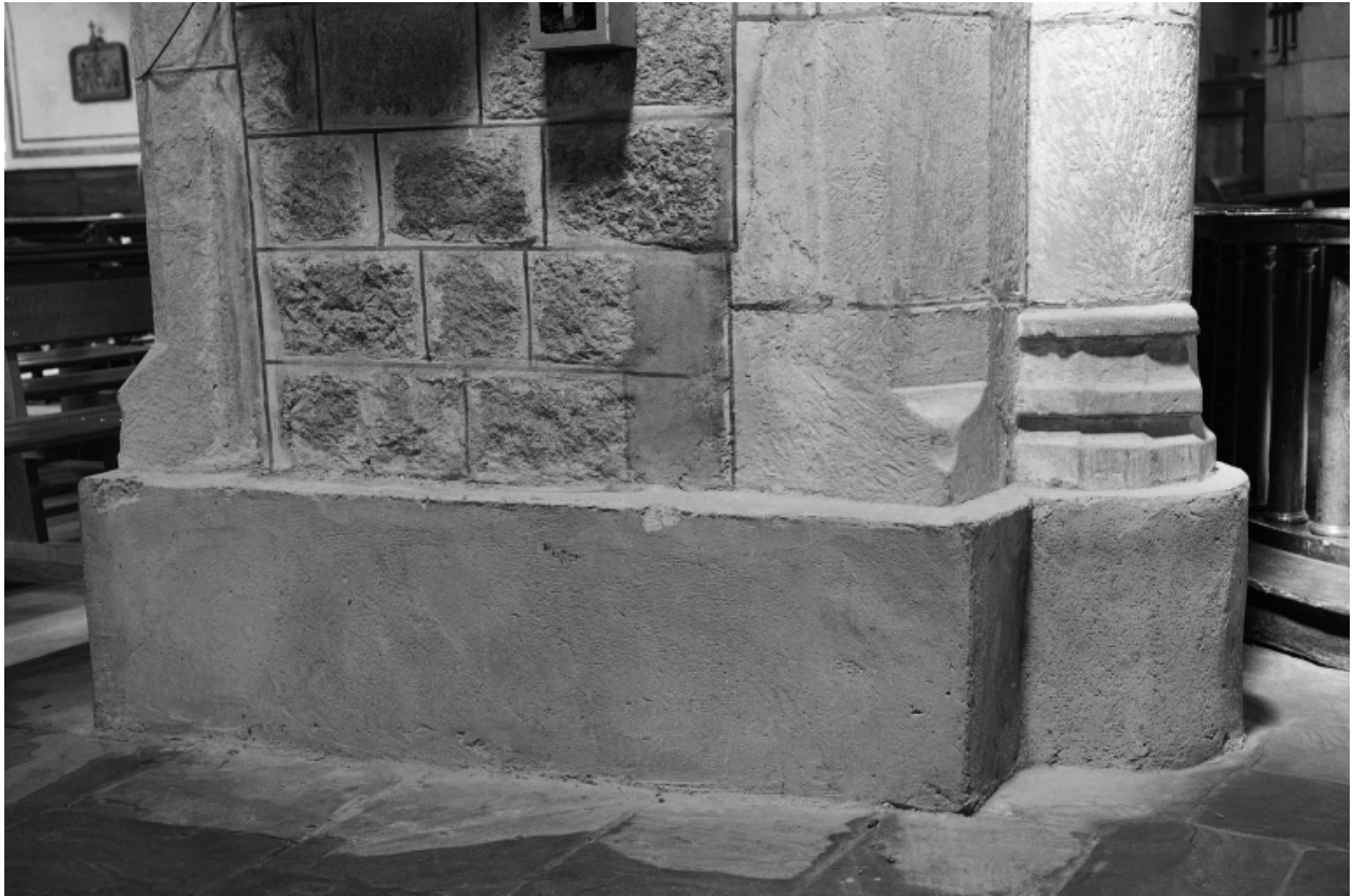
Choeur, base de la 5ème pile.
