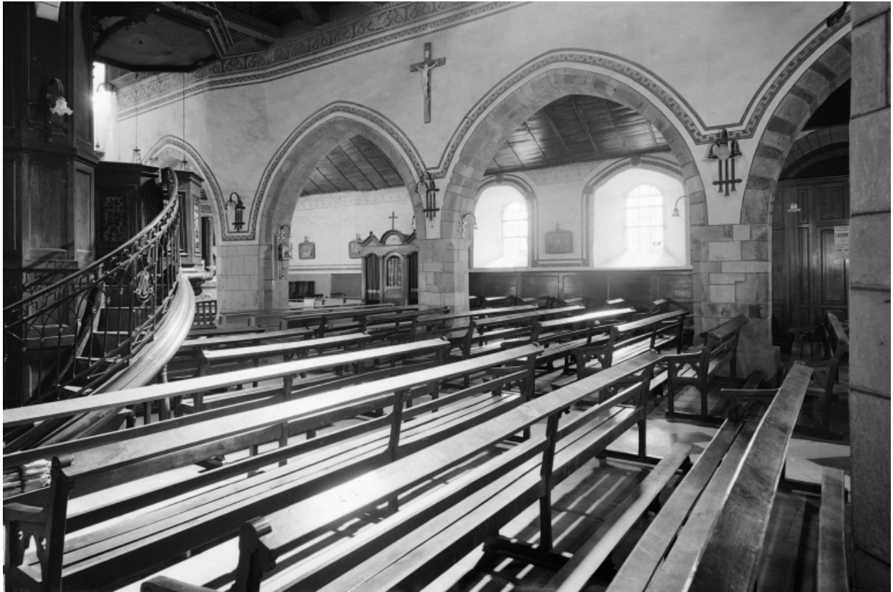
Nef, arcades sud, vue générale.
