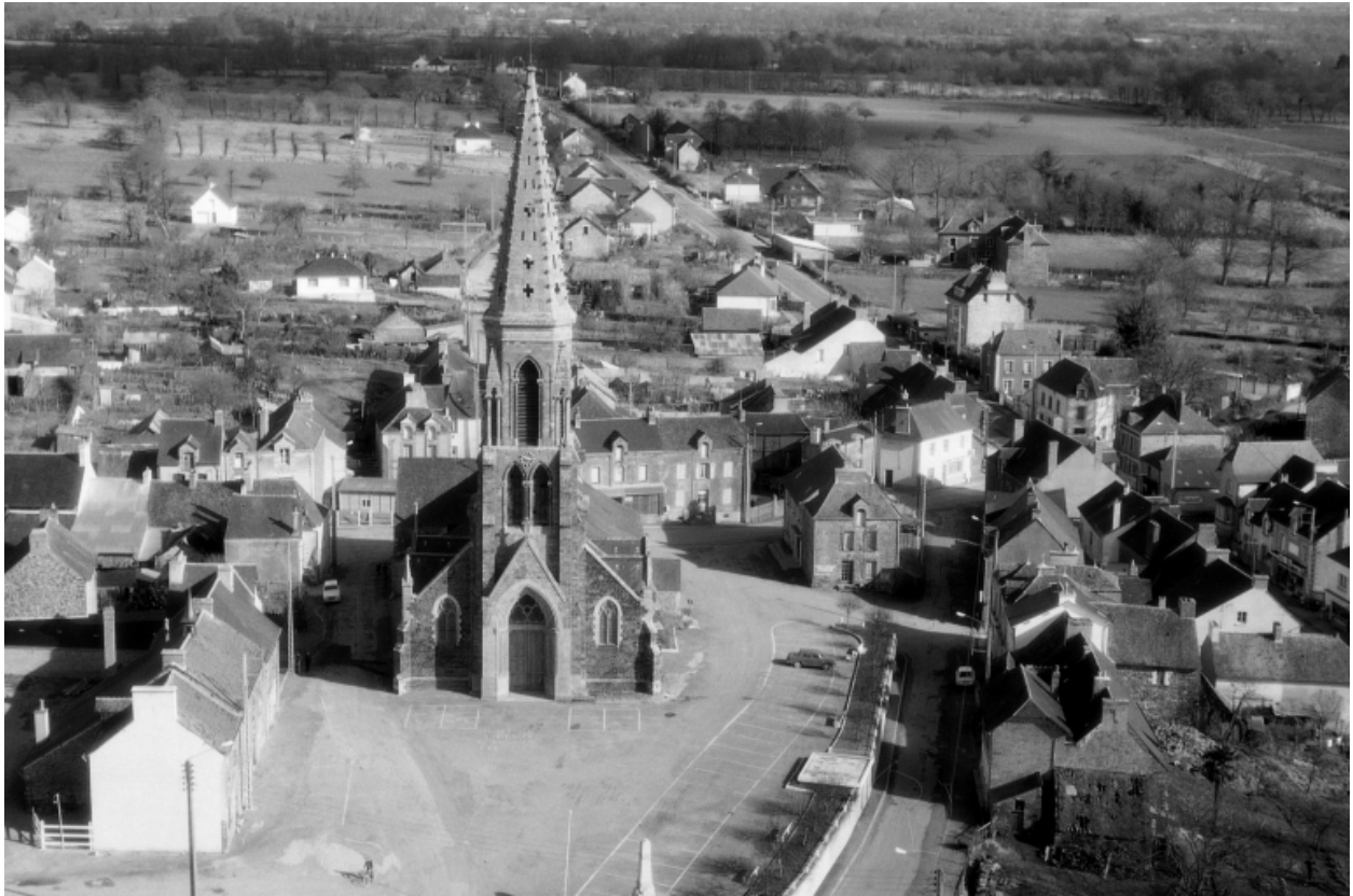
Elévation Ouest : vue aérienne.
