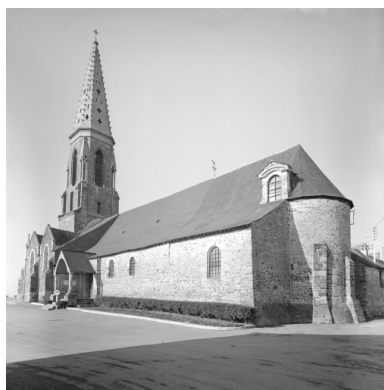
Elévation Sud-Est : vue générale Phot. François Dagorn IVR53_19673500133V
