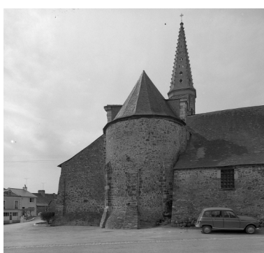
Chevet, vue prise du nord-ouest. Phot. François Dagorn IVR53_19703500321V
