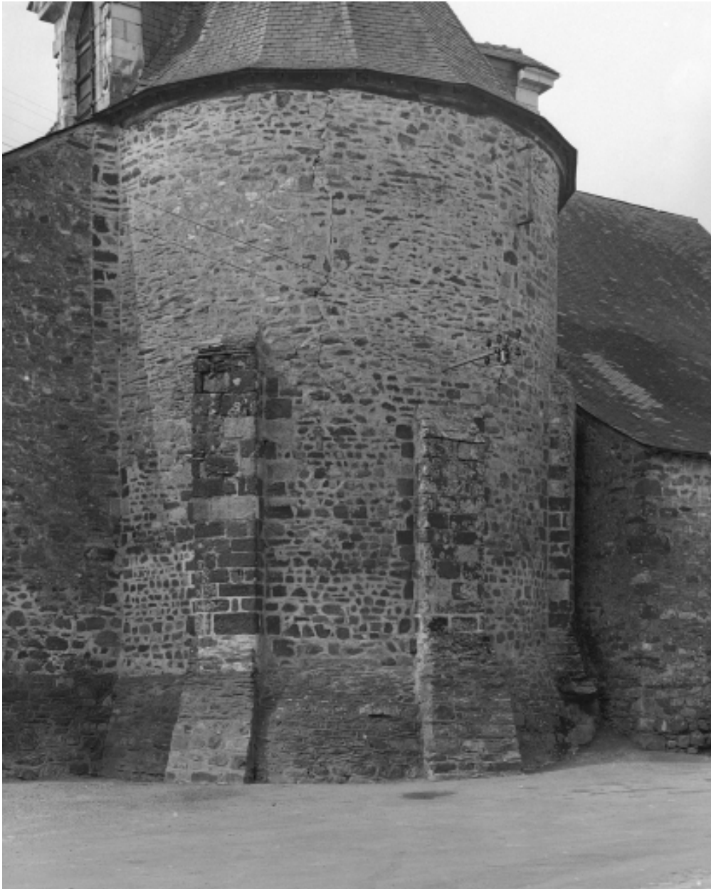
Chevet, vue de détail de l'abside.
