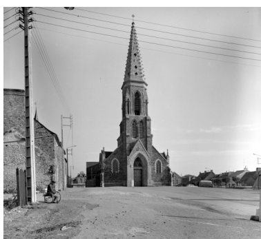
Elévation Ouest : vue générale Phot. François Dagorn IVR53_19673500129V
