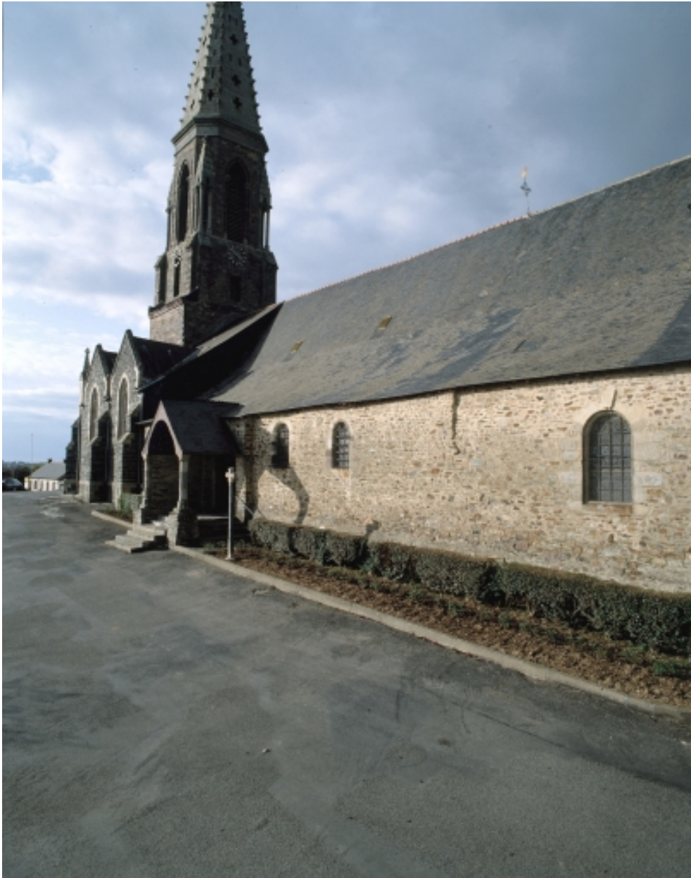
Elévation Sud-Ouest : vue générale
