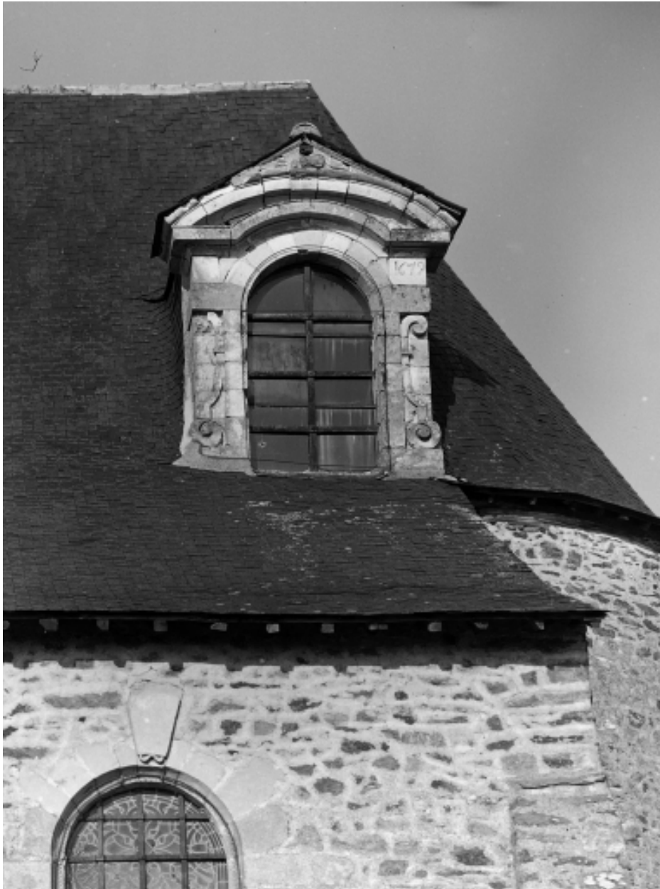
Lucarne sud-est, vue de détail.
