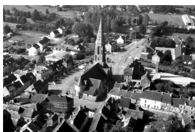
Elévation Est : vue aérienne. Phot. G.A.L.A.T. IVR53_19713500294V
