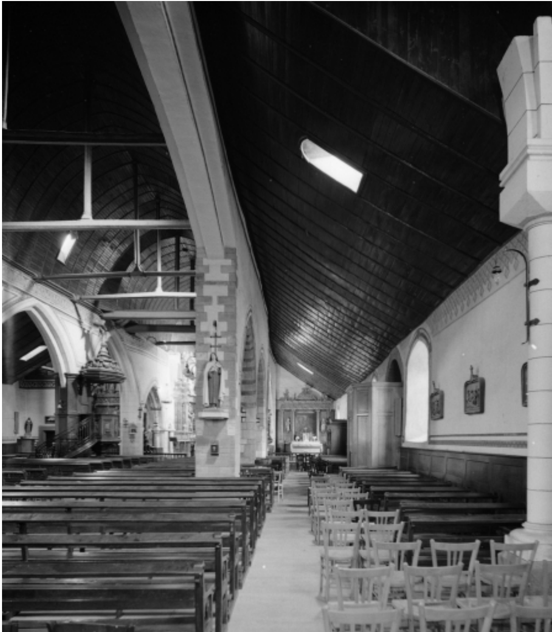
Bas-côté sud, vue vers l'est.
