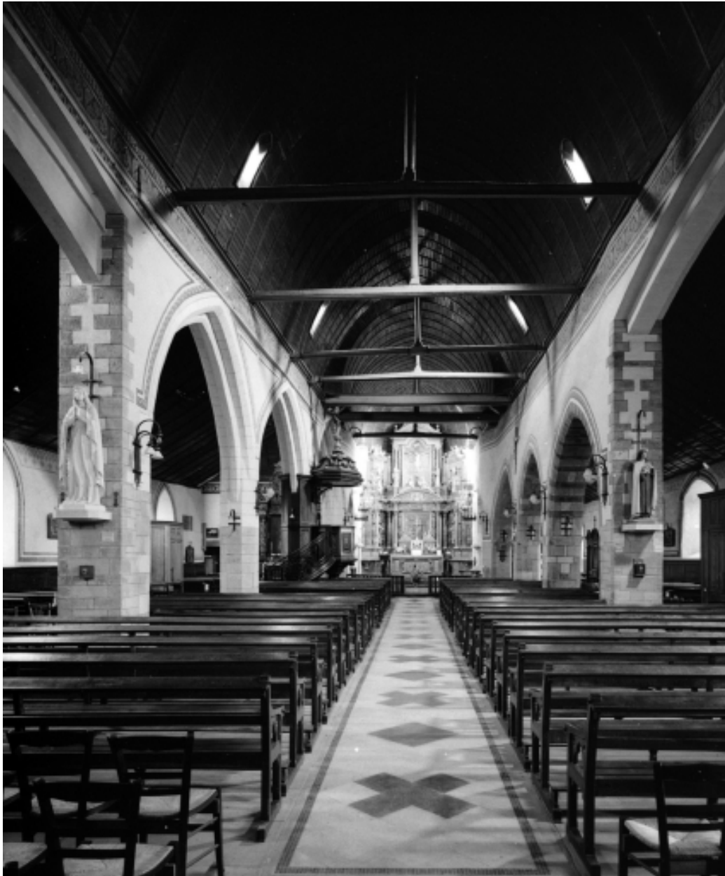
Intérieur : vue générale vers le chœur.
