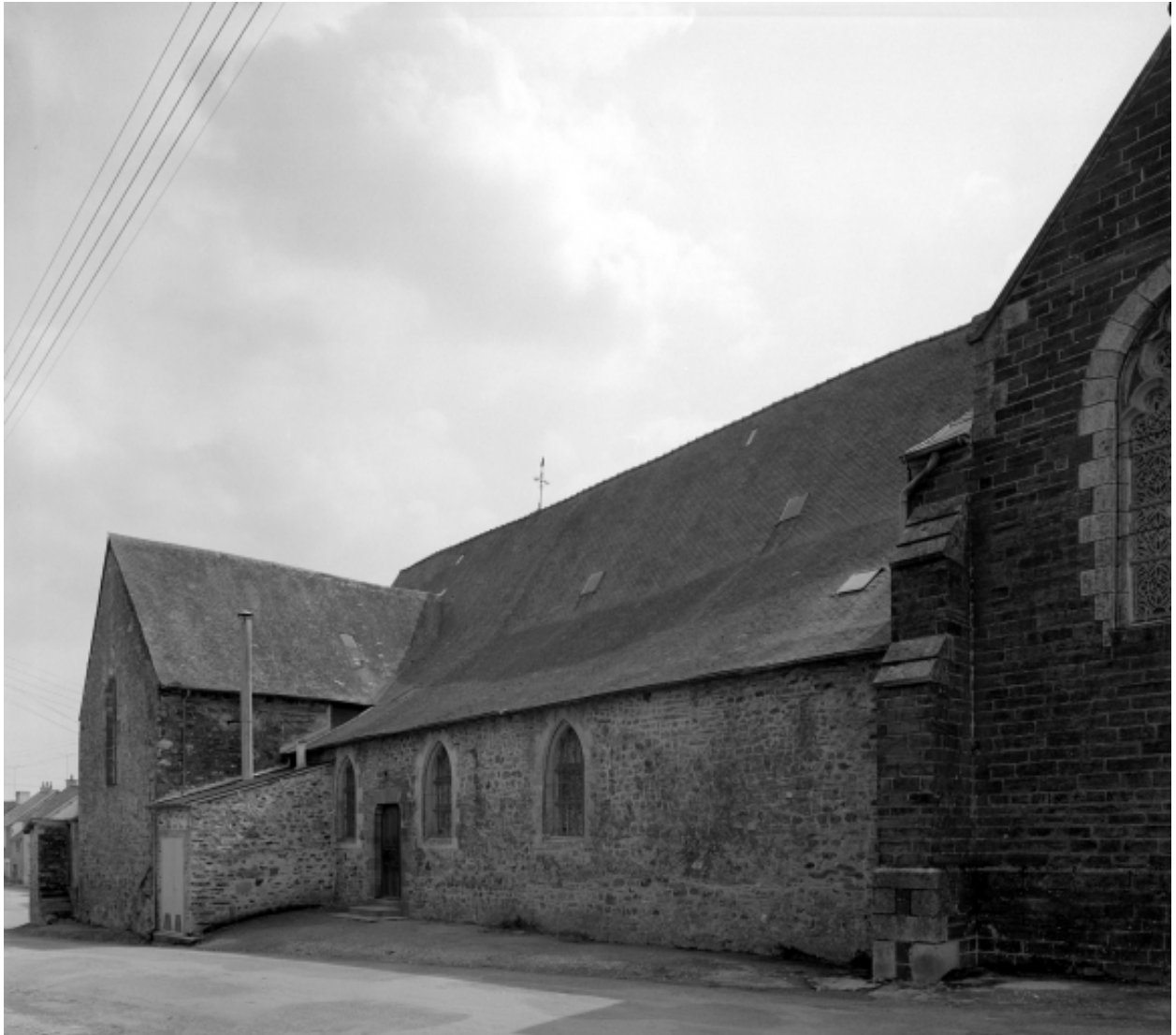
Elévation Nord, partie Est : vue générale
