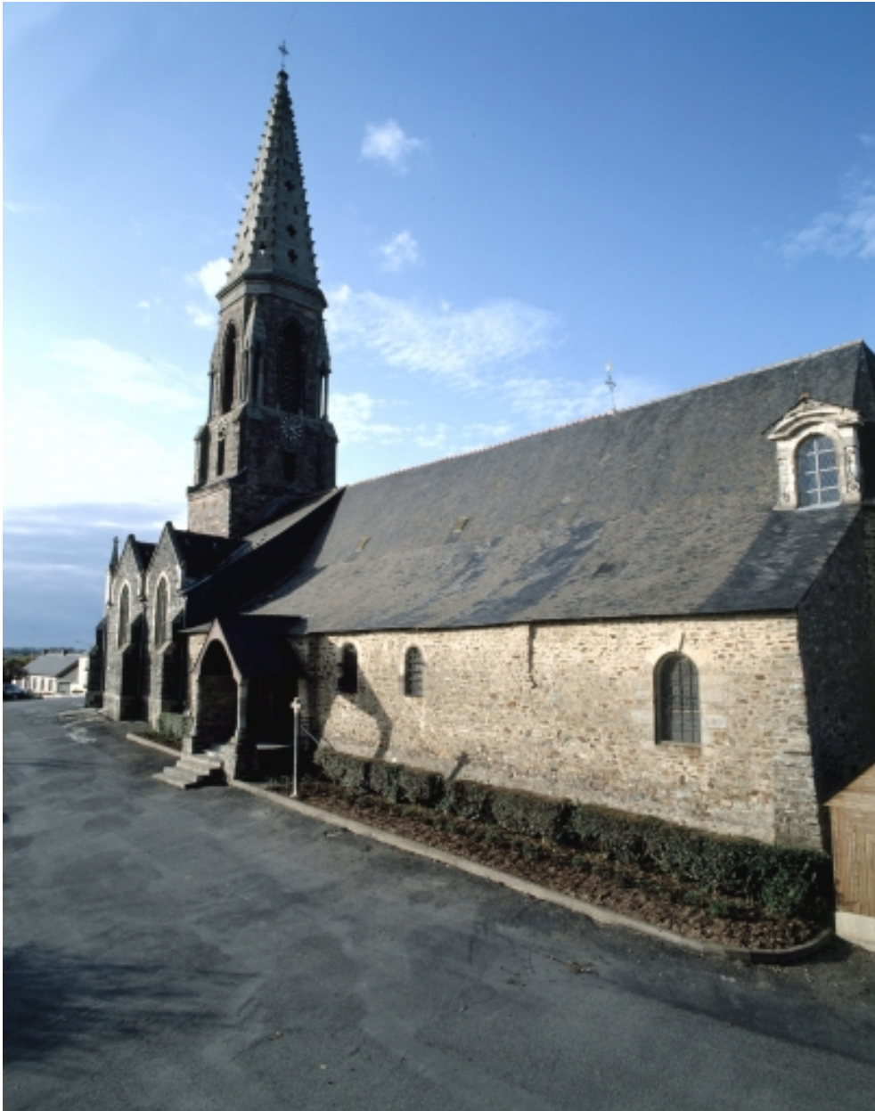
Elévation Sud-Ouest : vue générale
