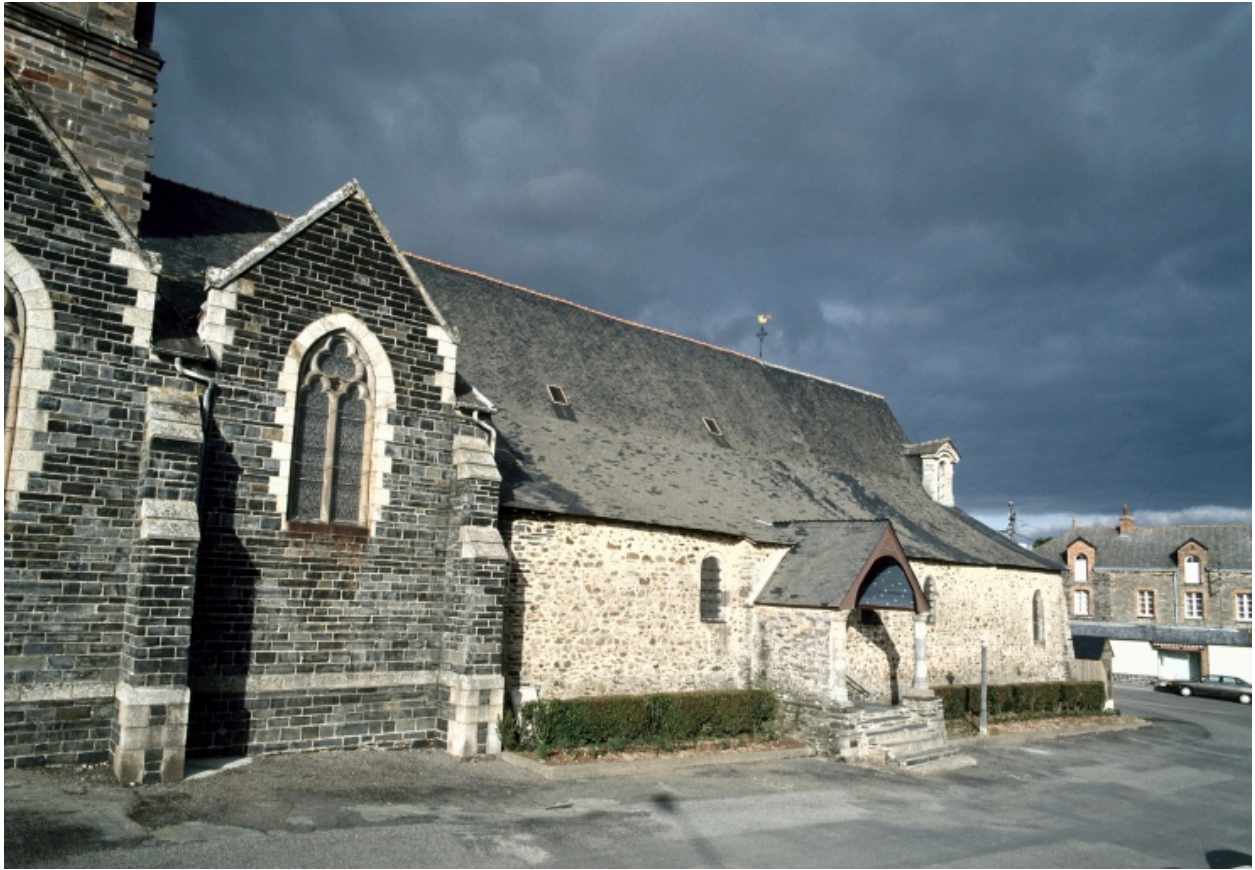
Elévation Sud-Ouest : vue générale
