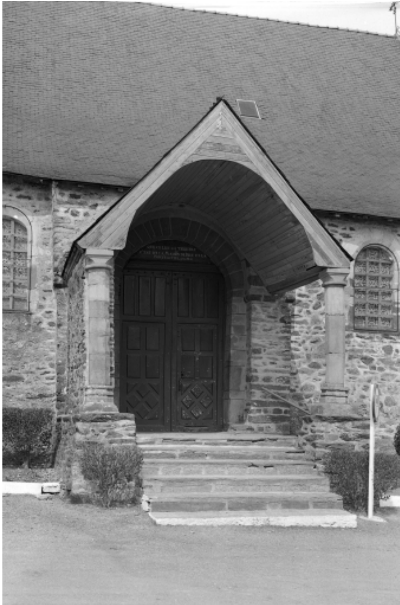
Façade sud, porche, vue générale.
