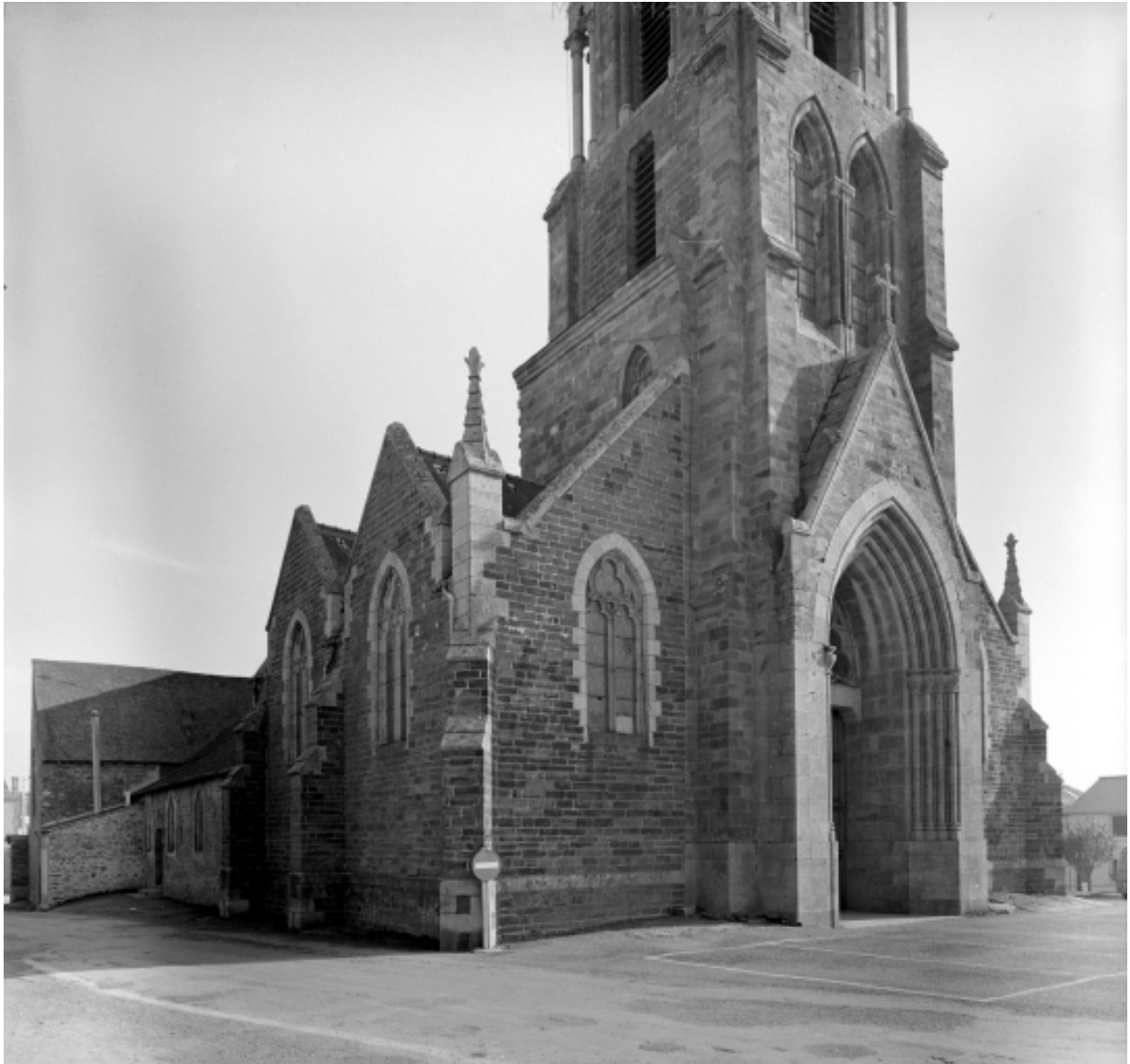
Elévation Nord-Ouest : vue générale
