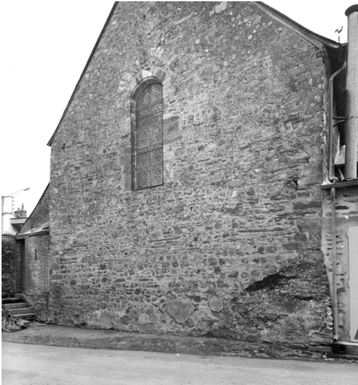
Transept, bras nord, fenêtre du pignon.
