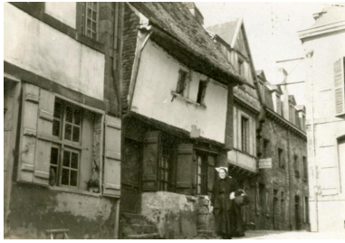
10 rue du Château : façade en pan de bois avec premier étage en encorbellement et étage sous combles. Phot. Gaston Demoulin IVR53_20255610036NUCA
