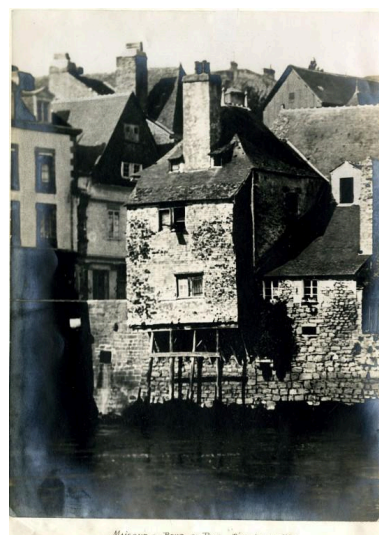
Square Castelbar : maison "du bout du pont" construite sur pilotis et détruite en 1932. Phot. Gaston Demoulin IVR53_20245610524NUC
