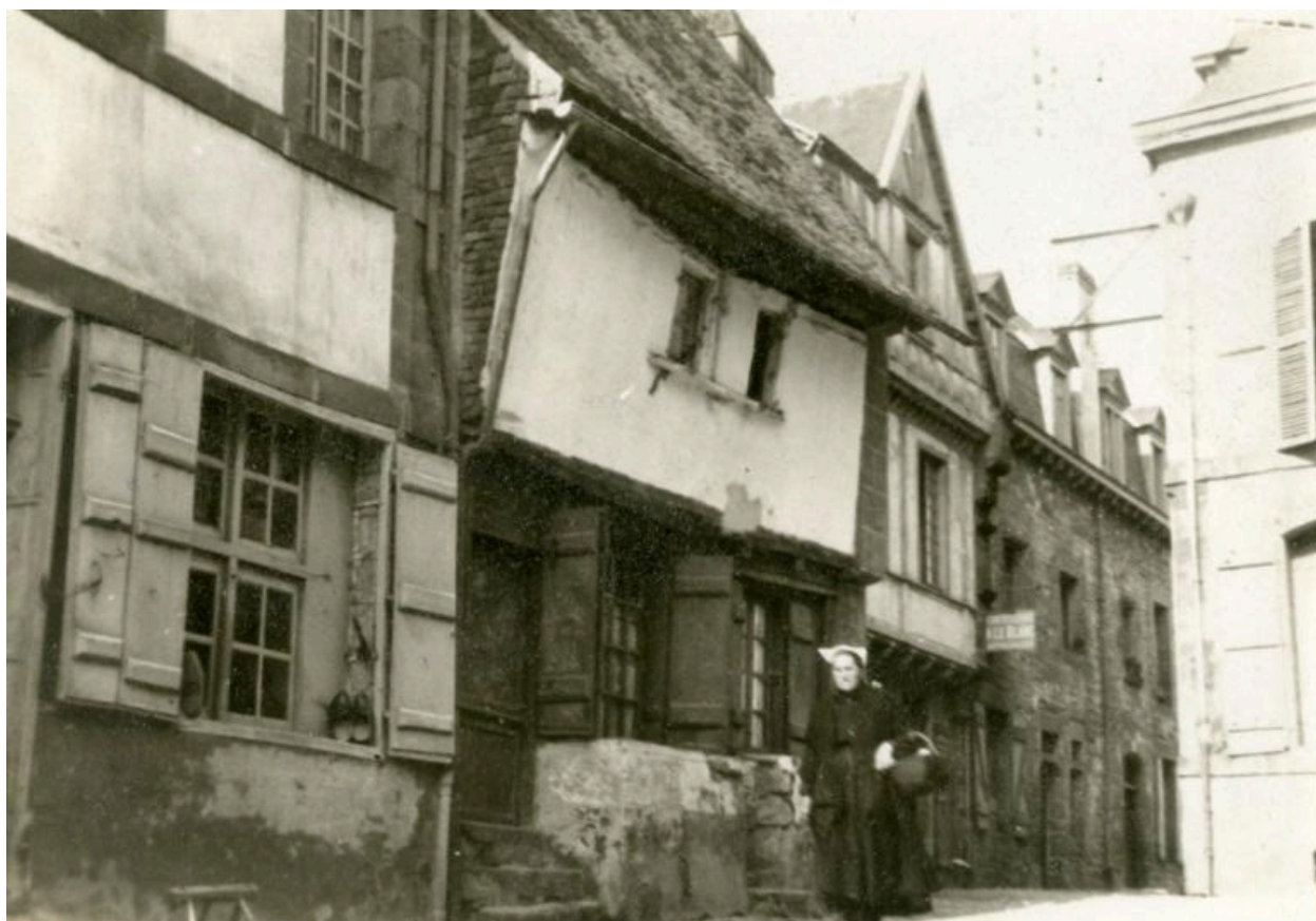
10 rue du Château : façade en pan de bois avec premier étage en encorbellement et étage sous combles.
