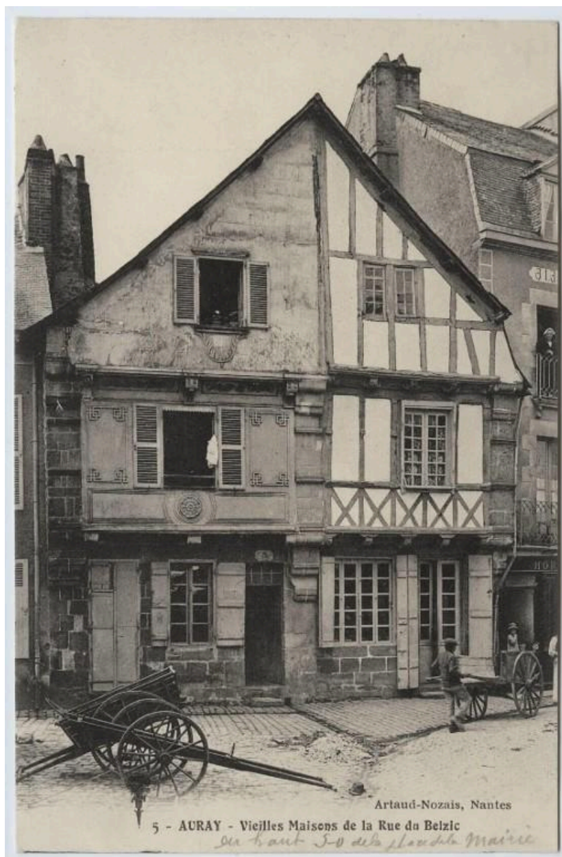
Façade d'une maison à encorbellement et à pans de bois ; des charettes se trouvent sur le côté de la rue.
