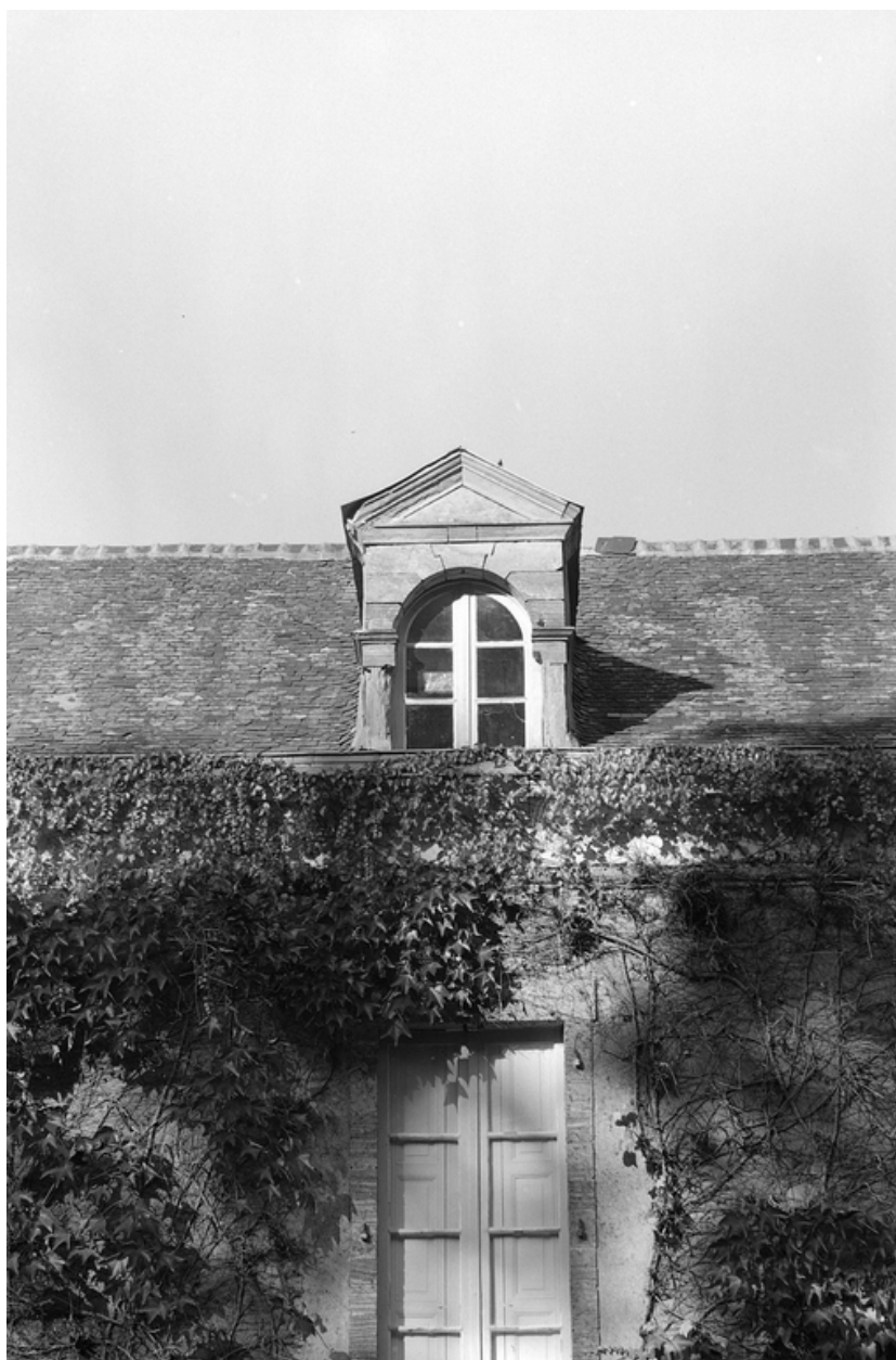
Façade sud, vue de détail d'une lucarne.
