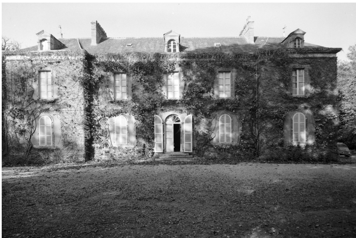
Façade sud, vue générale.
