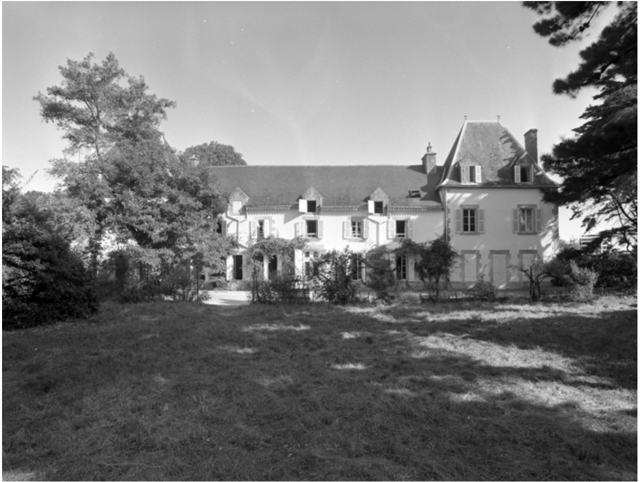
Vue générale sud
