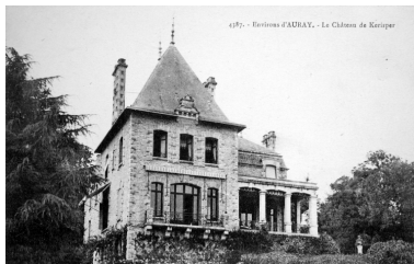
Corps de bâtiment moderne Phot. Elise Lauranceau IVR53_20045606276NUCB
