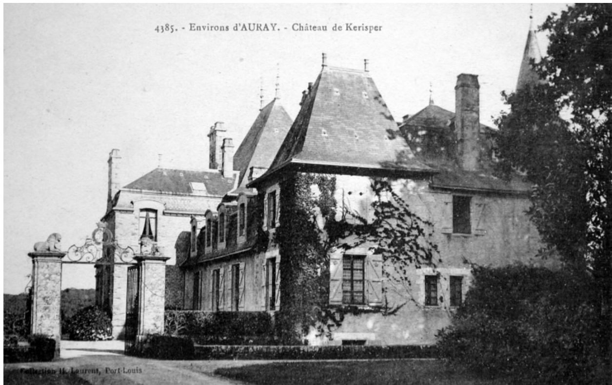
Vue générale depuis l'entrée
