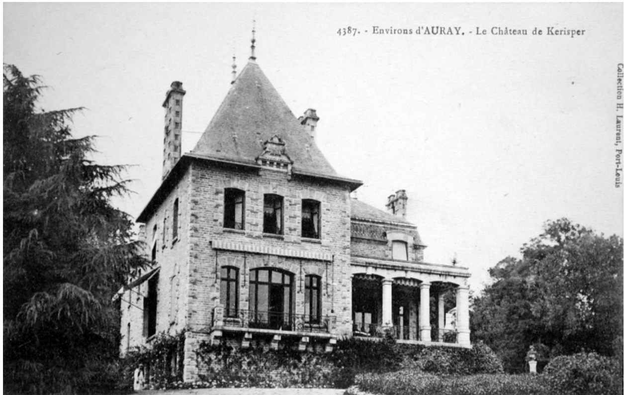
Corps de bâtiment moderne
