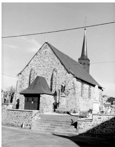
Elévation ouest, vue générale. Phot. Guy Artur, Phot. Norbert Lambart IVR53_19873500267X
