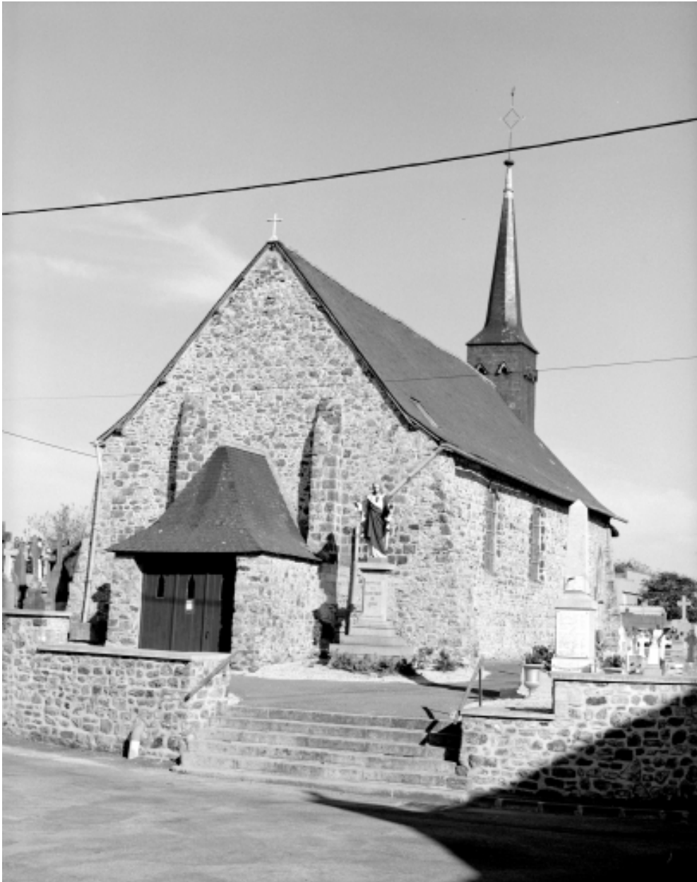
Elévation ouest, vue générale.
