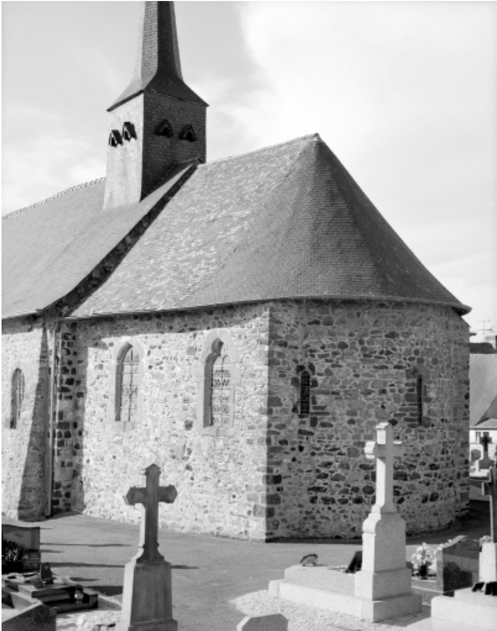
Chevet, élévation sud-est : vue générale.
