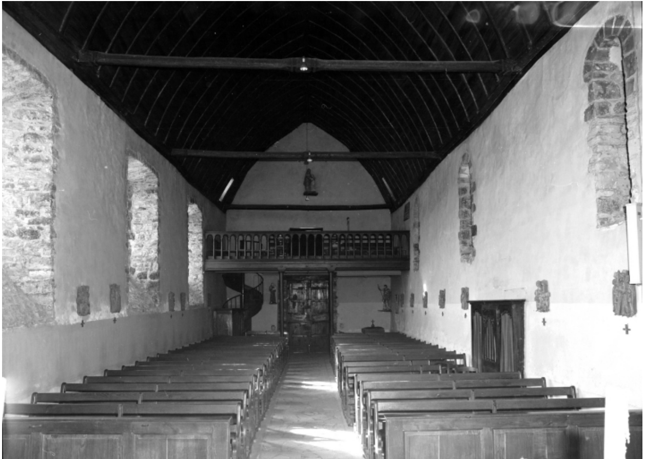
Intérieur, vue générale vers la nef.
