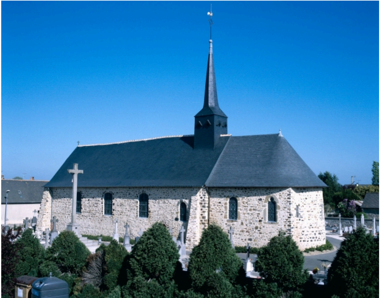
Vue générale de la façade latérale.
