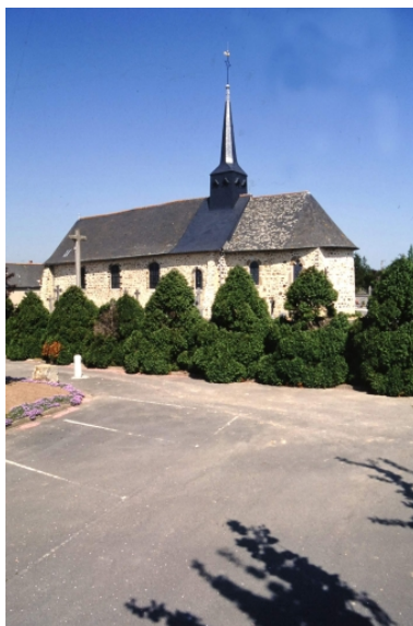
Vue d'ensemble prise du nord-est. Phot. Claude Quillivic IVR53_19943502503ZA
