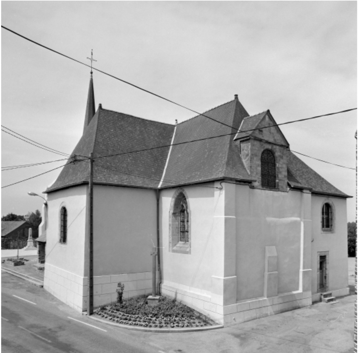
Elévation sud-est : vue générale
