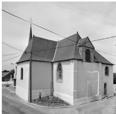
Elévation sud-est : vue générale Phot. Guy Artur, Phot. Norbert Lambart IVR53_19943501414X
