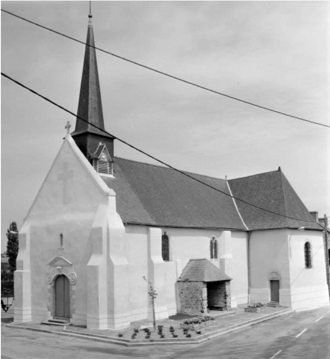
Elévation sud-ouest : vue générale
