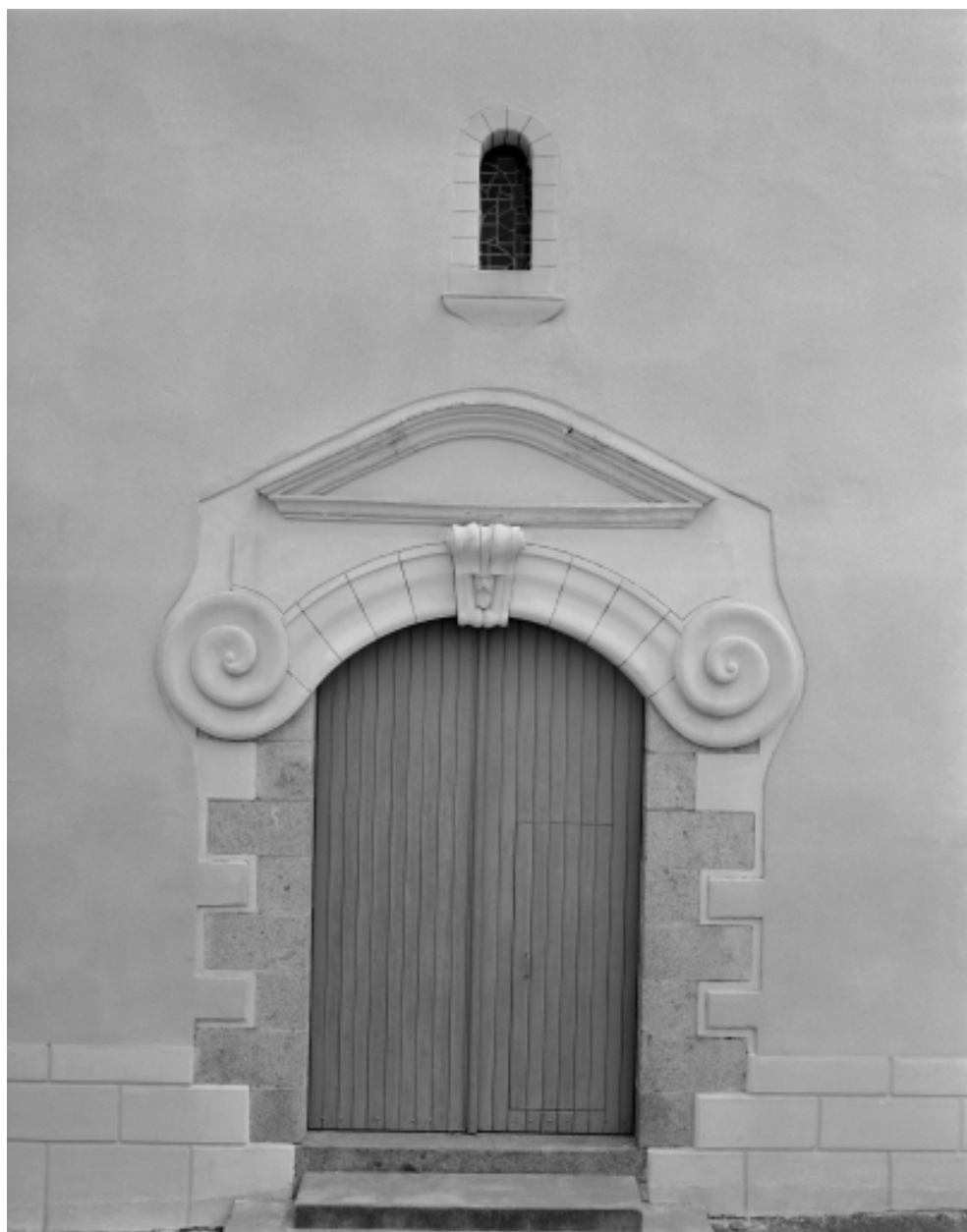
Elévation ouest, porte : vue générale
