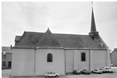
Elévation nord : vue générale Phot. Guy Artur, Phot. Norbert Lambart IVR53_19943501416X
