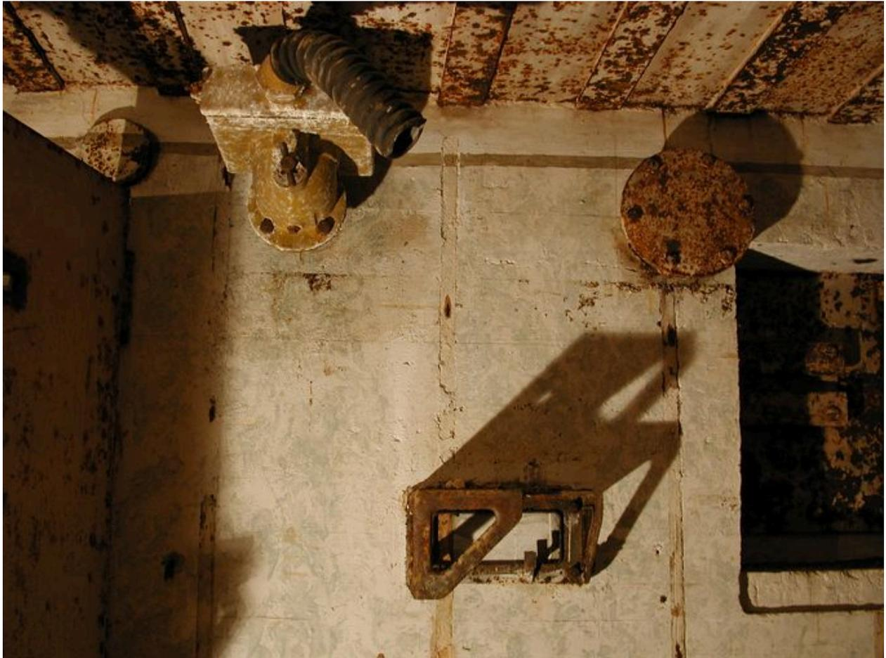
Support du ventilateur de la chambre de troupe gauche : modèle HES de 2,4 m<sup>3</sup> pouvant fonctionner avec deux manivelles ; filtre dépoussiéreur de couleur jaune en place
