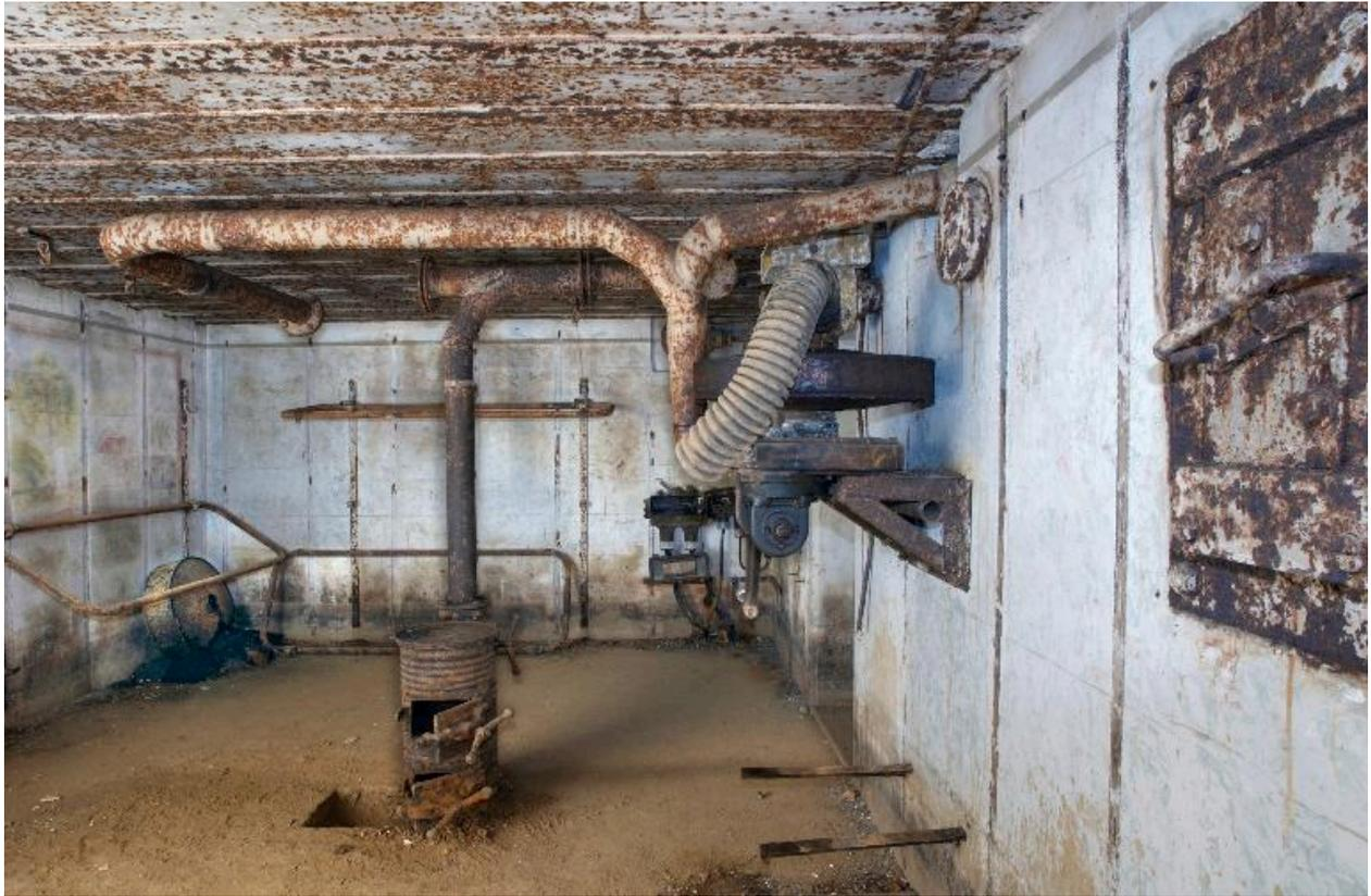
Vue de la chambre de troupe droite : lits - couchettes superposées, poêle, système de ventilation, boîtier de connexion téléphonique, créneau blindé..., photographie réalisée le 11 mai 2009
