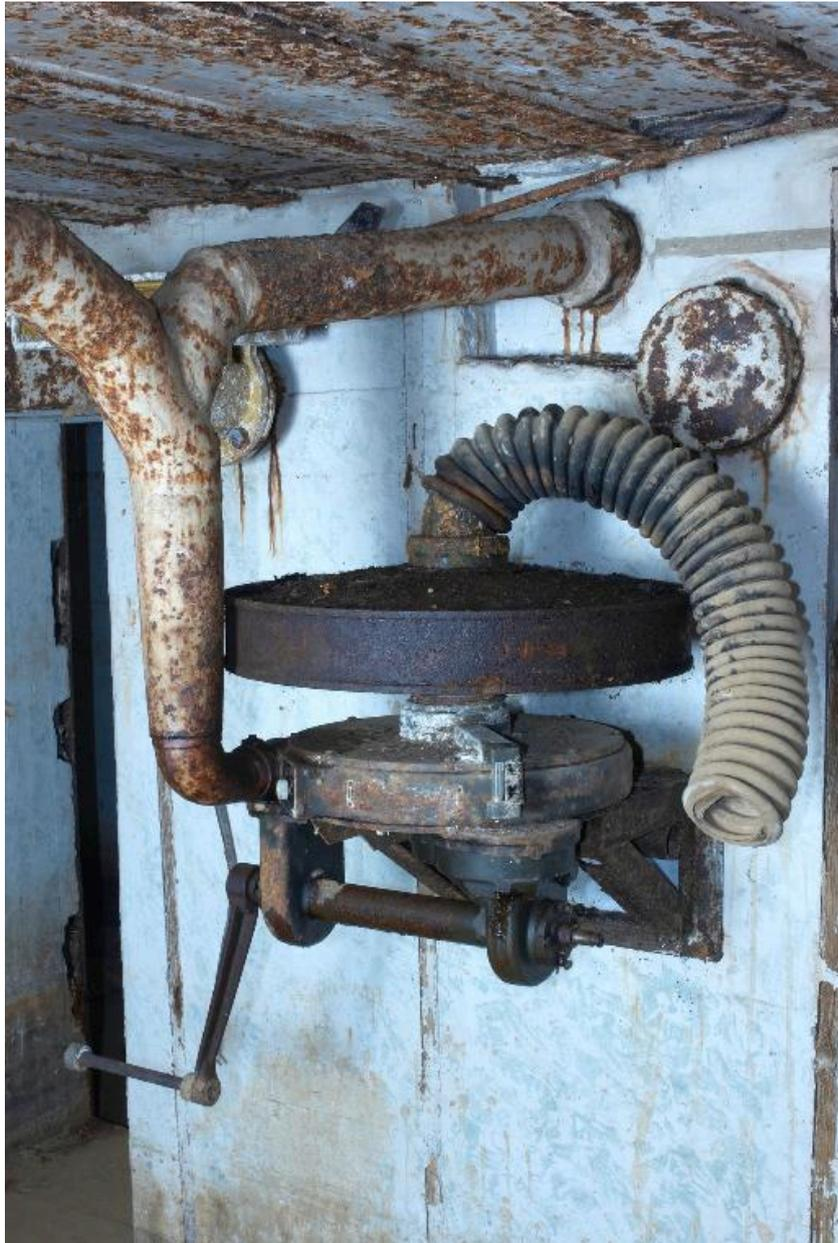
Vue du ventilateur avec son filtre en place (modèle HES de 2,4 m3 pouvant fonctionner avec deux manivelles),
