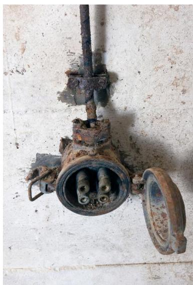
Poste d'observation/petite pièce latérale, prise téléphonique interne de jonction à 2 paires pour le raccordement d'un téléphone de fortification modèle 38 ("Tischfernsprecher 38 Siemens & Halske"),
