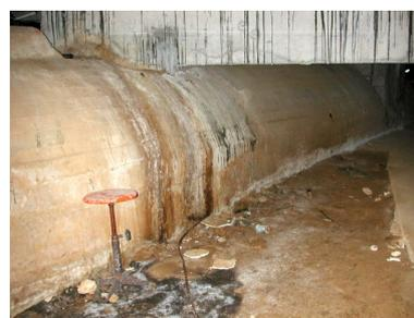
Détail de l'implantation des fondations du collège sur le bunker : la poutre en béton armé du rez-de-chaussée repose sur la dalle de couverture
