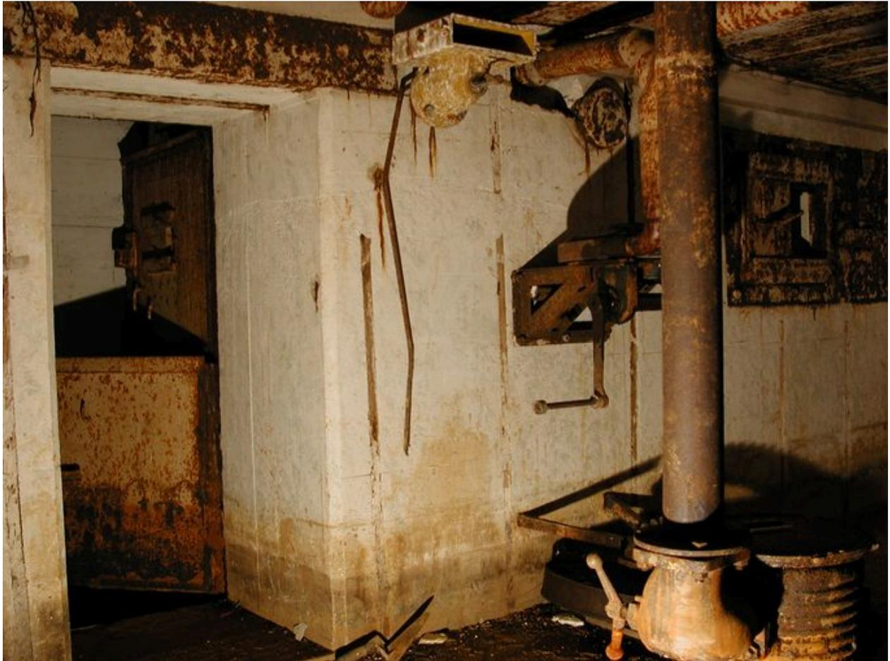
Vue de la chambre de troupe droite : entrée du poste d'observation avec sa porte blindée (modèle à deux vantaux de type 434P01 et guichet observateur), système de ventilation, filtres...
