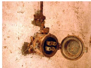
Poste d'observation/petite pièce latérale, prise téléphonique interne de jonction à 2 paires pour le raccordement d'un téléphone de fortification modèle 38 ("Tischfernsprecher 38 Siemens & Halske")
