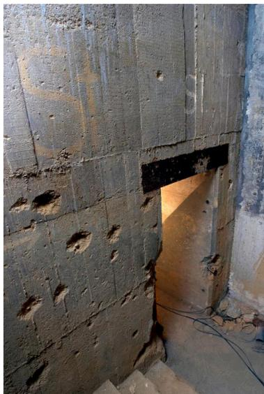
Entrée actuelle du bunker surmontée de marquages "St.", abréviation pour "Ständig Ausbau", construction permanente, c'est à dire à l'épreuve des bombes et étanche aux attaques au gaz, photographie réalisée le 11 mai 2009. On distingue également des impacts de balle sur le béton...
