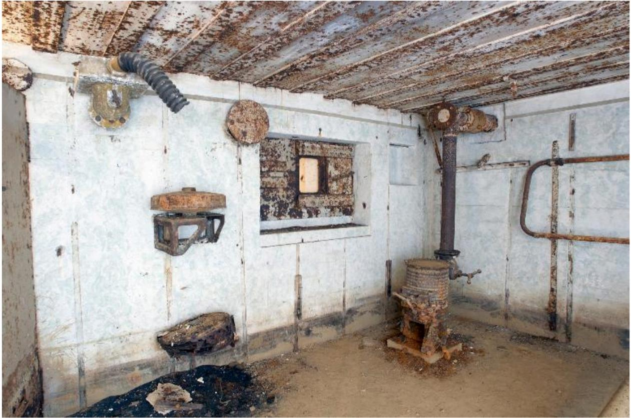
Vue de la chambre de troupe gauche : créneau blindé, poêle, lits - couchettes superposées, vestiges du système de ventilation, photographie réalisée le 11 mai 2009
