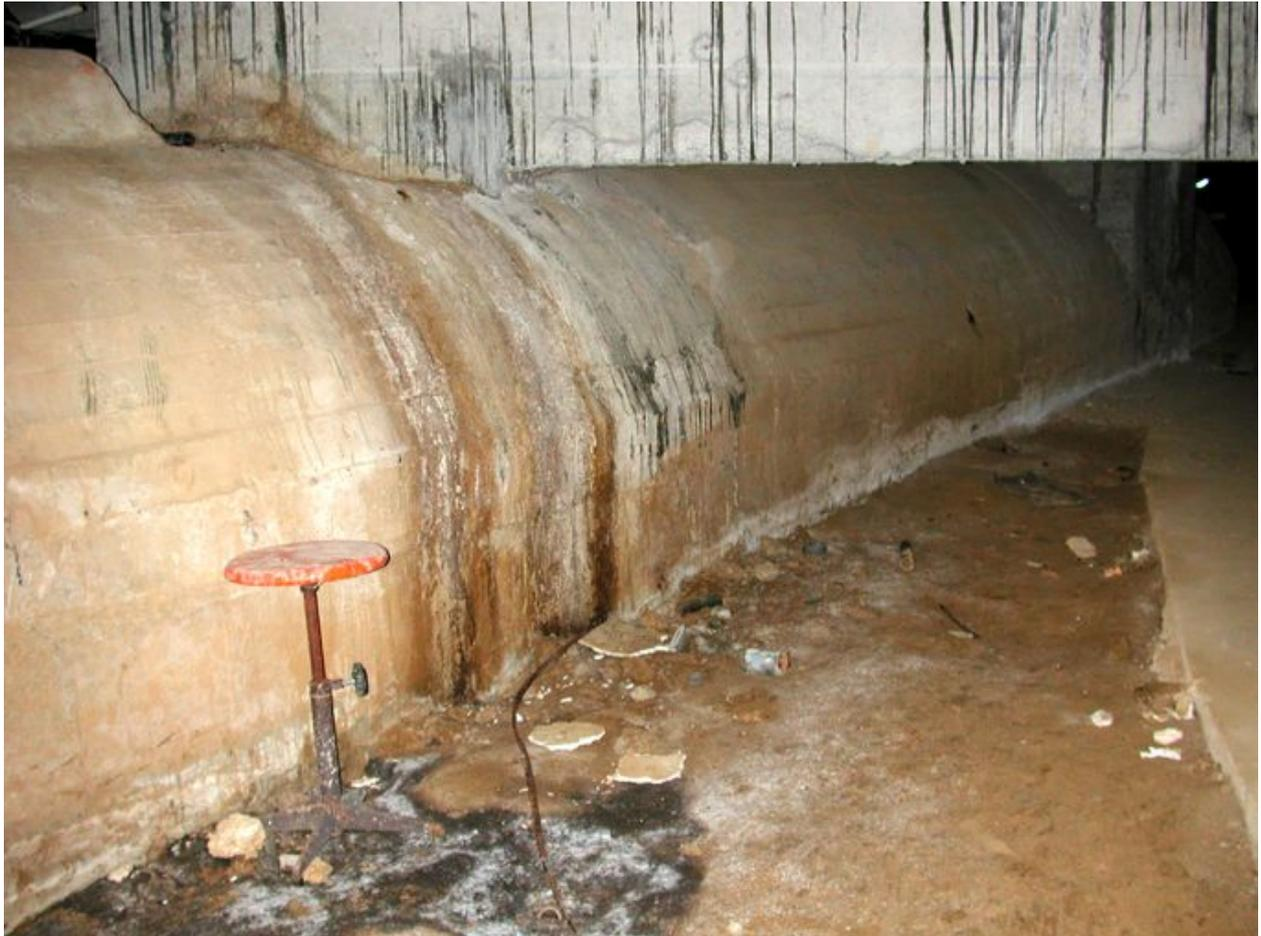
Détail de l'implantation des fondations du collège sur le bunker : la poutre en béton armé du rez-de-chaussée repose sur la dalle de couverture
