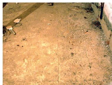
Vue de la dalle en béton du sol imitant un carrelage...
