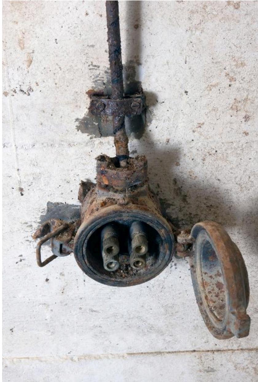
Poste d'observation/petite pièce latérale, prise téléphonique interne de jonction à 2 paires pour le raccordement d'un téléphone de fortification modèle 38 ("Tischfernsprecher 38 Siemens & Halske"), photographie réalisée le 11 mai 2009
