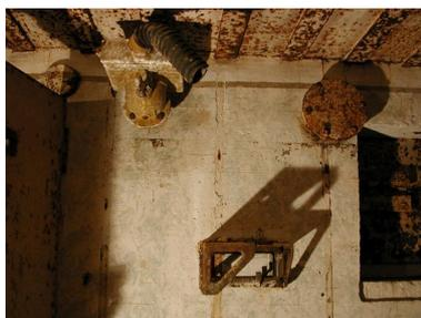
Support du ventilateur de la chambre de troupe gauche : modèle HES de 2,4 m3 pouvant fonctionner avec deux manivelles ; filtre dépoussiéreur de couleur jaune en place
