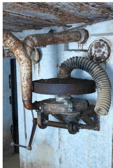
Vue du ventilateur avec son filtre en place (modèle HES de 2,4 m3 pouvant fonctionner avec
