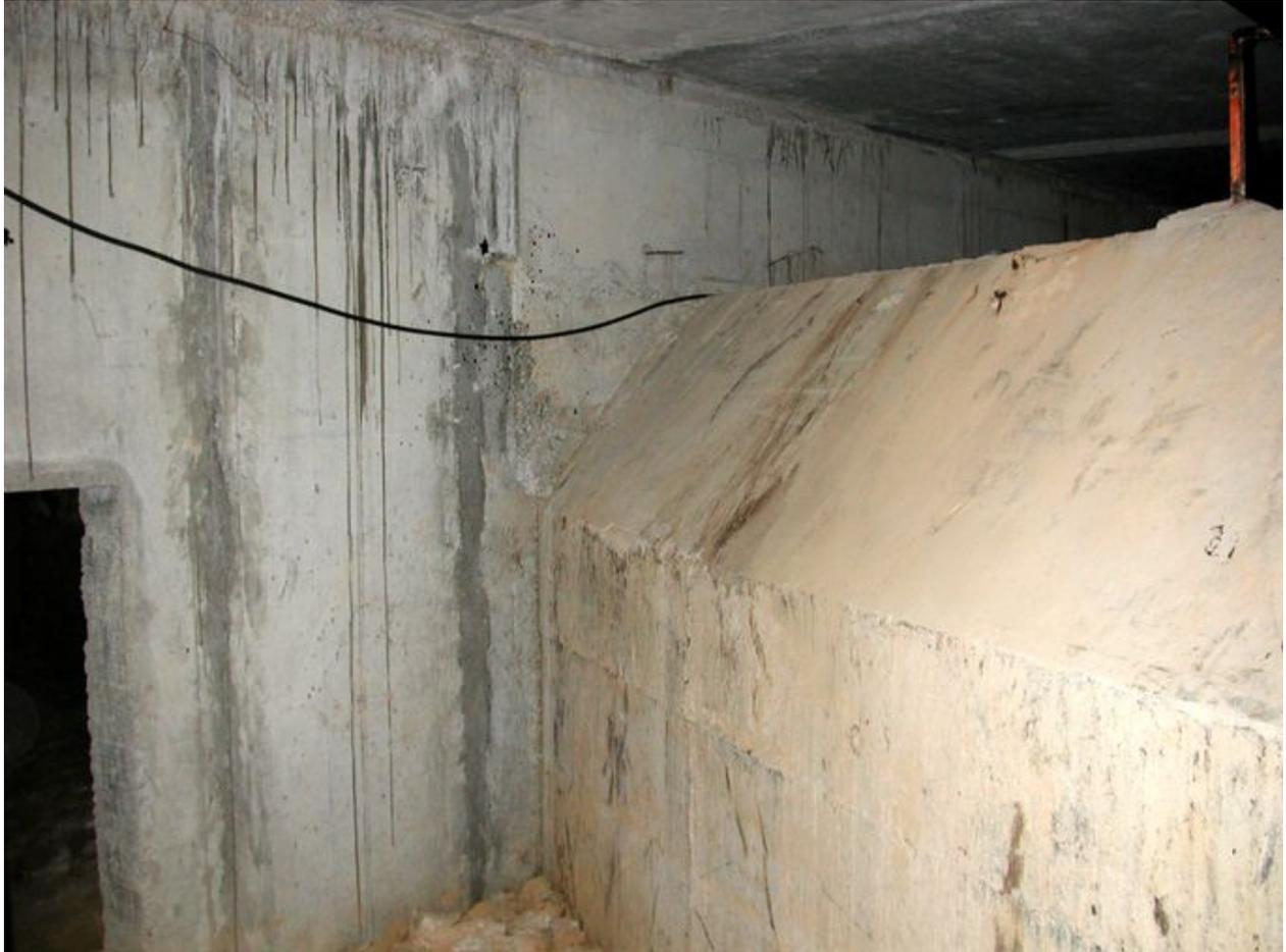
Détail de l'implantation des fondations du collège sur le bunker
