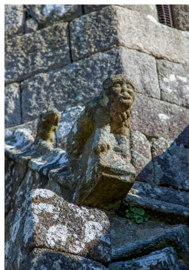
Crossette sud du pignon occidental (réemploi), église paroissiale, Le membre de Pont-Melvez (Pont-Melvez) IVR53_20152211886NUCA
