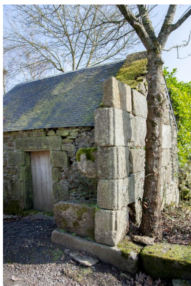
Vestiges du porche monumental du manoir commandal, Le membre de Pont-Melvez (Pont-Melvez) IVR53_20152211878NUCA
