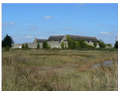
Vue générale de la ferme de la Villeneuve Phot. Johan Vincent IVR53_20075605711NUCA
