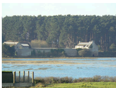
Ferme de la Villeneuve avec l'anse Mancel au premier plan Phot. Johan Vincent IVR53_20075605713NUCA
