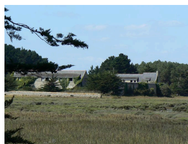
Ferme de la Villeneuve Phot. Johan Vincent IVR53_20075605712NUCA
