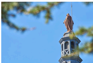
Vue de dos Phot. Léna Leroy IVR53_20243500914NUCA
