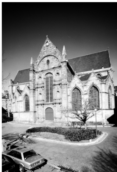
Elévation sud, vue générale Phot. Auteur inconnu IVR53_19953500225V
