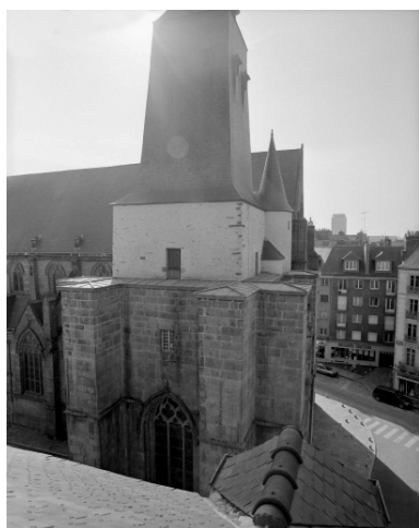
Elévation nord, clocher : vue générale Phot. Guy Artur, Phot. Norbert Lambart IVR53_19953500207X
