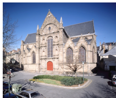
Elévation sud, vue générale Phot. Guy Artur, Phot. Norbert Lambart IVR53_19953500082VA
