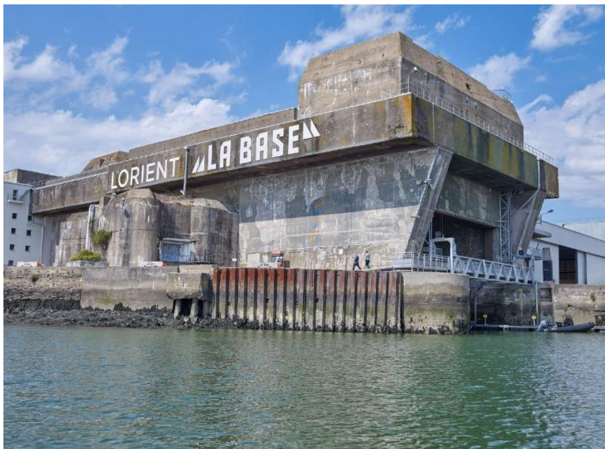
Vue générale depuis le sud. Le bunker - casemate est accolé à l'ouest de l'alvéole du slipway du bunker KI
