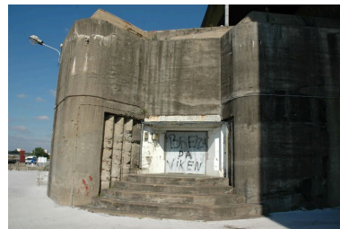
Vue de l'embrasure à ébrasement extérieur à redan (pour éviter les coups d'embrasure) Phot. Guillaume Lécueillier IVR53_20055603542NUCA
