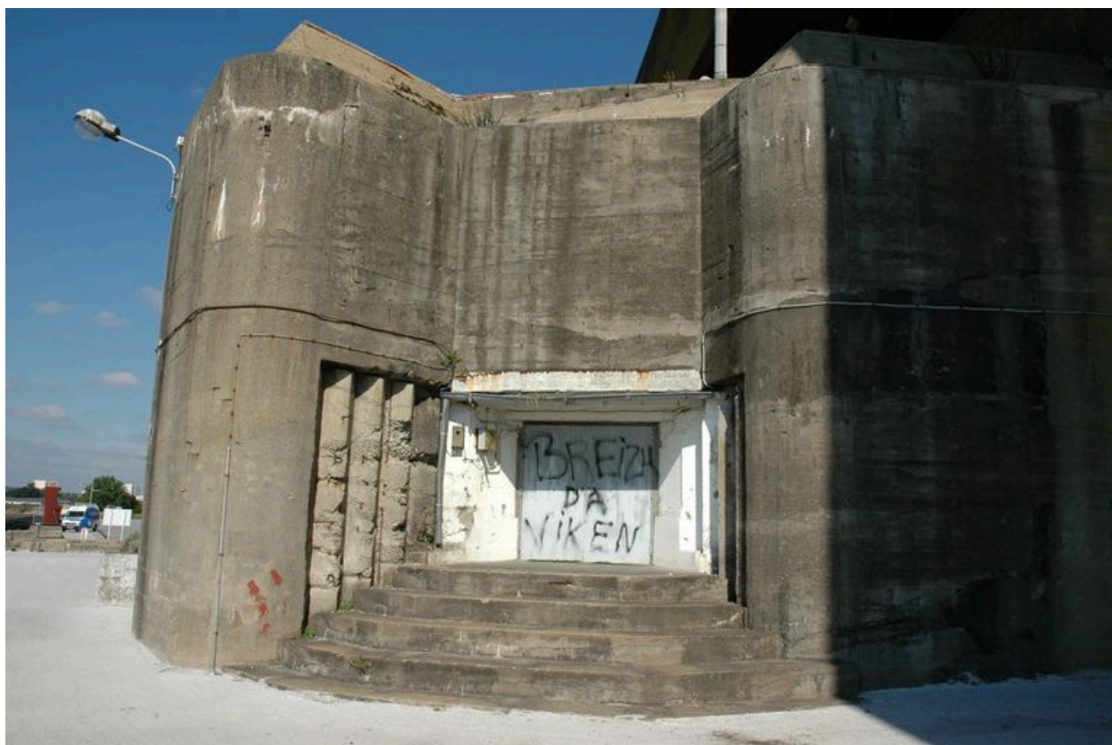
Vue de l'embrasure à ébrasement extérieur à redan (pour éviter les coups d'embrasure)
