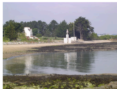
Vue de l'amer sur la côte de l'anse de l'Île Longue Phot. Clotilde Buhot IVR53_20062908526NUCA
