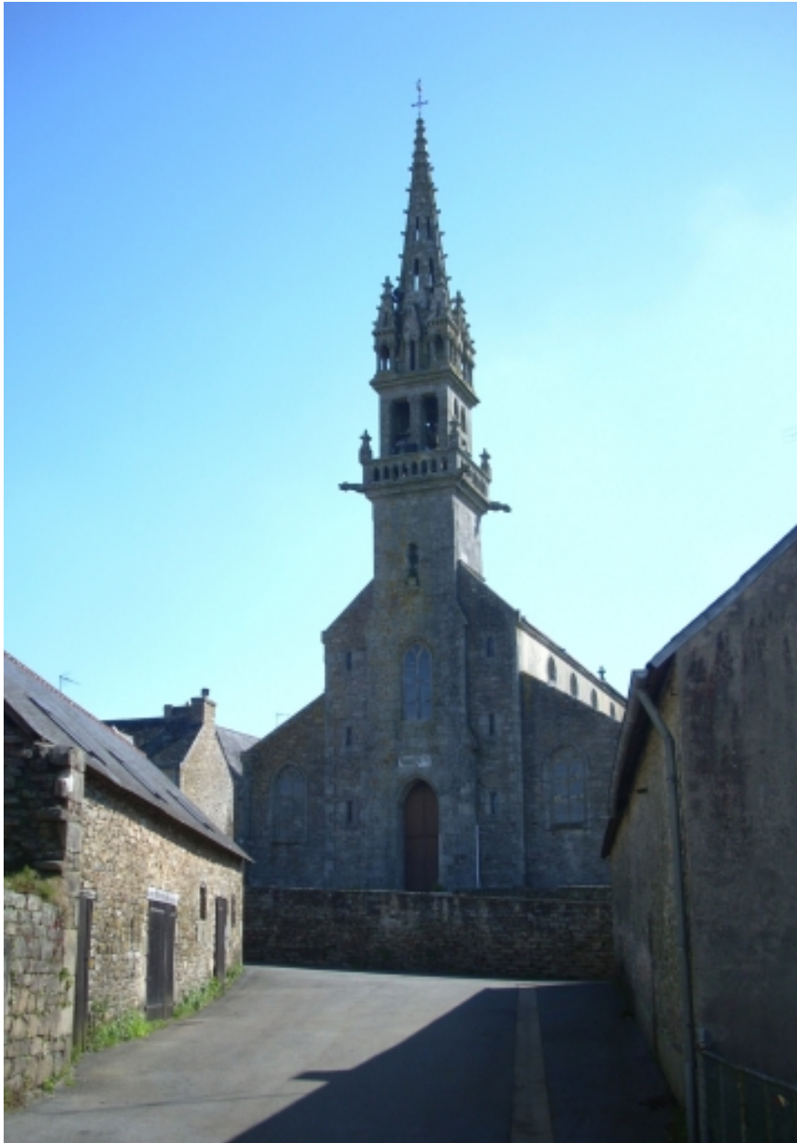
Saint-Thurien, église paroissiale Saint-Thurien : vue générale ouest
