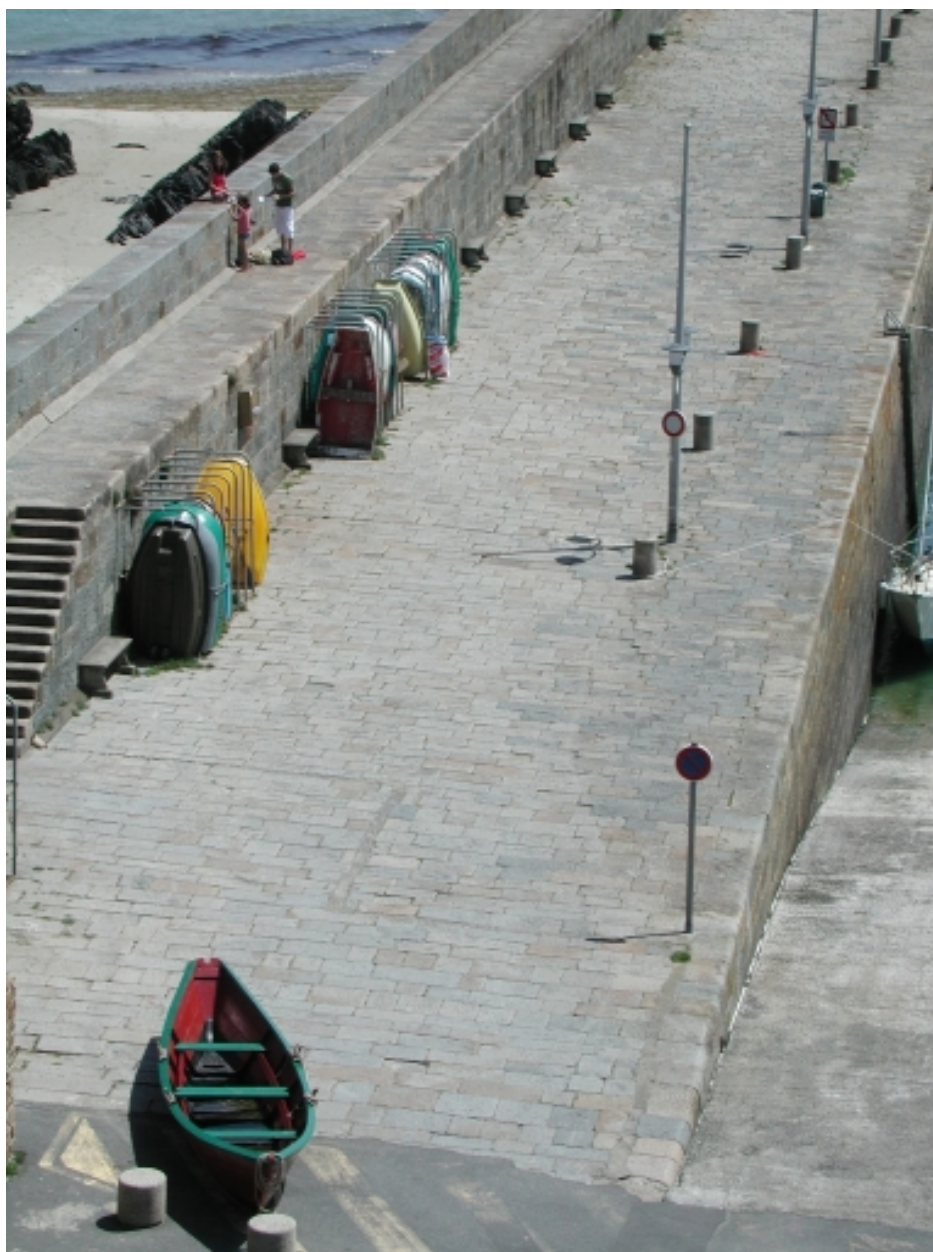
Vue de la jetée de Penthièvre : remarquer le pavage des pierres de revêtement et les bolards d'amarrage en granite
