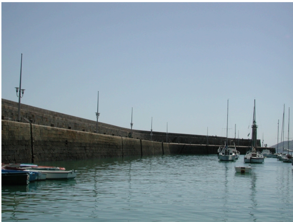
La jetée de Penthièvre à marée haute avec le fanal à l'extrémité
