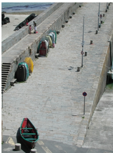
Vue de la jetée de Penthièvre : remarquer le pavage des pierres de revêtement et les bolards d'amarrage en granite Phot. Guy Prigent IVR53_20072206481NUCA
