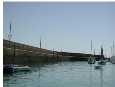
La jetée de Penthièvre à marée haute avec le fanal à l'extrémité Phot. Guy Prigent IVR53_20072206482NUCA
