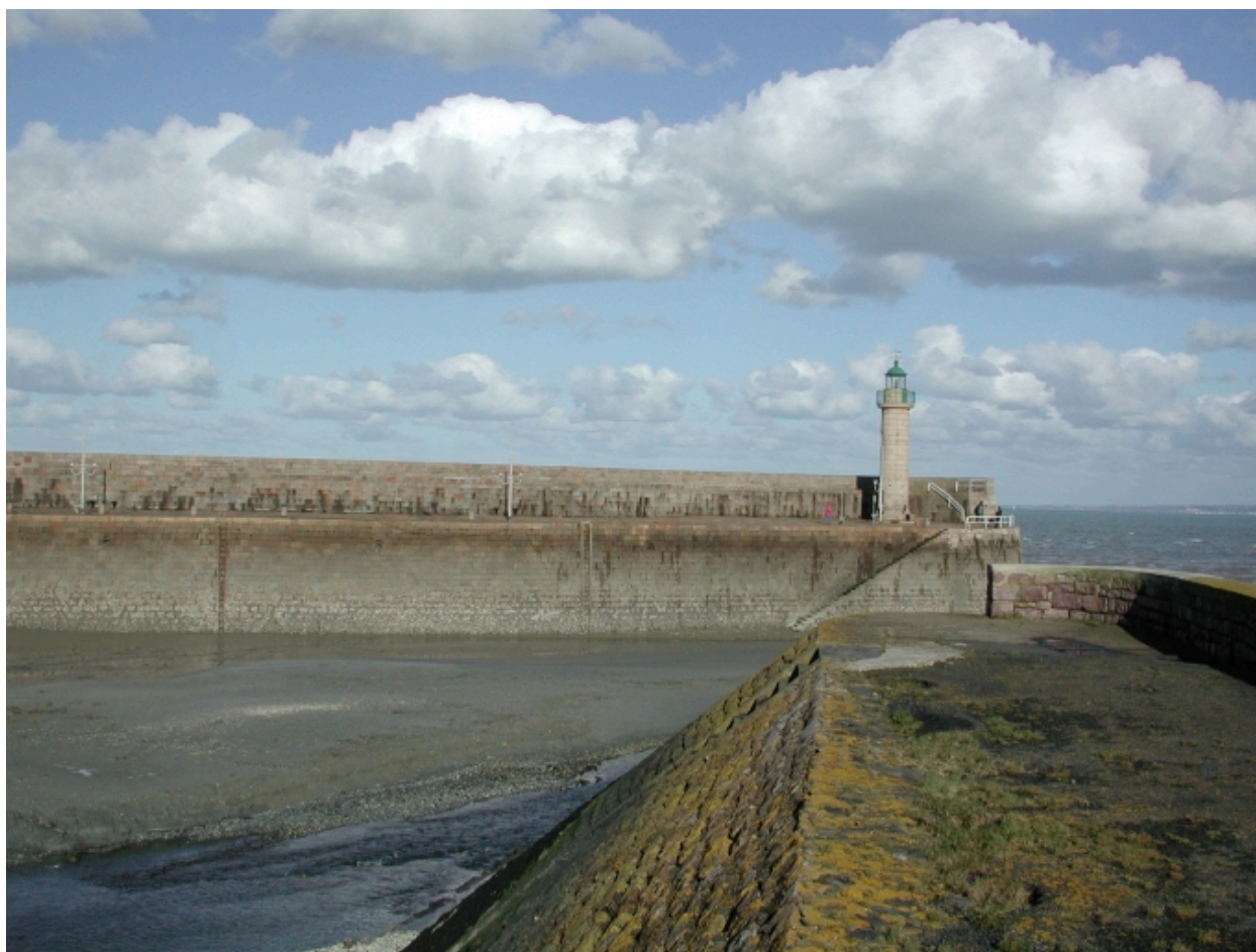
Vue de la porte océane de l'avant-port, entre les deux jetées
