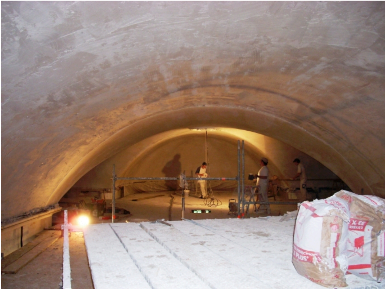
Le Ponthou, église paroissiale Saint-Barthélémy : vue transversale sud-est de la fausse voûte, détail
