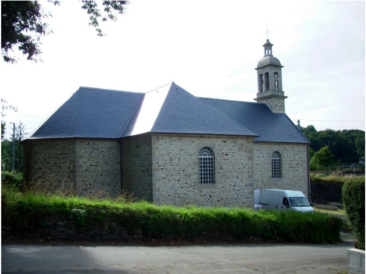
Le Ponthou, église paroissiale Saint-Barthélémy : vue générale nord-est
