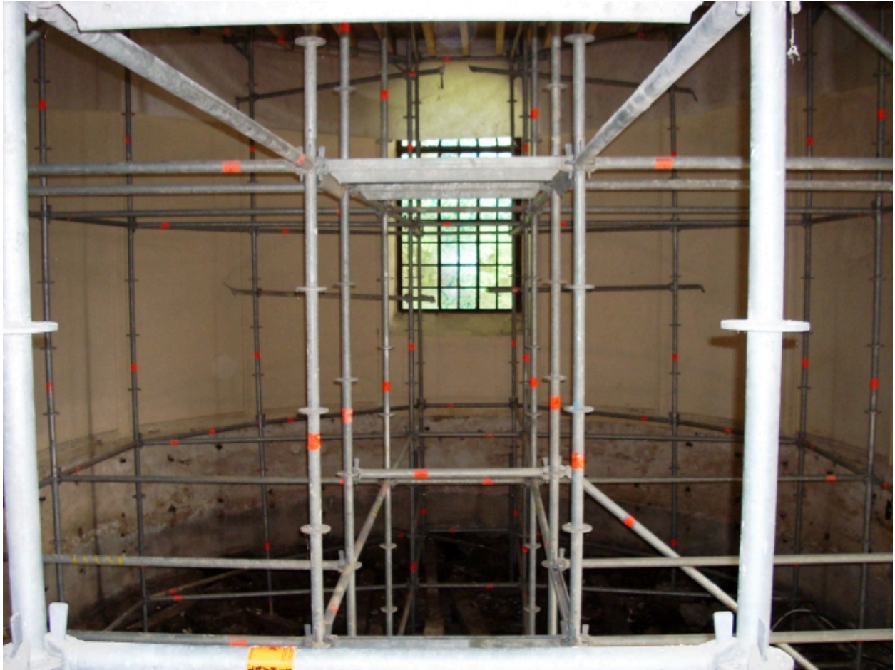
Le Ponthou, église paroissiale Saint-Barthélémy : vue axiale est
