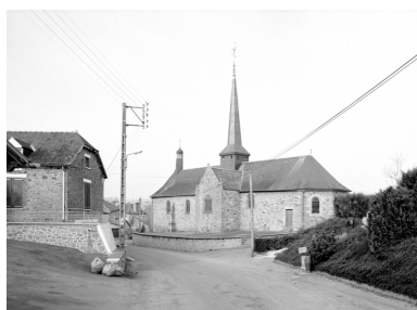
Elévation Sud : vue générale Phot. Bernard Bègne, Phot. M. Loyon IVR53_19933500684X
