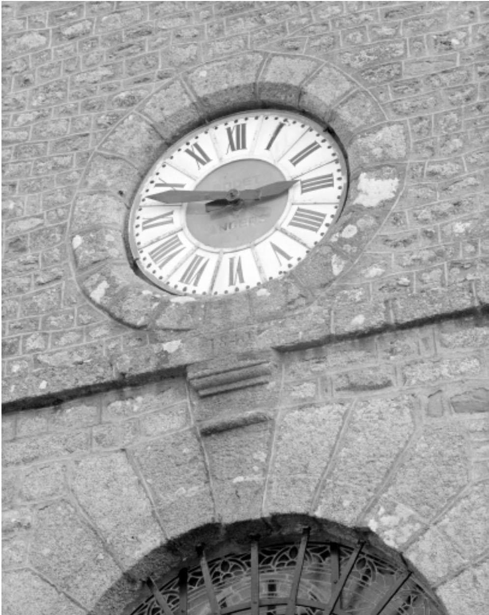
Elévation Ouest, horloge : vue générale
