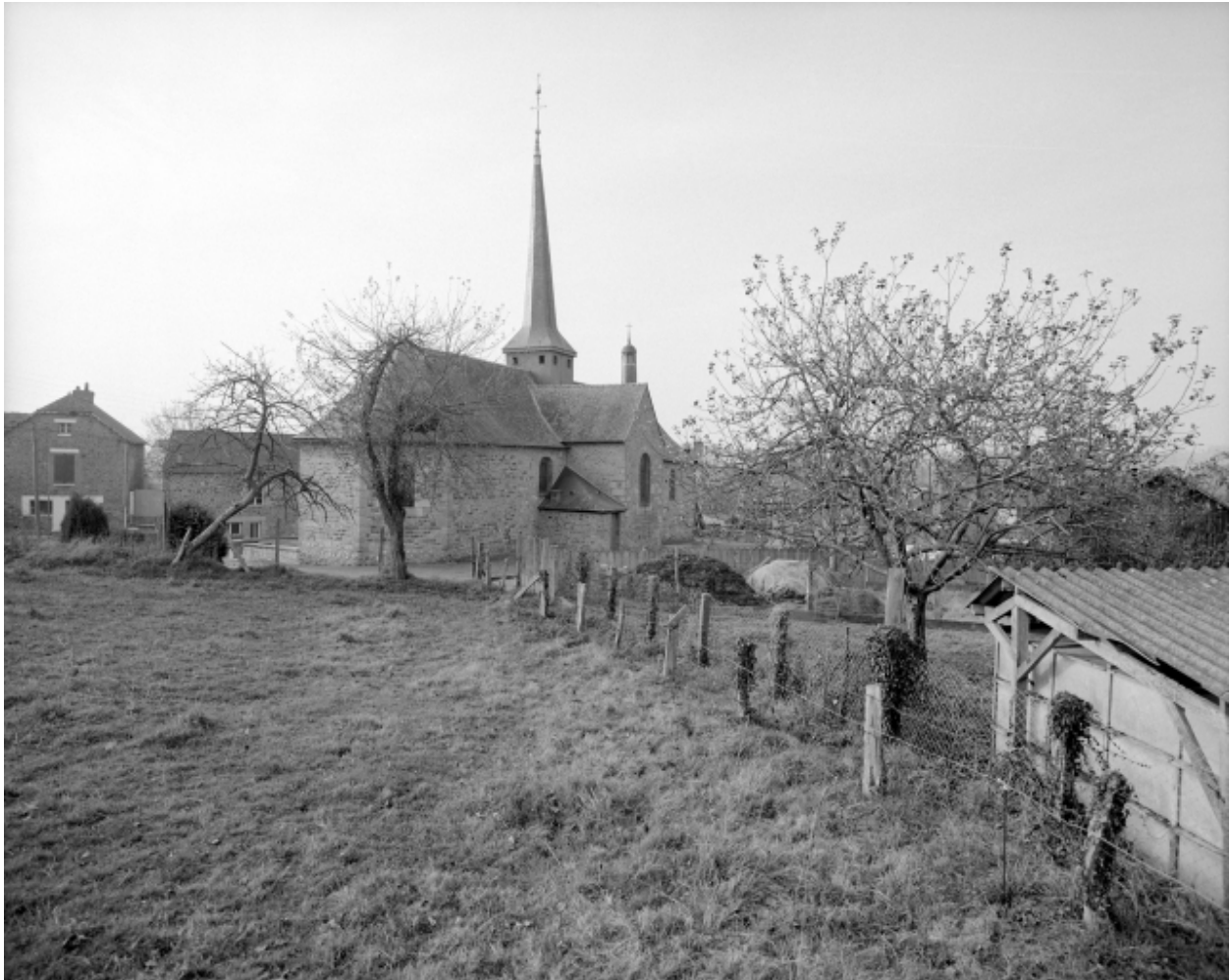
Elévation Est : vue générale
