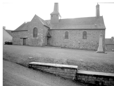
Elévation Nord : vue générale Phot. Bernard Bègne, Phot. M. Loyon IVR53_19933500686X
