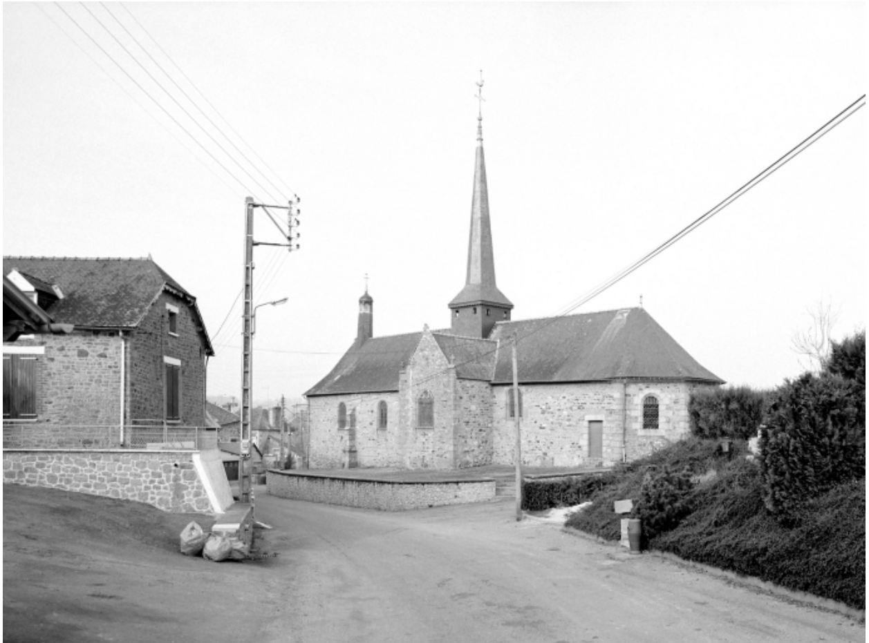
Elévation Sud : vue générale
