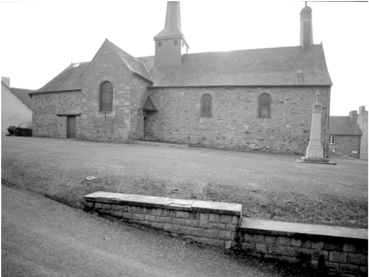
Elévation Nord : vue générale
