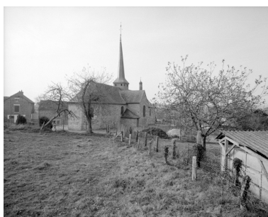
Elévation Est : vue générale Phot. Bernard Bègne, Phot. M. Loyon IVR53_19933500685X
