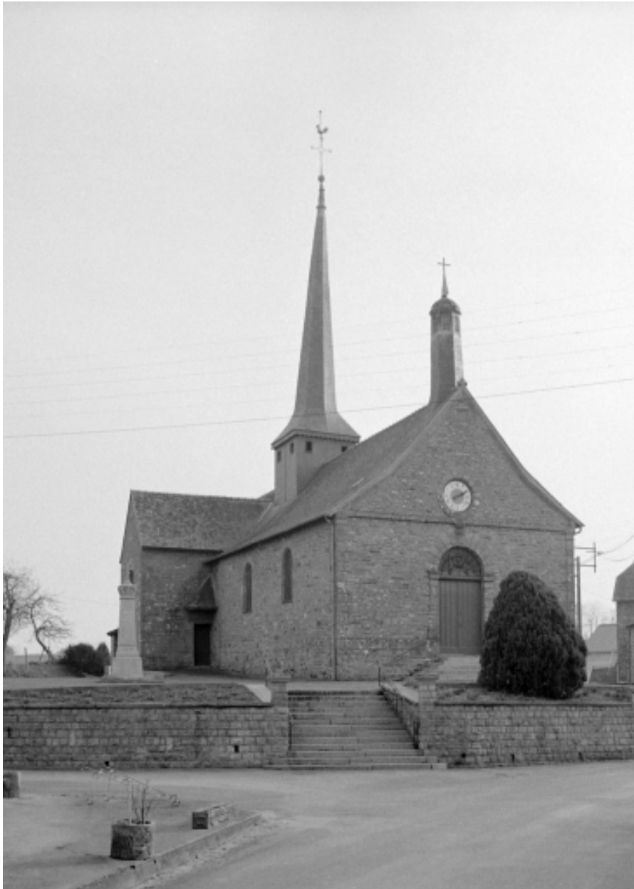
Elévation Ouest : vue générale
