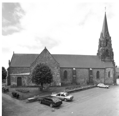
Vue générale nord Phot. Guy Artur, Phot. Norbert Lambart IVR53_20013502252X
