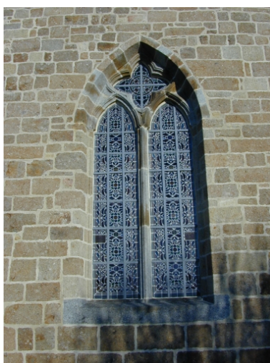
Le croisillon sud, la baie : vue générale sud Phot. Xavier Gilbert IVR53_20013518187NUCA
