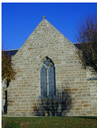
Le croisillon sud : vue générale Phot. Xavier Gilbert IVR53_20013518186NUCA
