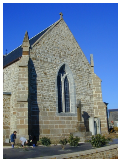
Le chevet : vue générale sud-est Phot. Xavier Gilbert IVR53_20013518185NUCA
