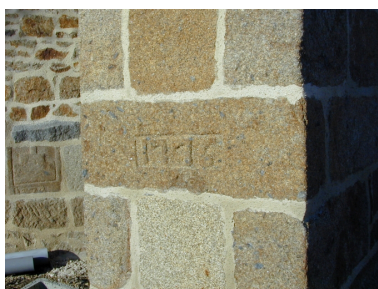
Contrefort sud-est du chœur gravé d'une dat : détail Phot. Xavier Gilbert IVR53_20013518190NUCA
