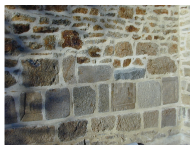
Sacristie, oriental monté avec des pierres de remplois : vue partielle sud-est Phot. Xavier Gilbert IVR53_20013518188NUCA
