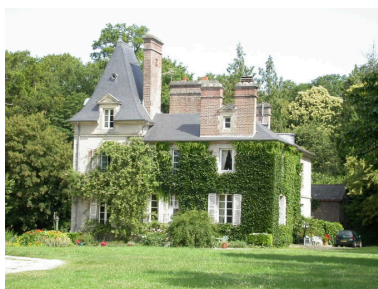
Vue générale sud Phot. Sabrina Dalibard IVR53_20043519212NUCA
