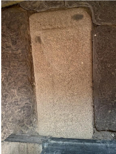
Vue générale Phot. Baptiste Oligo IVR53_20265610344NUCA
