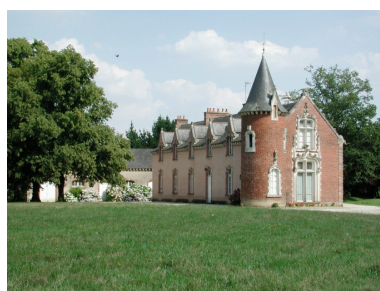
Vue générale nord-ouest Phot. Elise Lauranceau IVR53_20013510564NUCA
