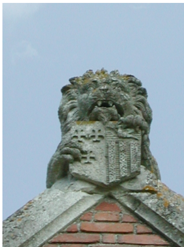
Détail du pignon de la façade ouest : lion tenant un blason armorié Phot. Elise Lauranceau IVR53_20013510570NUCA
