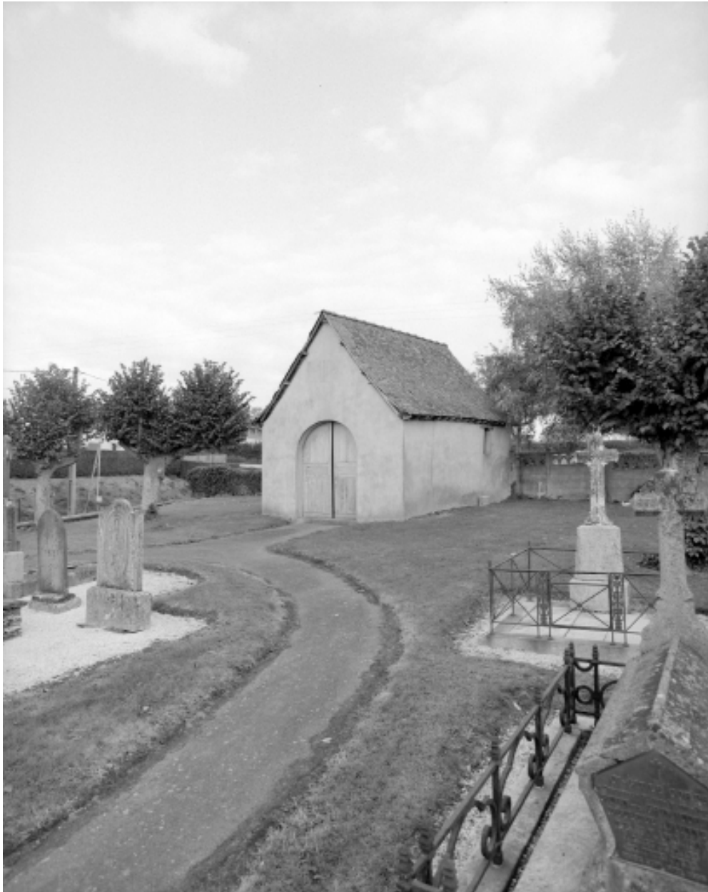
Elévation Sud-Ouest : vue générale
