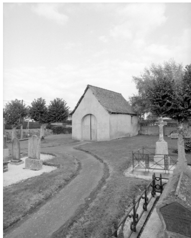
Elévation Sud-Ouest : vue générale Phot. Bernard Bègne, Phot. M. Loyon IVR53_19923500885X
