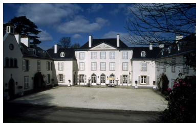
Vue générale sud Phot. Bernard Bègne IVR53_19995600389ZA
