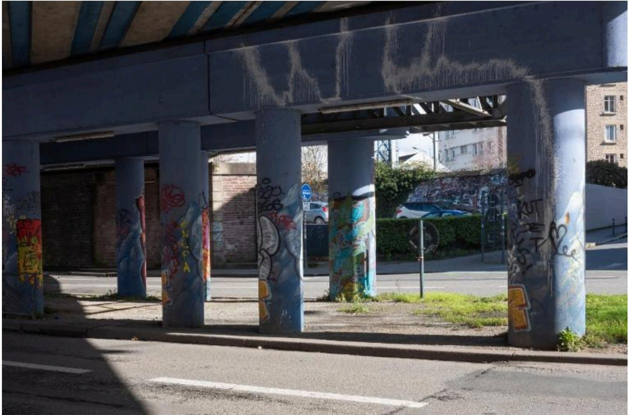
Vue de la pile centrale composée de deux rangées de poteaux supportant le tablier.
