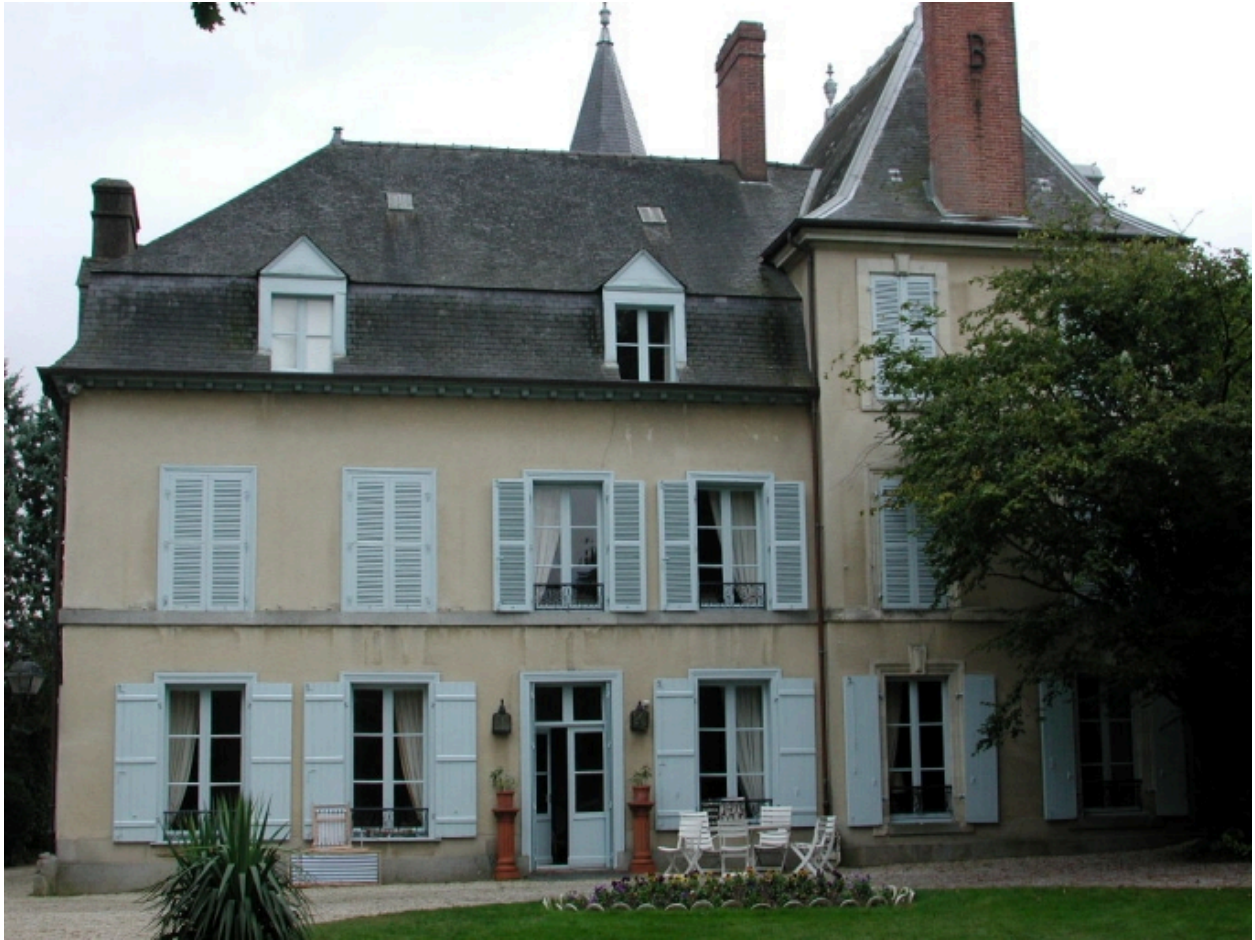
Vue générale de la façade principale
