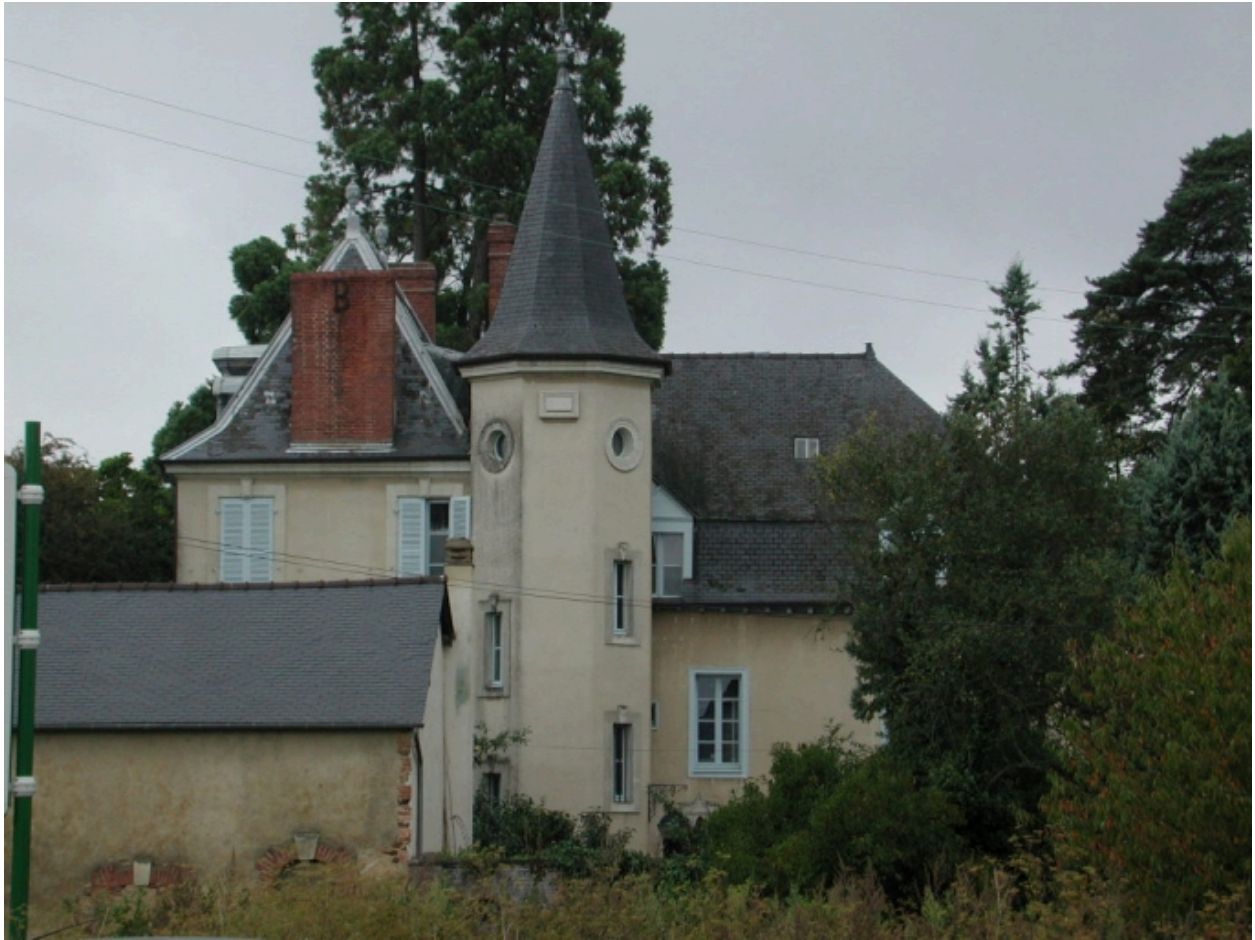
Façade arrière du logis prise de la route
