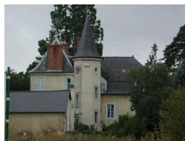
Façade arrière du logis prise de la route Phot. Véronique Orain IVR53_20013515330NUCA
