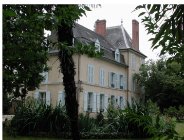
Façade latérale et façade principale Phot. Véronique Orain IVR53_20013515329NUCA
