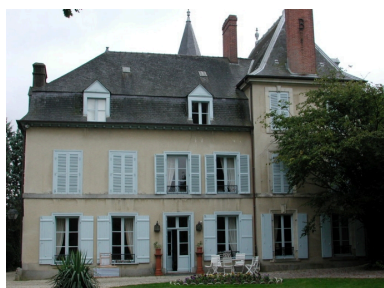
Vue générale de la façade principale Phot. Véronique Orain IVR53_20013515328NUCA
