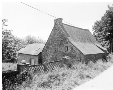
Vue générale nord-est. Phot. Guy Artur, Phot. Norbert Lambart IVR53_19885600221X
