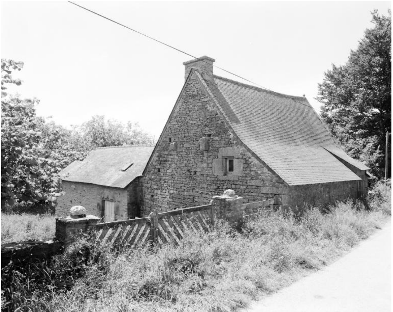
Vue générale nord-est.
