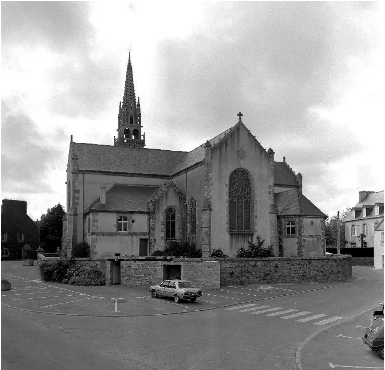
Église : chevet vu du sud-est (état en 1986)
