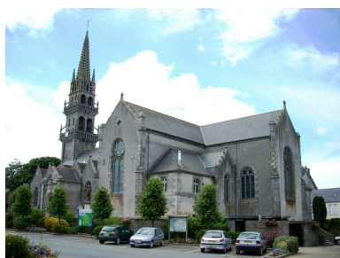
Église : vue générale prise du sud-est (état en 2008) Phot. Gwénaél Fauchille IVR53_20082906351NUCA
