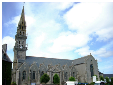
Église : élévation sud vue du sud-ouest (état en 2008) Phot. Gwénaél Fauchille IVR53_20082906350NUCA
