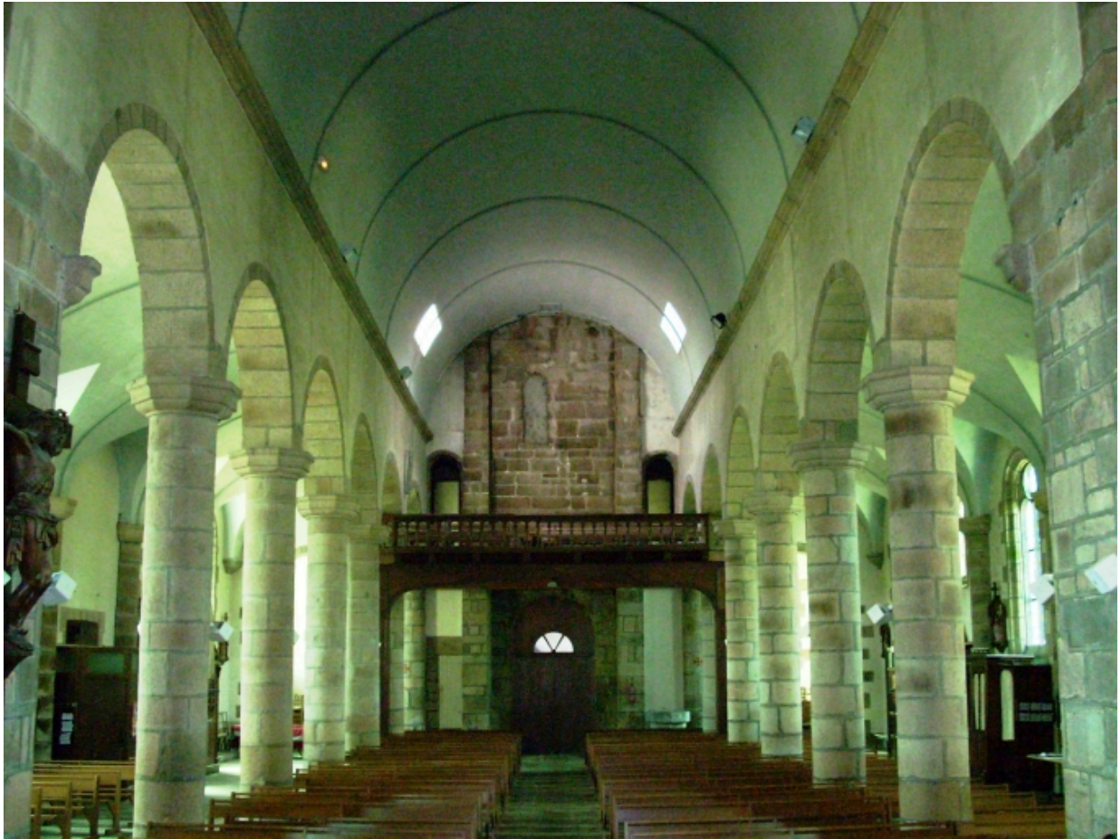
Église : vue générale de la nef (état en 2008)
