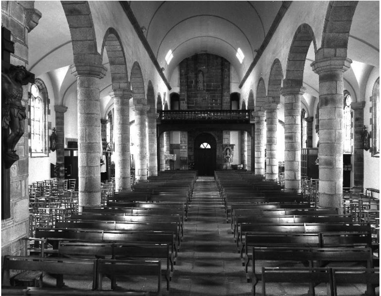
Église : vue générale de la nef (état en 1987)
