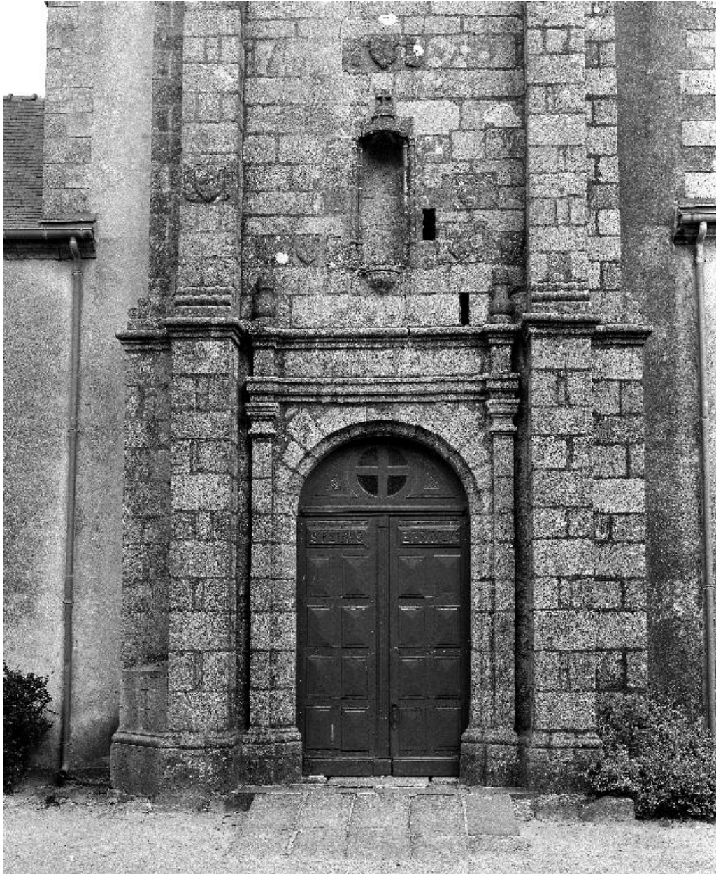
Église : portail occidental (état en 1986)
