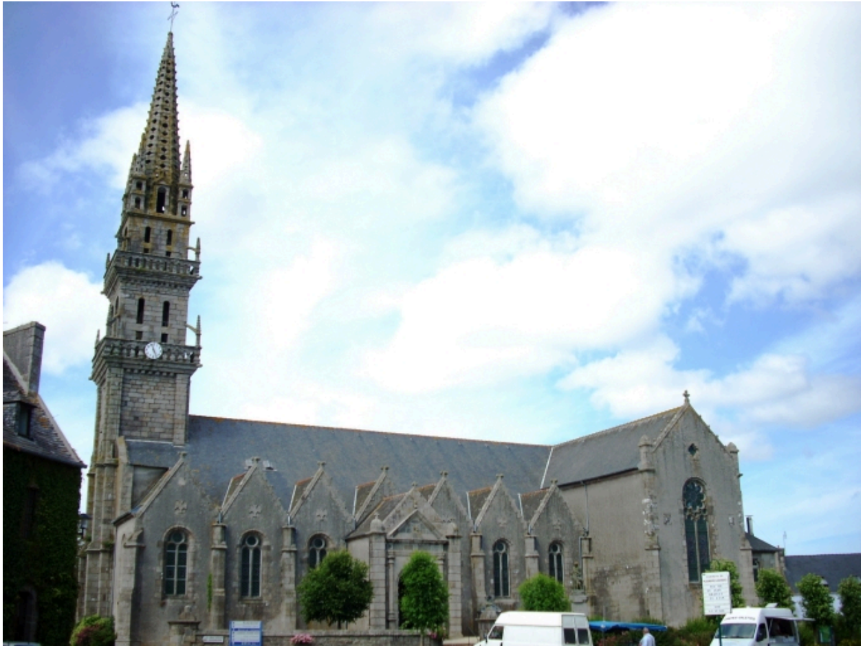
Église : élévation sud vue du sud-ouest (état en 2008)
