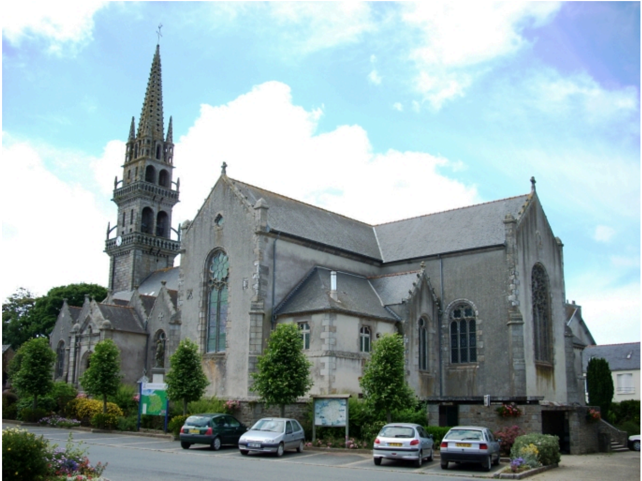
Église : vue générale prise du sud-est (état en 2008)
