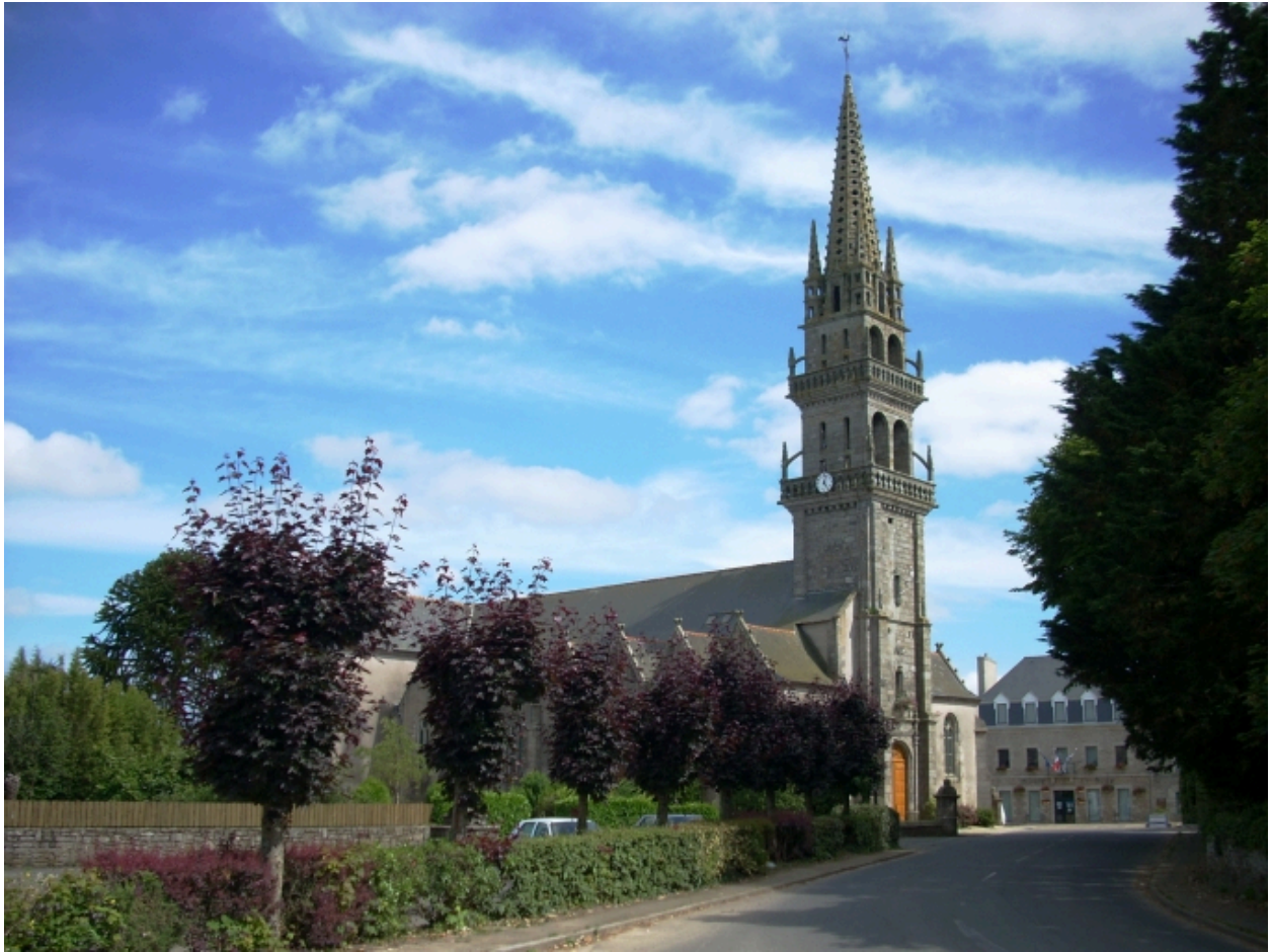
Église : élévation nord prise du nord-ouest (état en 2008)
