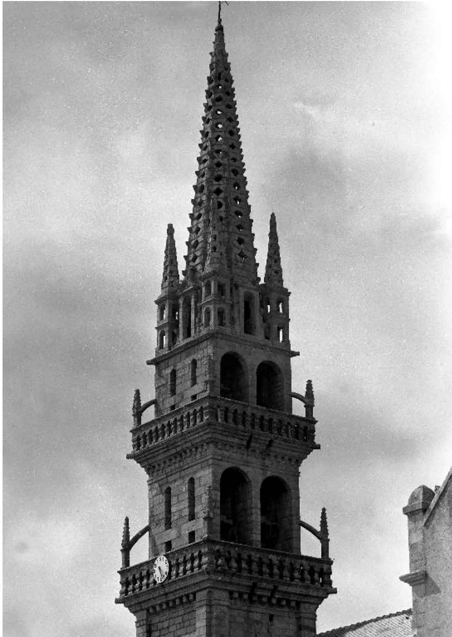
Église : clocher, élévation sud-est (état en 1986)
