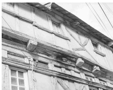
La lisse haute détermine des impostes partiellement aveugles.
