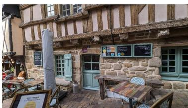
Le rez-de-chaussée, repris en sous-œuvre, comporte une porte et une fenêtre aux linteaux surbaissés.
