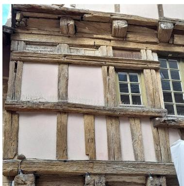
Les mortaises orphelines dans deux des poteaux signalent une reprise de la structure en pan de bois.
