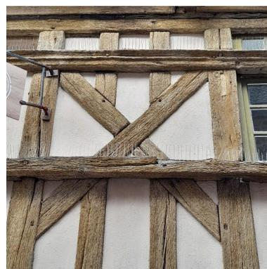
Mortaises orphelines bouchées sur les poteaux, sous la lisse haute moulurée.
