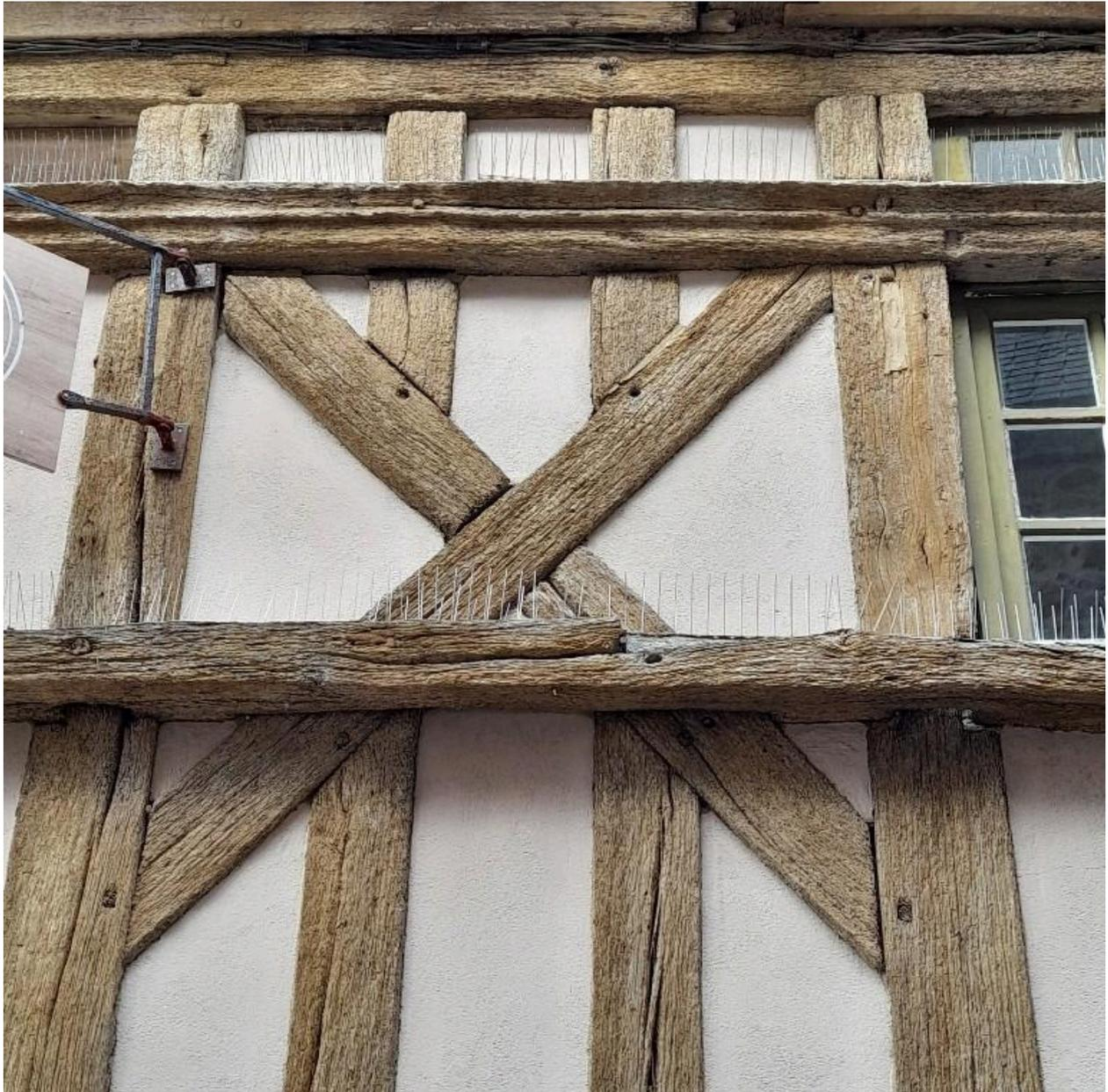
Mortaises oprhelines bouchées sur les poteaux, sous la lisse haute moulurée.
