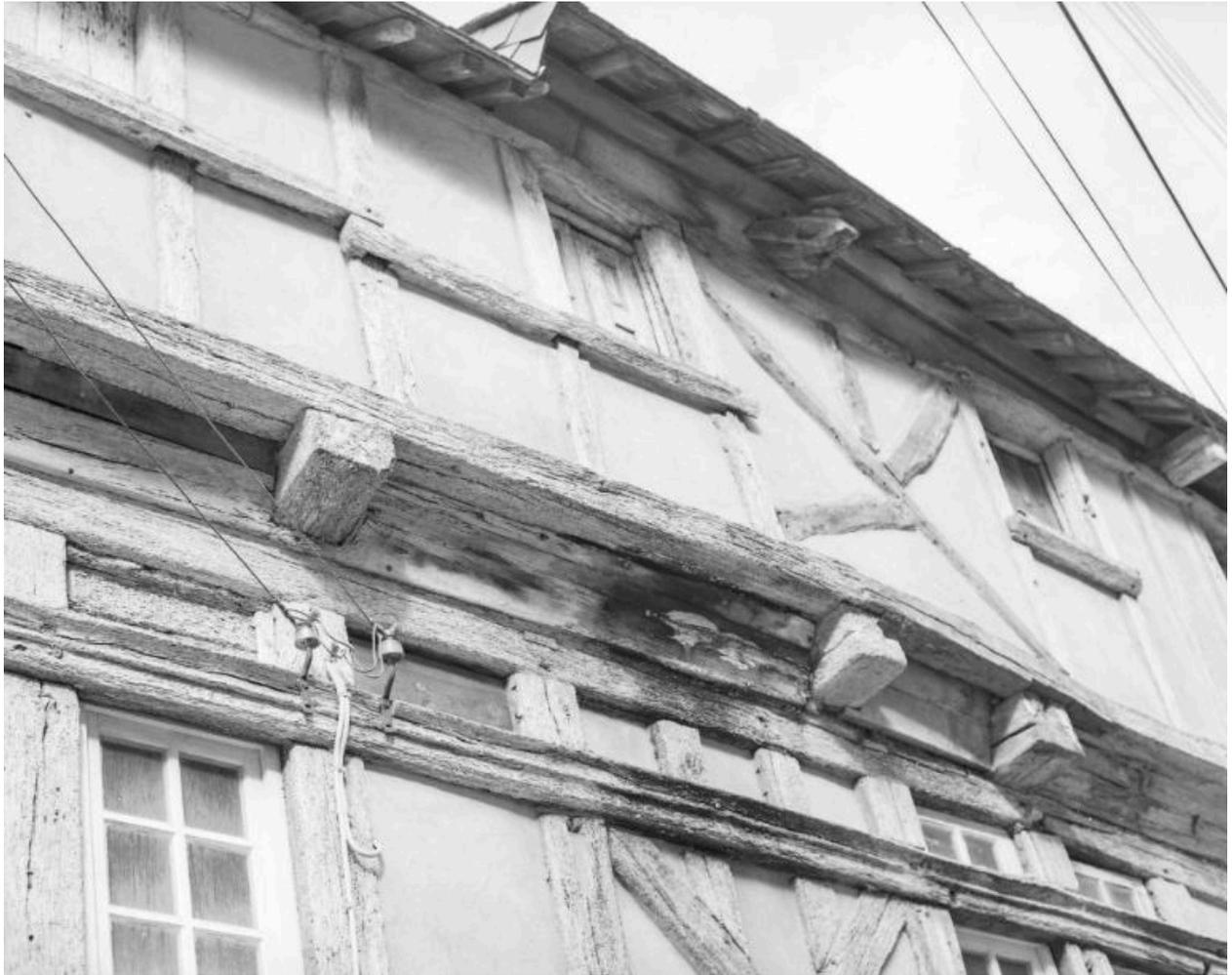
La lisse haute détermine des impostes partiellement aveugles.
