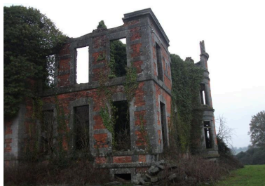
Détail du château Phot. Stéphanie Bardel IVR53_20133518295NUCA
