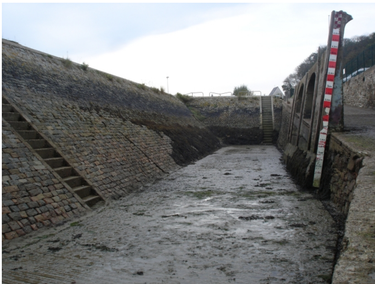
Vue générale du bassin ouvert
