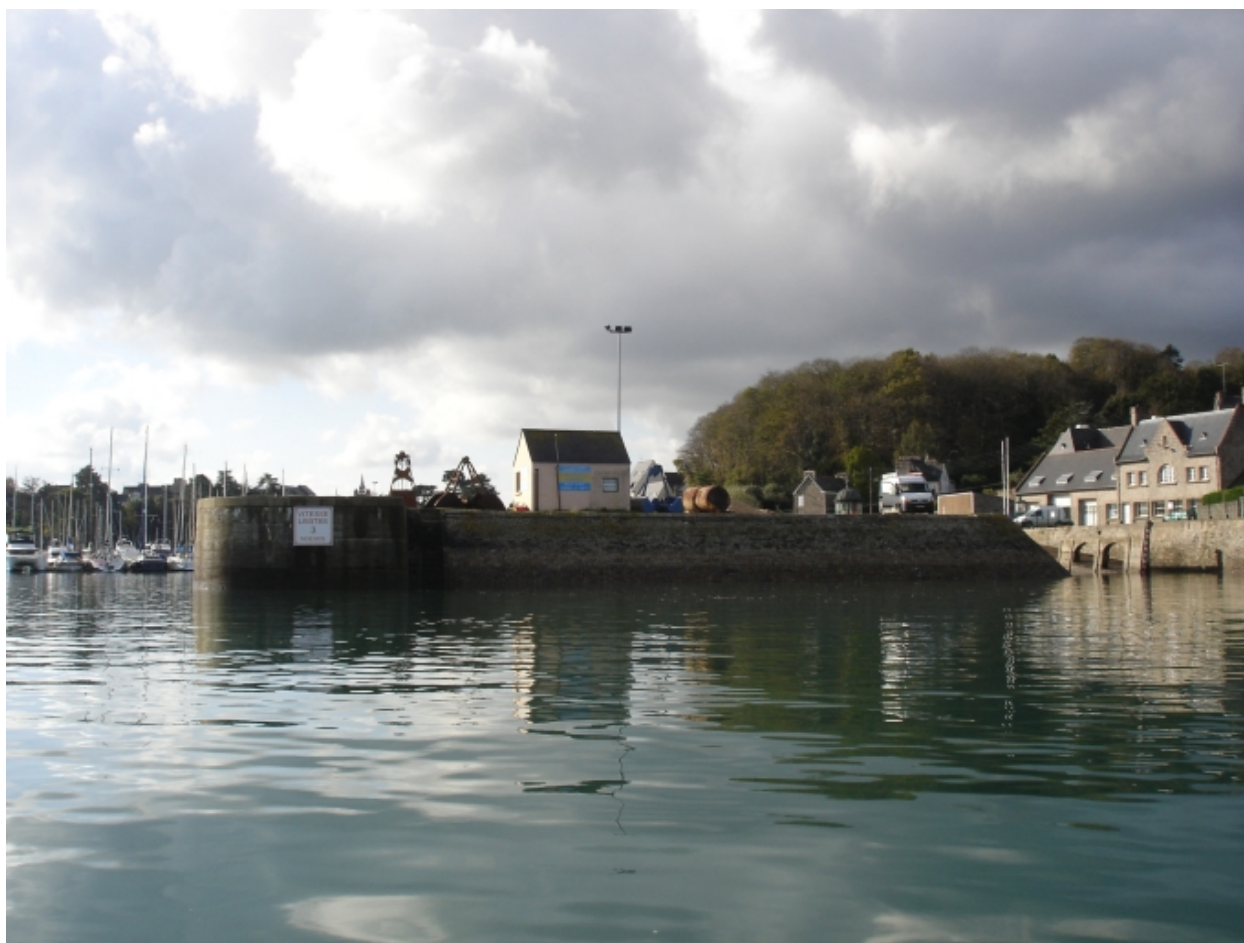
Vue des arches de la cales et du quai en retour des sabliers
