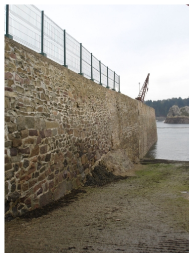
Vue du mur de la jetée du parc des Phares et Balises et de la cale de mise à l'eau Phot. Guy Prigent IVR53_20092206031NUCA
