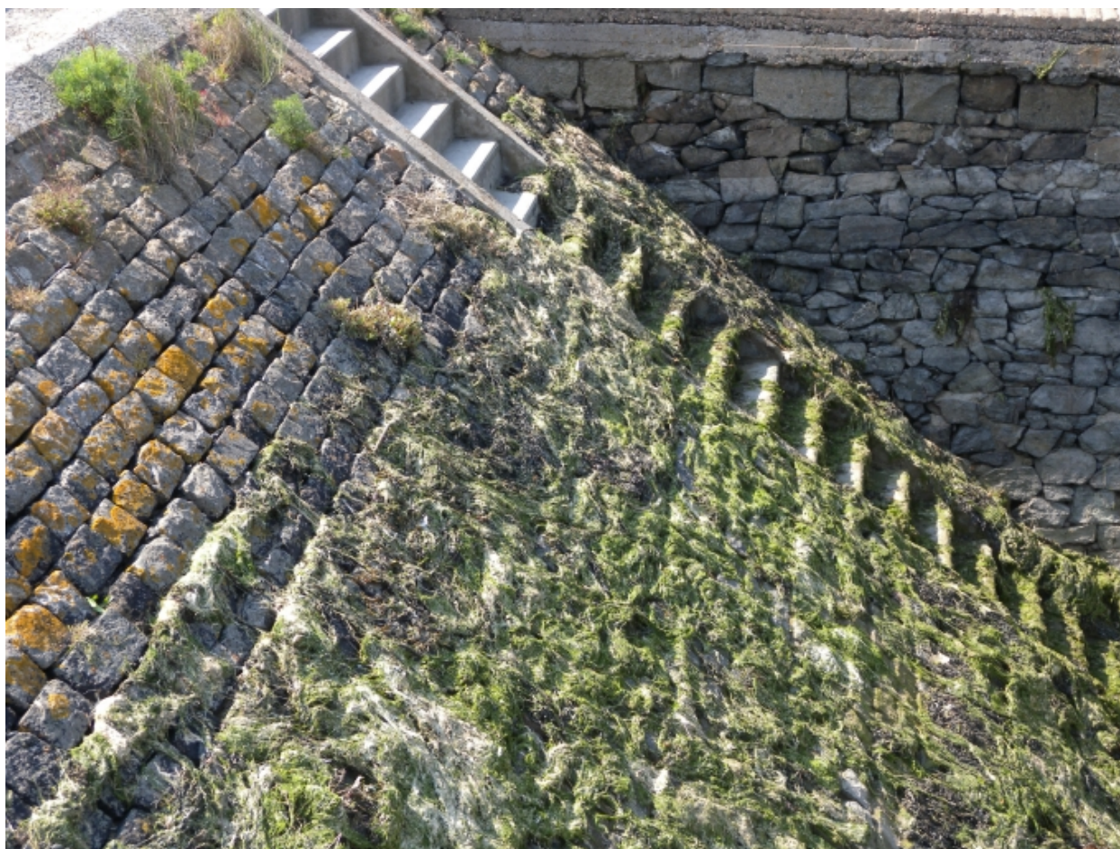
Vue du mur de quai Sud, équipé d'un escalier, avec une forme déclivité, formant le 'nez' du bassin
