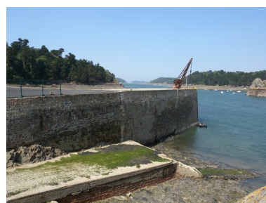
Vue des murs de quai et de la cale défendue sur le côté Sud-Est par une forme d'arche en pierre ou bajoyer Phot. Guy Prigent IVR53_20092206365NUCA
