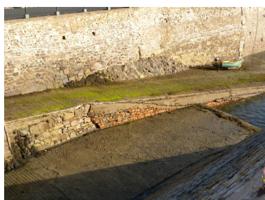
Vue de la cale de carénage et des murs de quais ou bajoyers qui délimitent le bassin submersible Phot. Guy Prigent IVR53_20092206367NUCA
