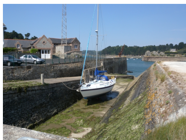
Vue générale Phot. Guy Prigent IVR53_20092206395NUCA
