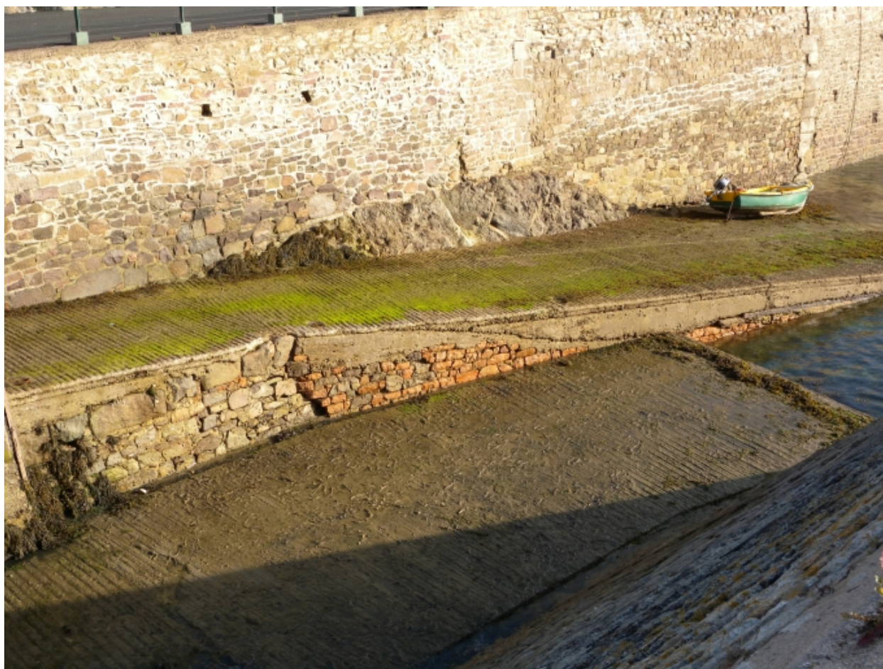
Vue de la cale vaigrée en ciment et de la forme de radier à proximité
