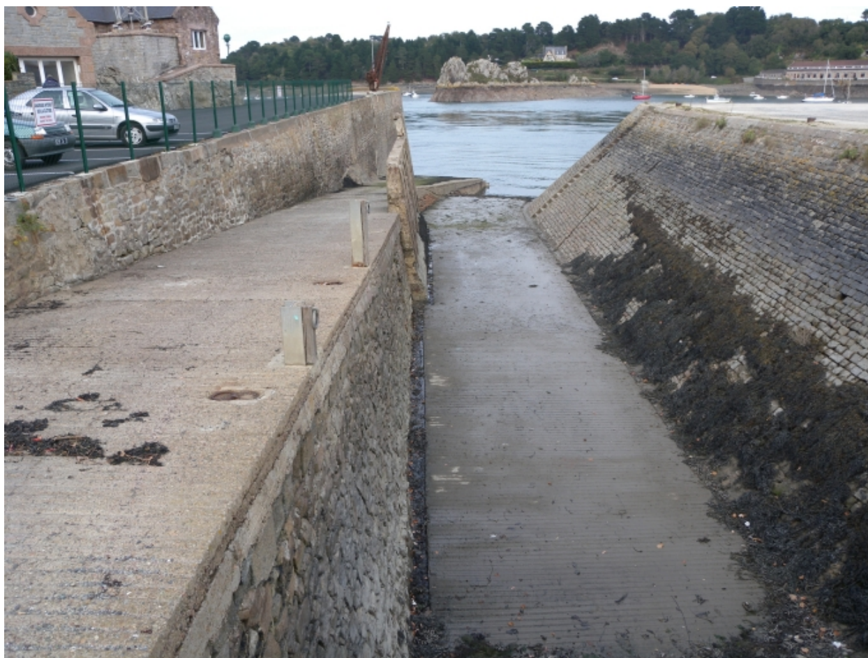
Vue de la cale et du gril de carénage
