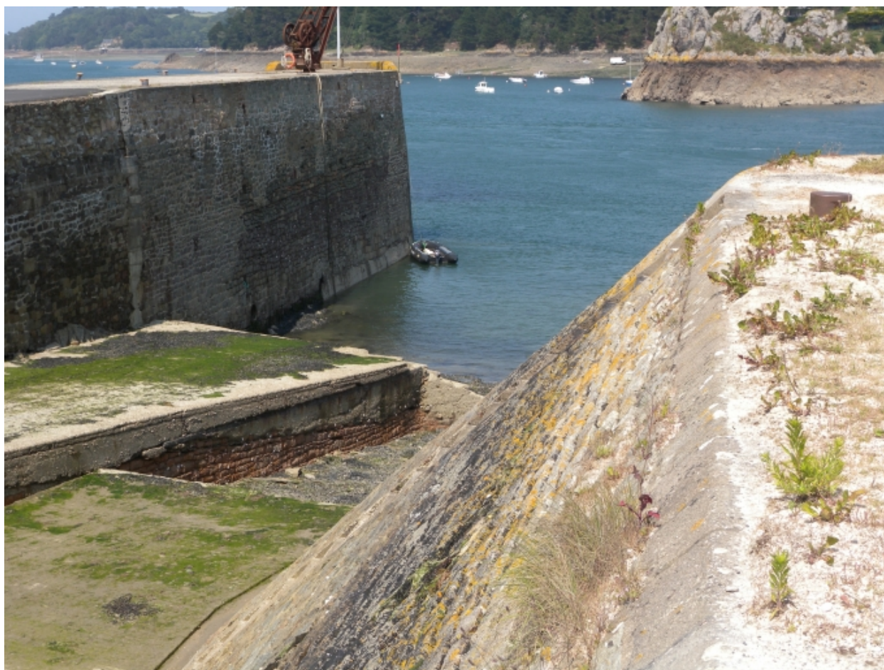
Vue de la cale de carénage et des murs de quais ou bajoyers qui délimitent le bassin submersible
