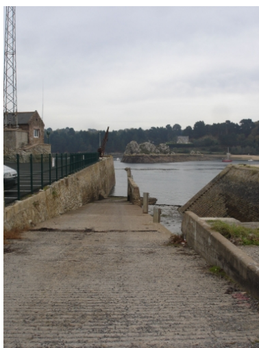
Vue de la cale maçonnée parallèle au grill de carénage Phot. Guy Prigent IVR53_20092206019NUCA
