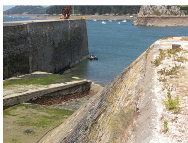
Vue de la cale de carénage et des murs de quais ou bajoyers qui délimitent le bassin submersible Phot. Guy Prigent IVR53_20092206367NUCA
