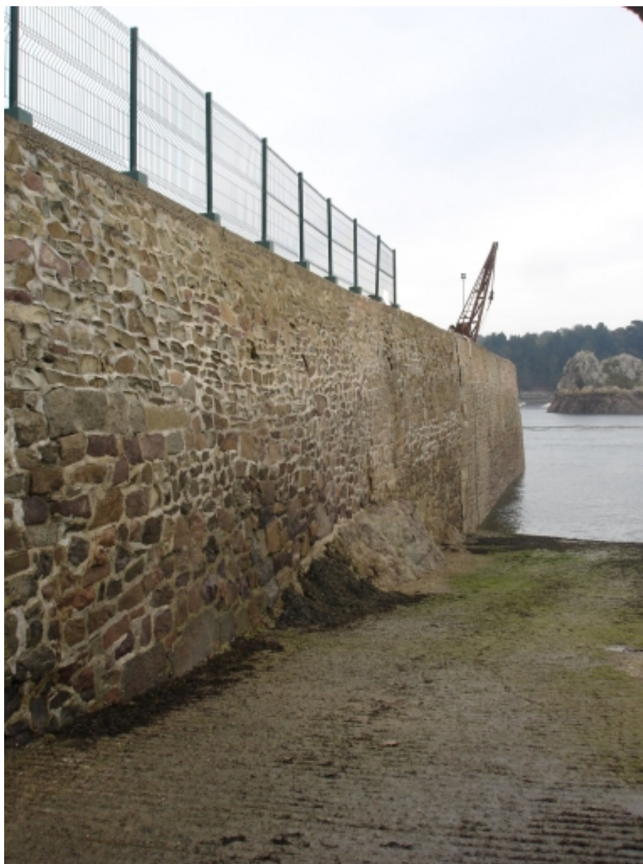
Vue du mur de la jetée du parc des Phares et Balises et de la cale de mise à l'eau
