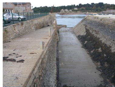
Vue de la cale et du grill de carénage Phot. Guy Prigent IVR53_20092206033NUCA
