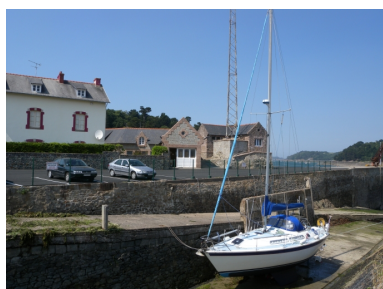
Vue d'un navire échoué sur le radier Phot. Guy Prigent IVR53_20092206359NUCA
