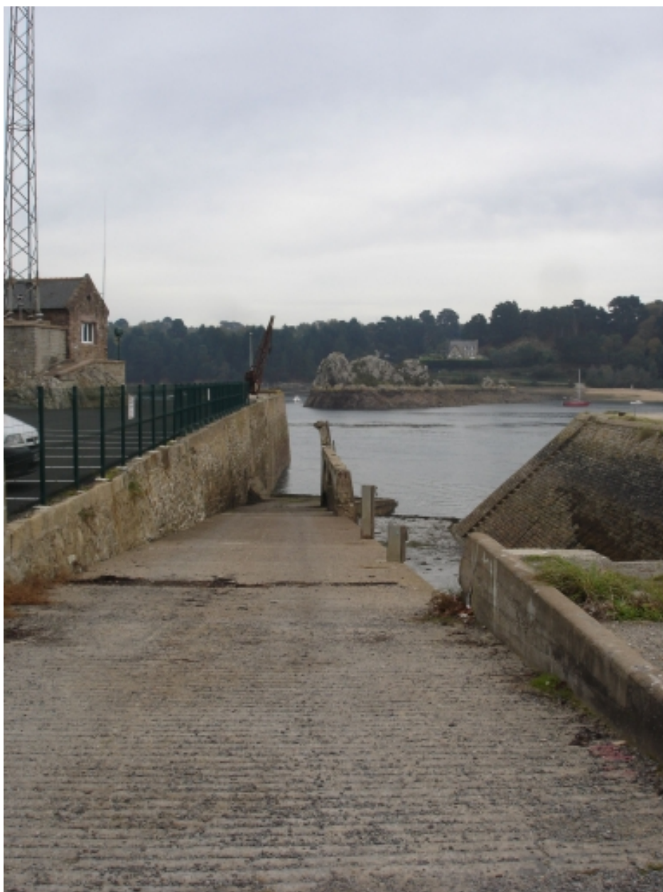
Vue de la cale maçonnée parallèle au gril de carénage
