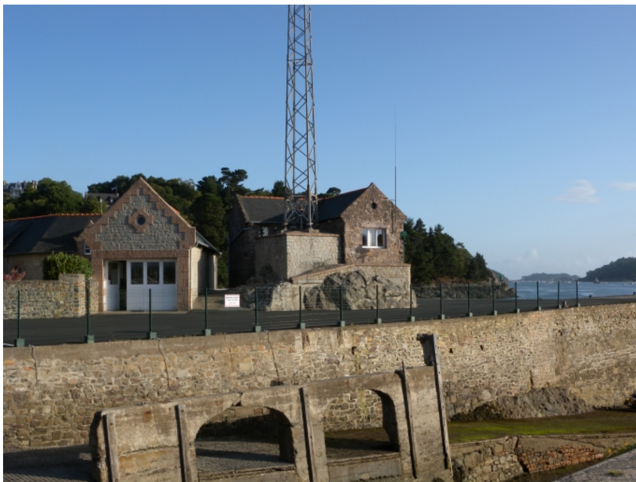
Vue des murs de quai et de la cale défendue sur le côté Sud-Est par une forme d'arche en pierre ou bajoyer
