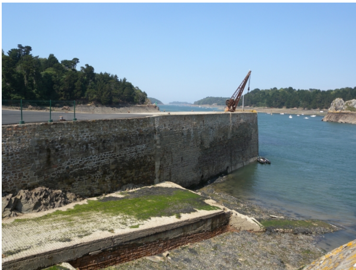
Vue de l'extrémité de la cale de carénage et du mur de quai de la jetée des Phares et Balises
