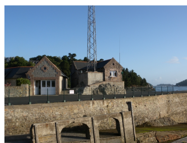
Vue des murs de quai et de la cale défendue sur le côté Sud-Est par une forme d'arche en pierre ou bajoyer Phot. Guy Prigent IVR53_20092206365NUCA
