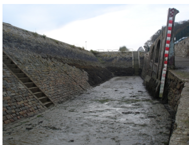
Vue générale du bassin ouvert Phot. Guy Prigent IVR53_20092206032NUCA
