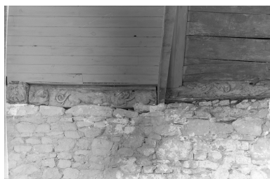
Croisillon sud, mur ouest : détail des sablières, partie nord Phot. François Dagorn IVR53_19692200746V
