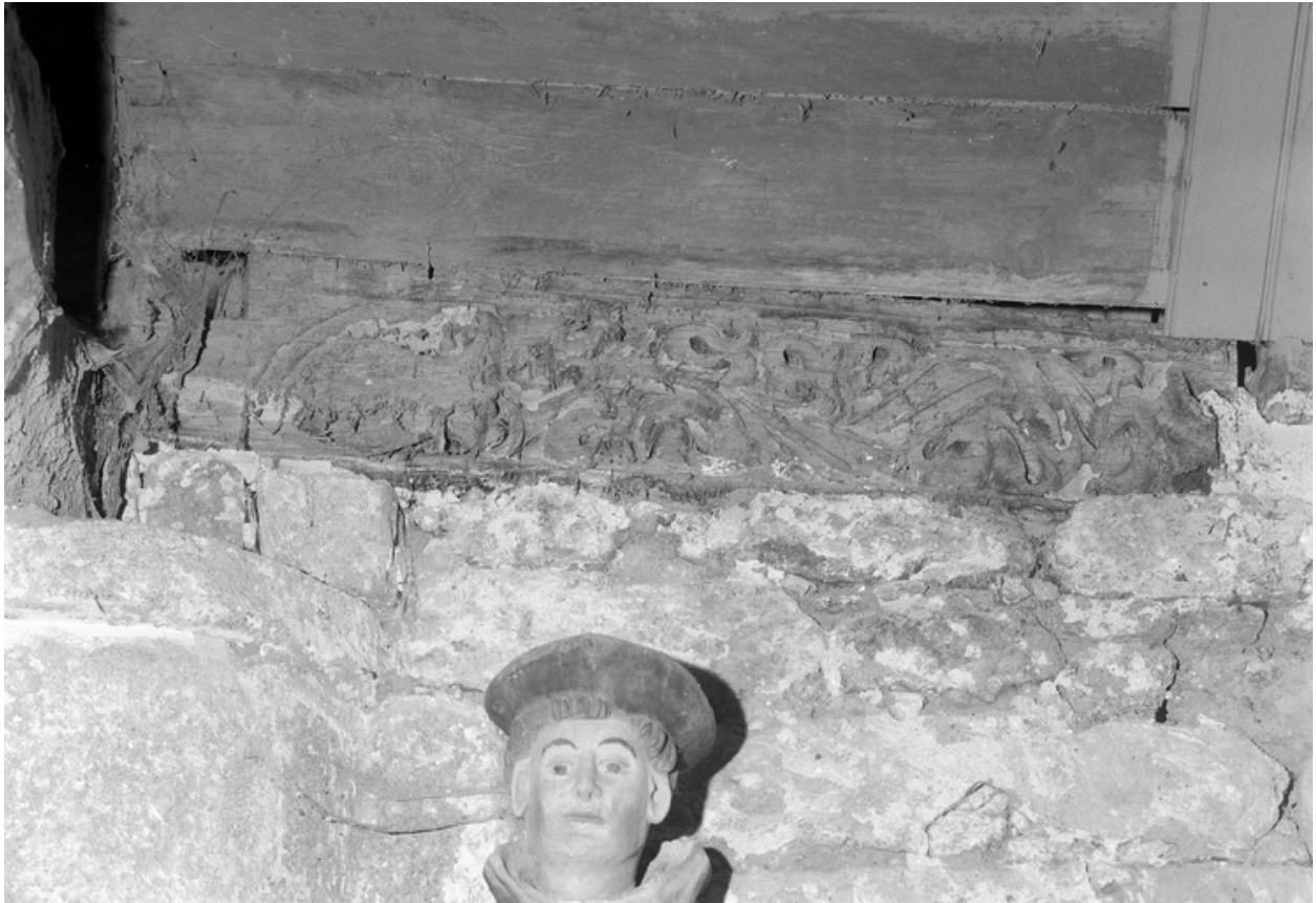
Croisillon sud, mur est : détail des sablières, partie nord
