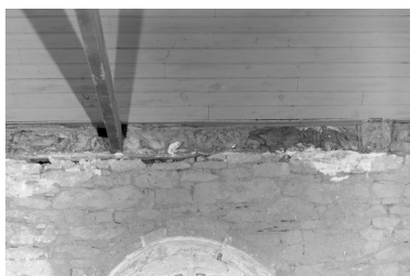
Croisillon sud, mur ouest : détail des sablières, partie sud Phot. François Dagorn IVR53_19692200747V
