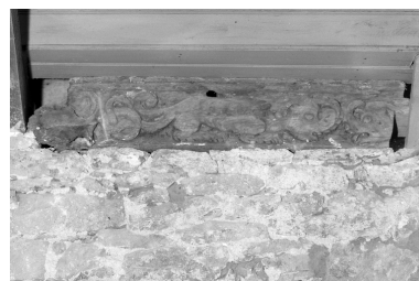
Croisillon sud, mur est : détail des sablières, partie sud Phot. François Dagorn IVR53_19692200988X
