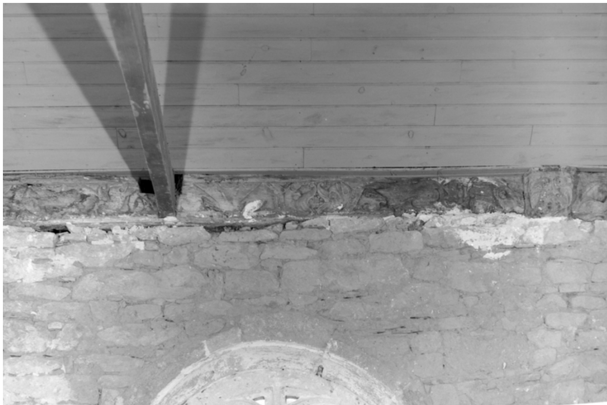
Croisillon sud, mur ouest : détail des sablières, partie sud
