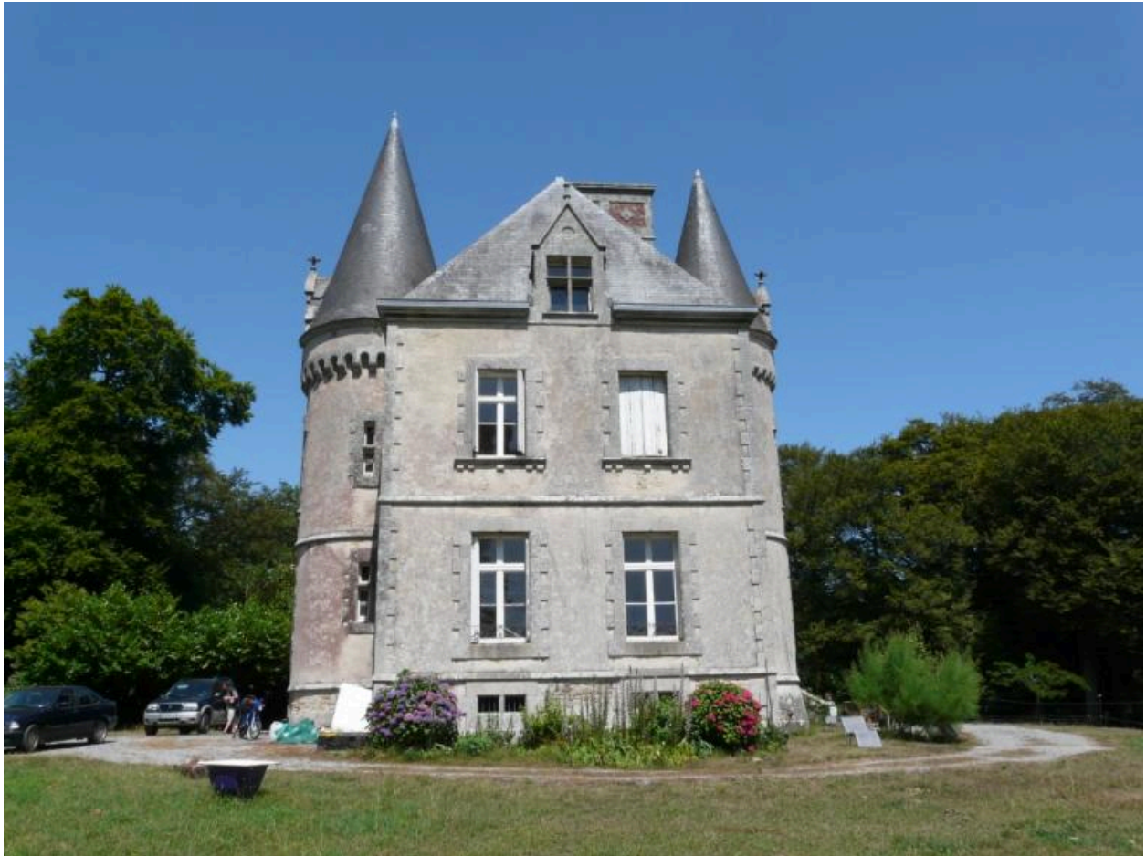
Mur pignon ouest
