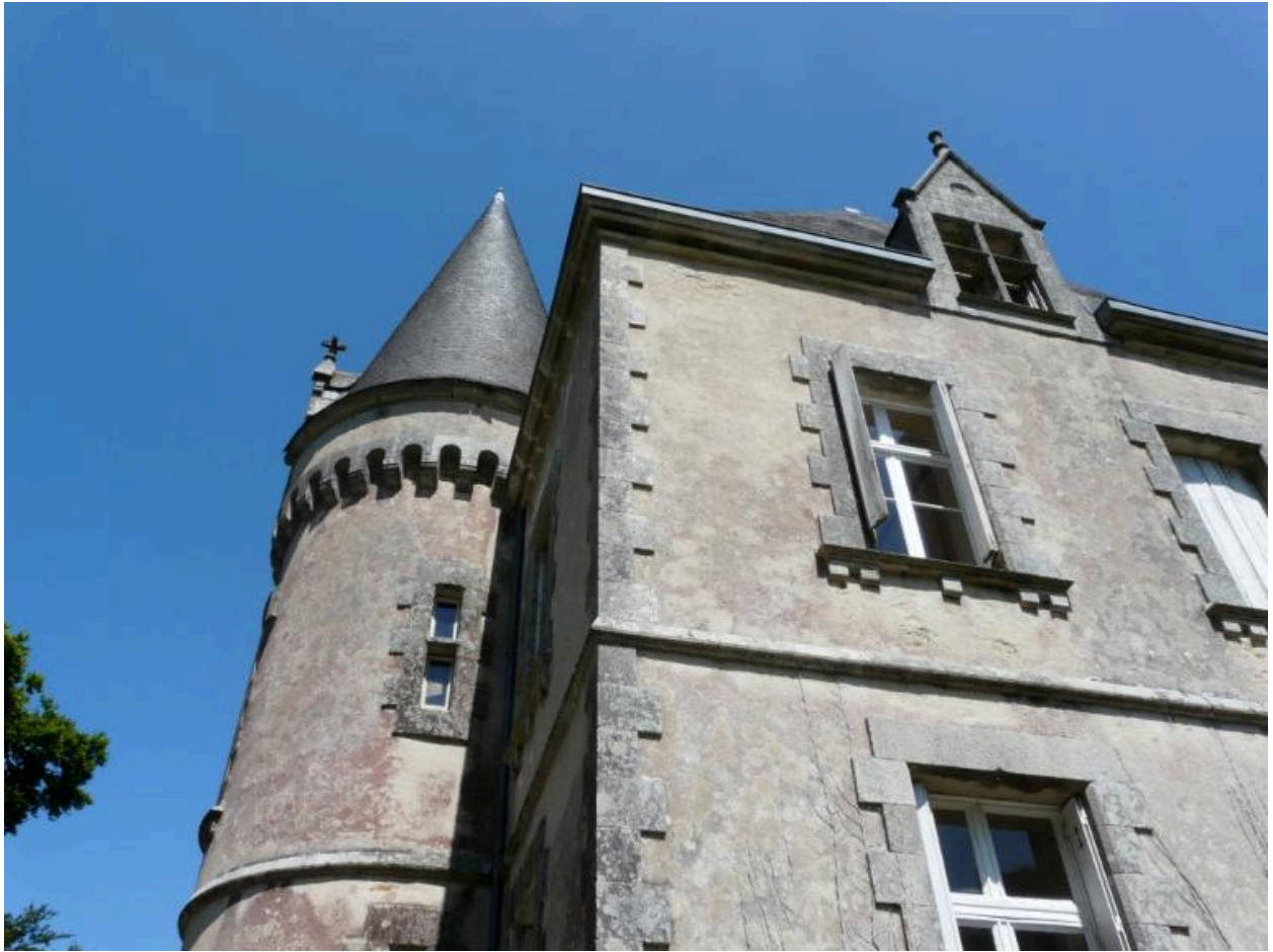
Une des tours de la façade nord ainsi q'une partie du mur pignon ouest
