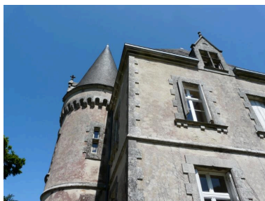
Une des tours de la façade nord ainsi q'une partie du mur pignon ouest Phot. Jeanne Gueguen IVR53_20152911164NUCA
