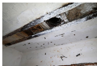
Vue intérieure : détail du plafond de la salle de garde est, puits pour un périscopes ? Phot. Guillaume Lécueillier IVR53_20242910305NUCA
