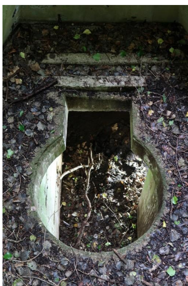
Vue de l'emplacement de la cloche blindée depuis l'extérieur. Ce bunker aurait dû être doté d'une cloche blindée de type 89P9 Phot. Guillaume Lécueillier IVR53_20242910268NUCA
