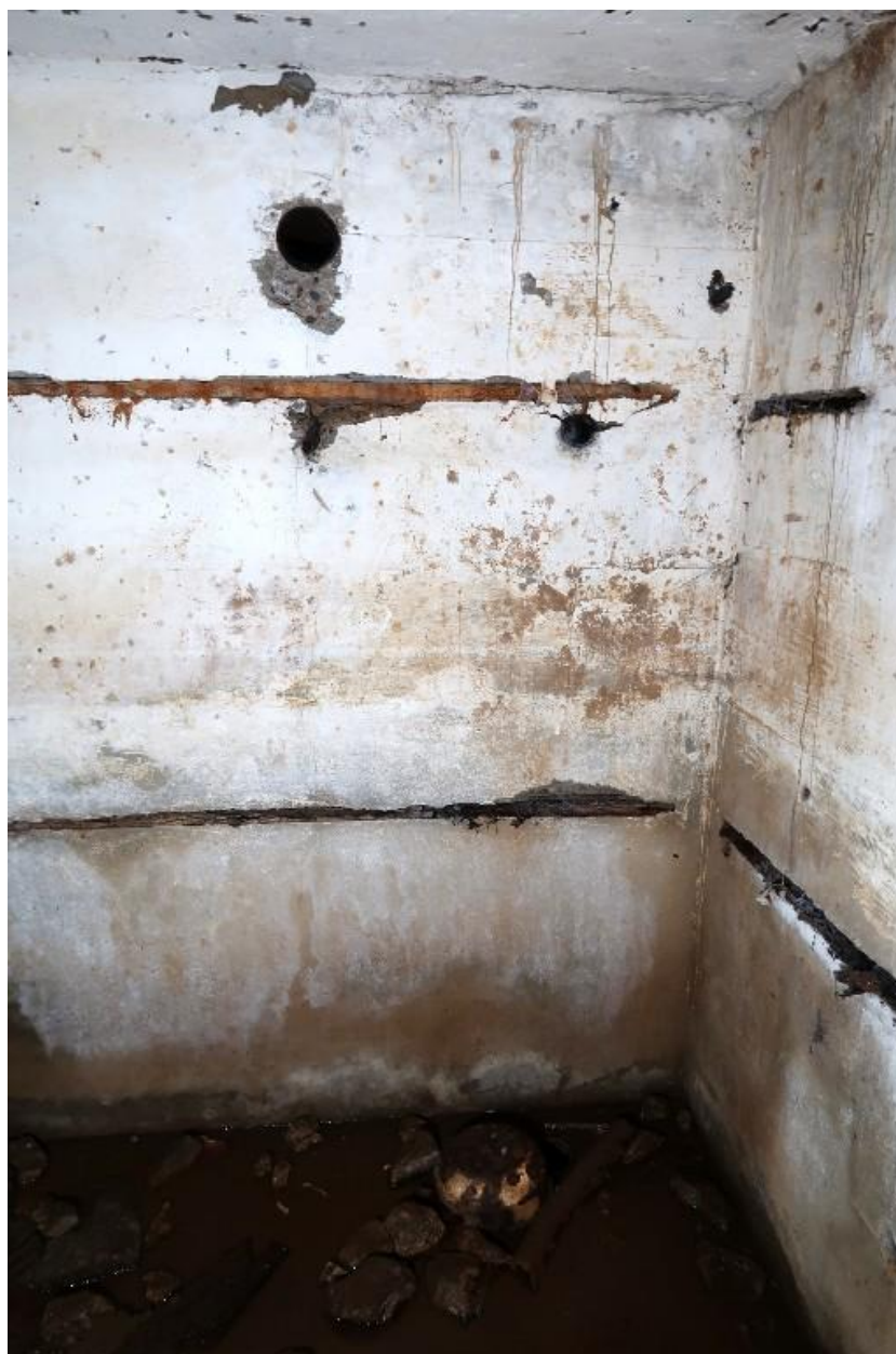
Vue intérieure : détail de l'angle sud-est de la salle de garde est. C'est à cet emplacement que se trouve en principe le boîtier de connexion téléphonique et le numéro du bunker peint sur le mur
