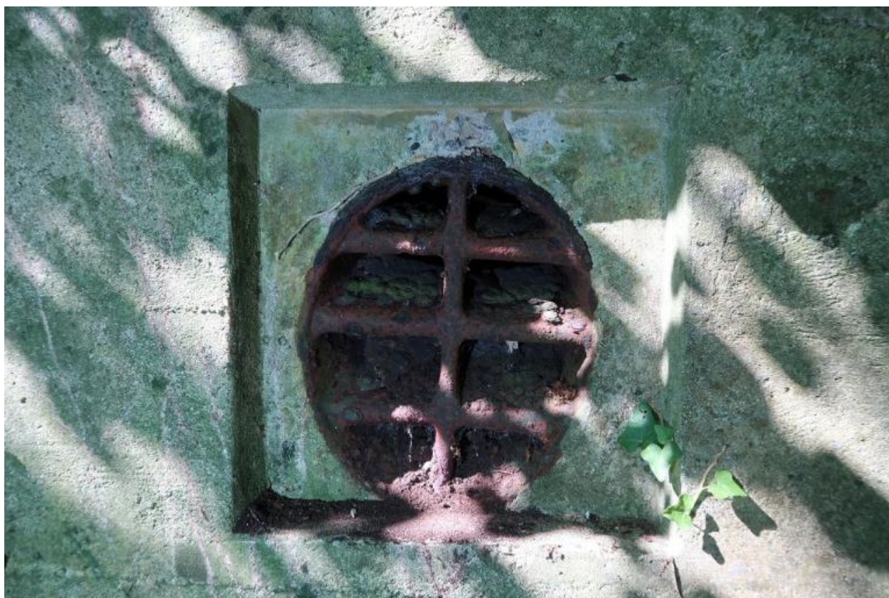
Vue de la prise d'air externe située à droite de l'entrée ouest
