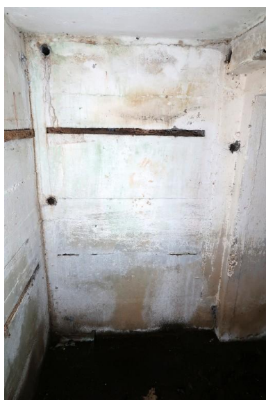
Vue de la petite pièce dédiée à la cloche blindée. Ce bunker aurait dû être doté d'une cloche blindée de type 89P9 Phot. Guillaume Lécueillier IVR53_20242910273NUCA
