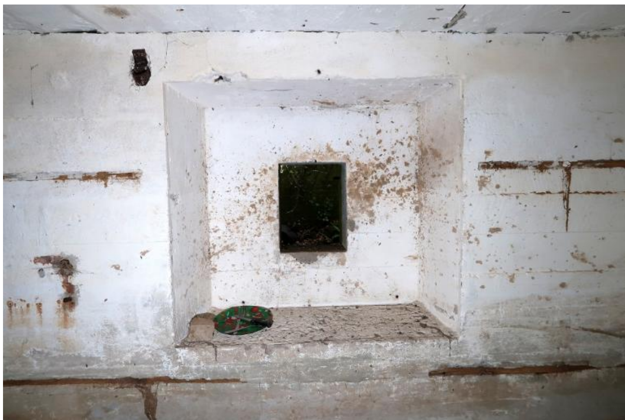
Vue intérieure : détail de l'emplacement du créneau blindé [non posé] de la salle de garde ouest
