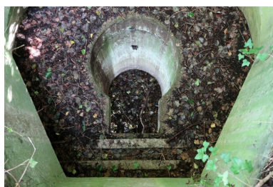
Vue de l'emplacement de la cloche blindée depuis l'extérieur. Ce bunker aurait dû être doté d'une cloche blindée de type 89P9 Phot. Guillaume Lécueillier IVR53_20242910270NUCA
