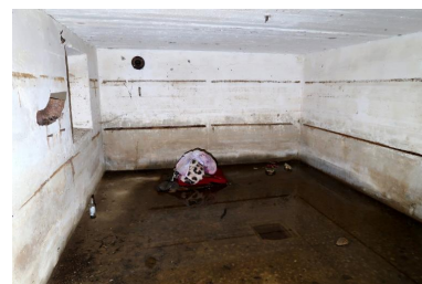
Vue intérieure : salle de garde ouest avec [de gauche à droite] l'emplacement du ventilateur, du créneau blindé [non posé] et de la conduite du poêle. Les murs sont blanchis à la chaux. Baignant dans l'eau, divers déchets Phot. Guillaume Lécueillier IVR53_20242910296NUCA
