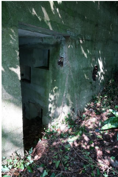
Vue générale de l'entrée est. A droite de l'entrée, prise d'air externe Phot. Guillaume Lécueillier IVR53_20242910259NUCA
