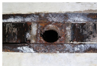
Vue intérieure : détail du plafond de la salle de garde ouest, puits pour un périscopes ? Phot. Guillaume Lécueillier IVR53_20242910302NUCA
