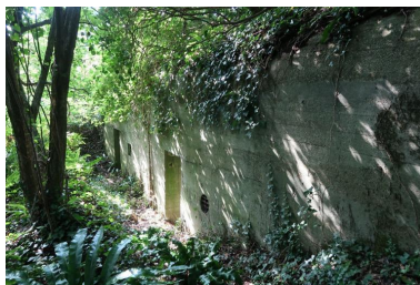
Vue générale : accès et élévation sud percée de deux entrées Phot. Guillaume Lécueillier IVR53_20242910253NUCA
