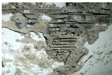
Vue du sas : détail du ferrailage du plafond. Il est blanchi à la chaux Phot. Guillaume Lécueillier IVR53_20242910294NUCA
