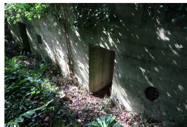
Vue générale : accès et élévation sud percée de deux entrées Phot. Guillaume Lécueillier IVR53_20242910254NUCA
