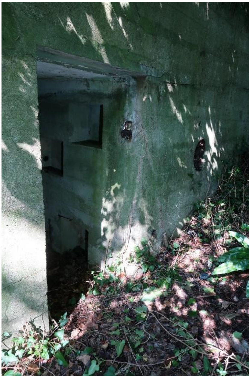
Vue générale de l'entrée est. A droite de l'entrée, prise d'air externe
