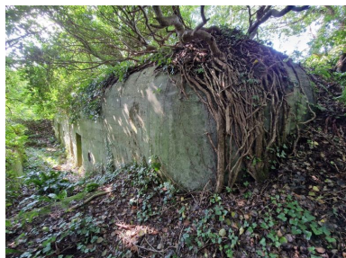
Vue générale Phot. Guillaume Lécueillier IVR53_20242910252NUCA
