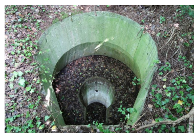
Vue de l'emplacement de la cloche blindée depuis l'extérieur. Ce bunker aurait dû être doté d'une cloche blindée de type 89P9 Phot. Guillaume Lécueillier IVR53_20242910269NUCA
