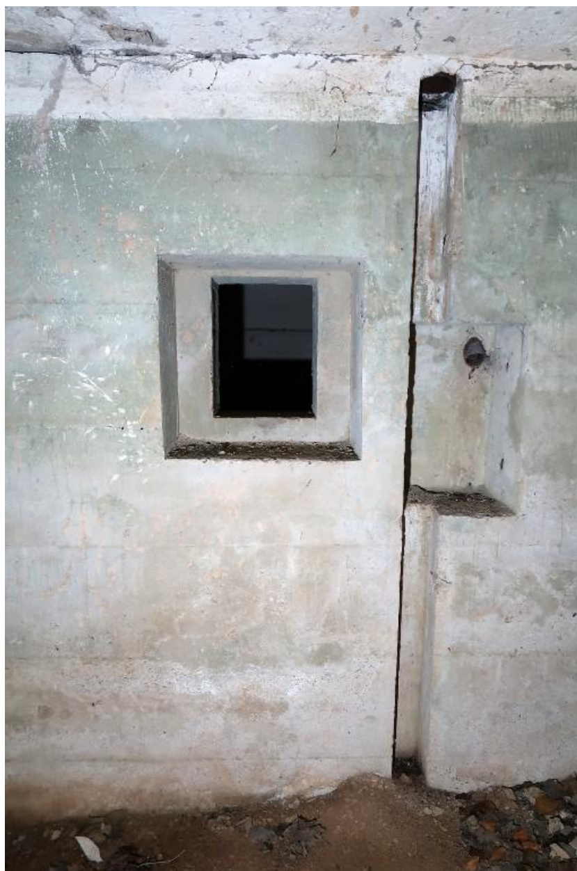
Vue de l'entrée ouest : couloir d'accès flanqué par un créneau de tir. Le créneau blindé n'a pas été posé. A droite, emplacement pour un puits d'antenne
