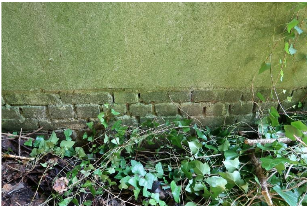
Vue du mur de protection de l'accès aux deux entrées : maçonnerie de brique et enduit
