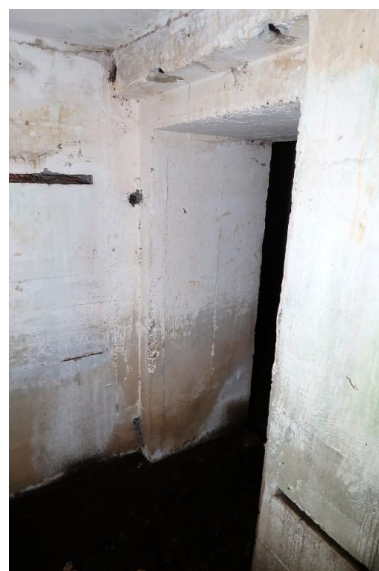
Vue de la petite pièce dédiée à la cloche blindée. Ce bunker aurait dû être doté d'une cloche blindée de type 89P9 Phot. Guillaume Lécueillier IVR53_20242910272NUCA
