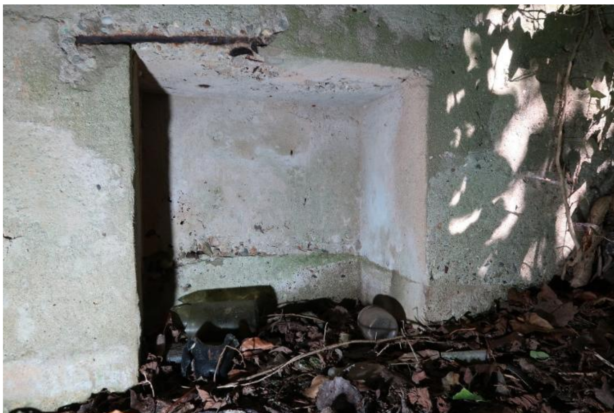
Vue de l'entrée est : couloir d'accès flanqué par un créneau de tir, niche murale basse
