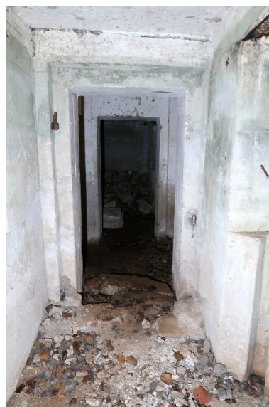
Vue du sas depuis l'entrée ouest. Les portes blindées ne semblent pas avoir été posées (des gonds ont cependant été mis en place) Phot. Guillaume Lécueillier IVR53_20242910290NUCA
