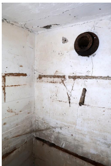
Vue intérieure : détail de l'angle sud-ouest de la de la salle de garde ouest avec l'emplacement de la conduite du poêle Phot. Guillaume Lécueillier IVR53_20242910300NUCA
