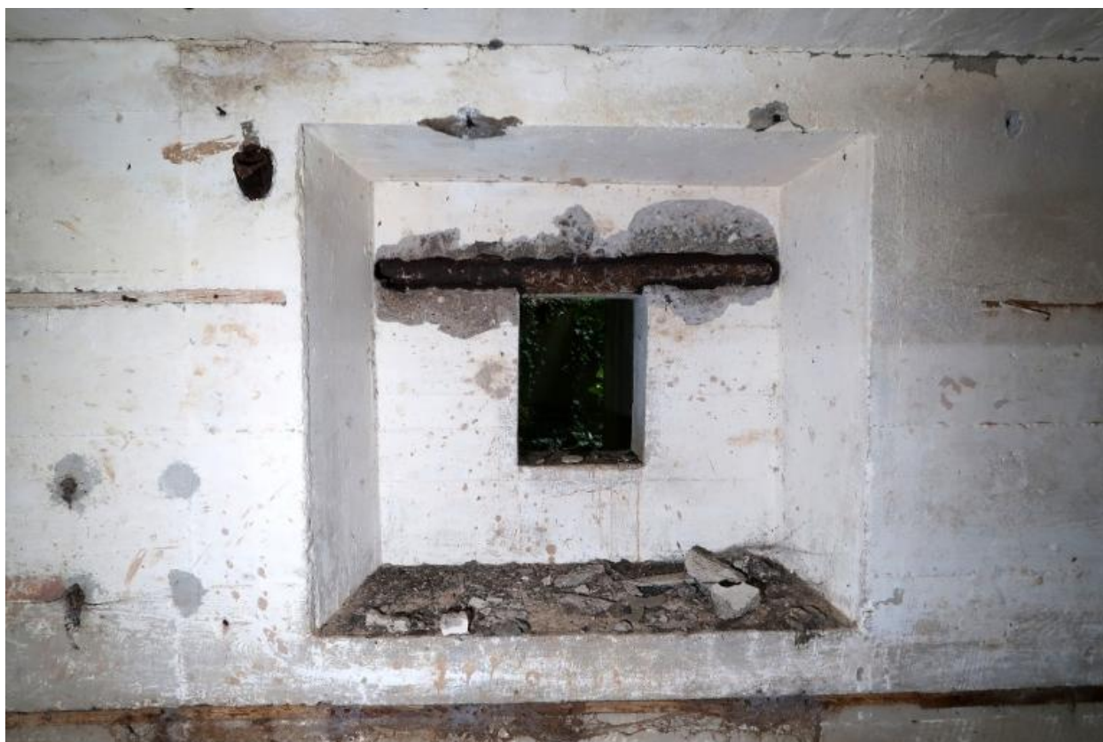
Vue intérieure : détail de l'emplacement du créneau blindé [non posé] de la salle de garde est
