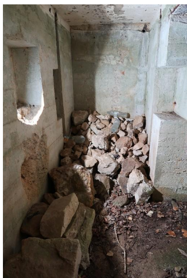
Vue de l'entrée est : couloir d'accès flanqué par un créneau de tir, extrémité orientale du couloir encombrée de pierres. de part et d'autre du couloir, emplacements de puits d'antenne Phot. Guillaume Lécueillier IVR53_20242910285NUCA
