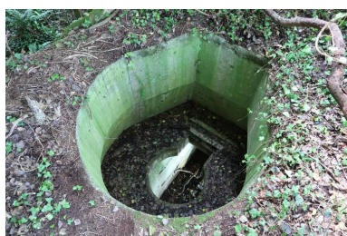
Vue de l'emplacement de la cloche blindée depuis l'extérieur. Ce bunker aurait dû être doté d'une cloche blindée de type 89P9 Phot. Guillaume Lécueillier IVR53_20242910267NUCA
