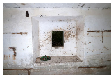
Vue intérieure : détail de l'emplacement du créneau blindé [non posé] de la salle de garde ouest Phot. Guillaume Lécueillier IVR53_20242910299NUCA
