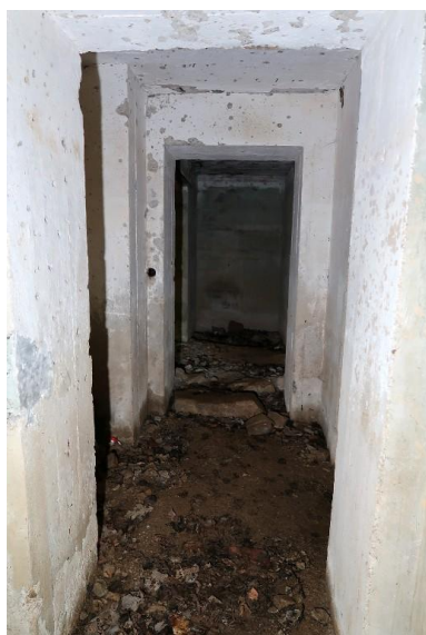
Vue générale du sas Phot. Guillaume Lécueillier IVR53_20242910291NUCA
