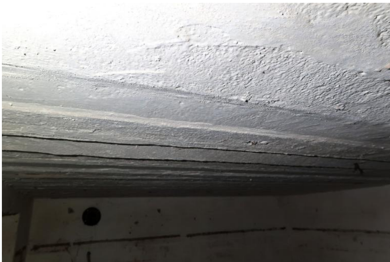
Vue intérieure : détail du plafond constitué de poutres en béton armé sur lesquelles a été coulée la dalle en béton armé
