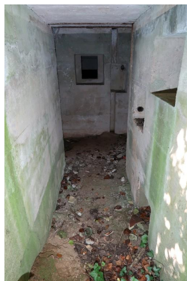
Vue de l'entrée ouest : couloir d'accès flanqué par un créneau de tir. Sur le mur de droite se trouvent trois niches murales Phot. Guillaume Lécueillier IVR53_20242910287NUCA
