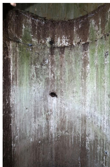
Vue de la petite pièce dédiée à la cloche blindée. Ce bunker aurait dû être doté d'une cloche blindée de type 89P9 Phot. Guillaume Lécueillier IVR53_20242910275NUCA
