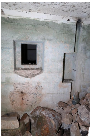
Vue de l'entrée est : couloir d'accès flanqué par un créneau de tir. Le créneau blindé n'a pas été posé. A droite, emplacement pour un puits d'antenne Phot. Guillaume Lécueillier IVR53_20242910286NUCA
