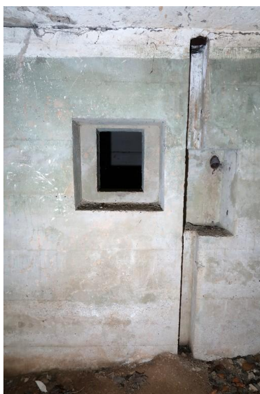
Vue de l'entrée ouest : couloir d'accès flanqué par un créneau de tir. Le créneau blindé n'a pas été posé. A droite, emplacement pour un puits d'antenne Phot. Guillaume Lécueillier IVR53_20242910289NUCA
