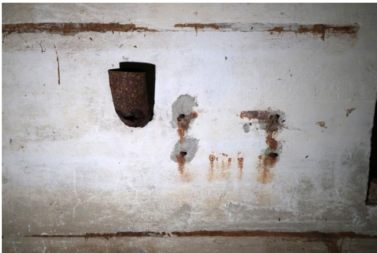
Vue intérieure : détail de la fixation du ventilateur de la salle de garde ouest et tube relié à la prise d'air extérieur
