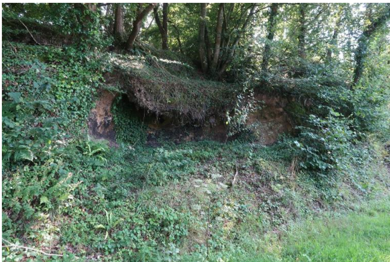
Vue de l'emplacement du réseau de tranchées et des postes d'observation et de tir situés à proximité du bunker - abri de type 502 pour deux groupes de combat. Le talus s'est effondré
