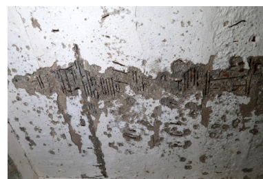
Vue du sas : détail du ferrailage du plafond. Il est blanchi à la chaux Phot. Guillaume Lécueillier IVR53_20242910293NUCA
