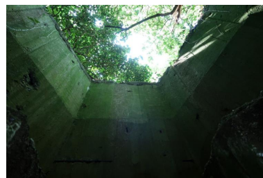
Vue de l'emplacement de la cloche blindée depuis l'intérieur. Ce
