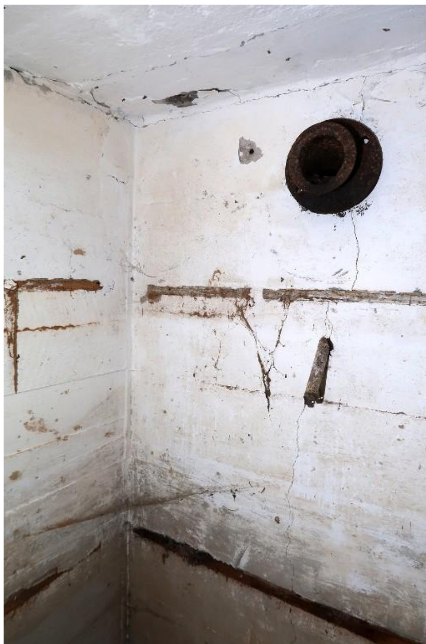
Vue intérieure : détail de l'angle sud-ouest de la de la salle de garde ouest avec l'emplacement de la conduite du poêle
