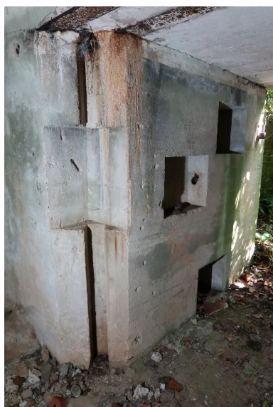
Vue de l'entrée ouest : couloir d'accès flanqué par un créneau de tir. Sur le mur se trouvent trois niches murales. A gauche, emplacement d'un puits d'antenne Phot. Guillaume Lécueillier IVR53_20242910288NUCA
