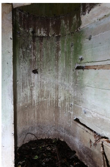
Vue de la petite pièce dédiée à la cloche blindée. Ce bunker aurait dû être doté d'une cloche blindée de type 89P9 Phot. Guillaume Lécueillier IVR53_20242910274NUCA
