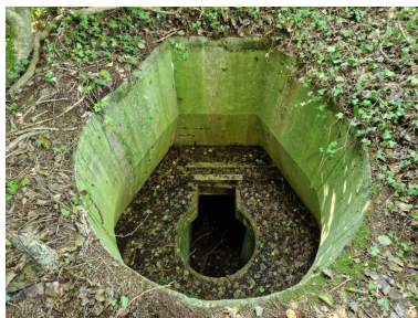
Vue de l'emplacement de la cloche blindée depuis l'extérieur. Ce bunker aurait dû être doté d'une cloche blindée de type 89P9 Phot. Guillaume Lécueillier IVR53_20242910265NUCA
