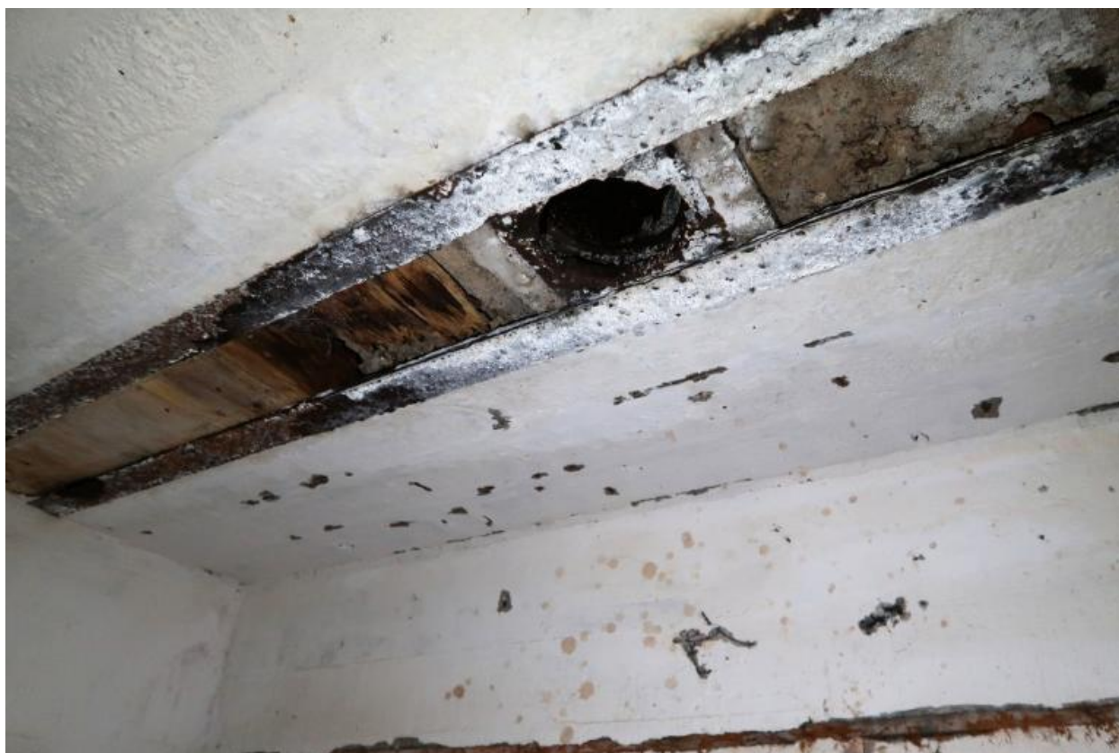
Vue intérieure : détail du plafond de la salle de garde est, puits pour un périscope ?
