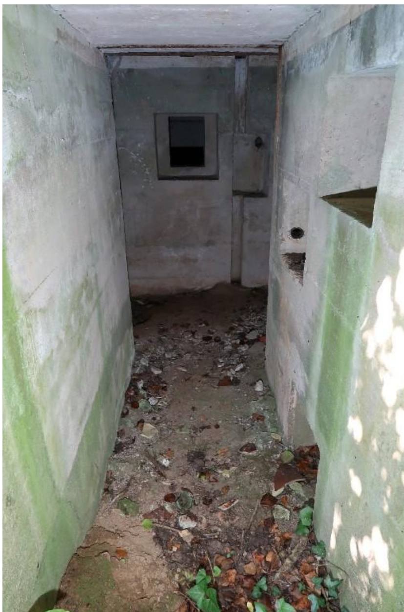
Vue de l'entrée ouest : couloir d'accès flanqué par un créneau de tir. Sur le mur de droite se trouvent trois niches murales
