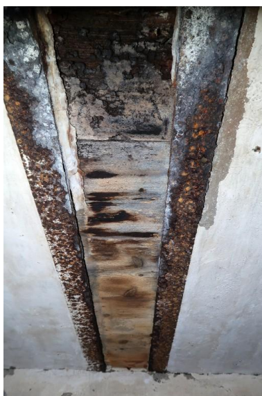
Vue intérieure : détail du plafond de la salle de garde ouest, puits pour un périscopes ? Phot. Guillaume Lécueillier IVR53_20242910301NUCA
