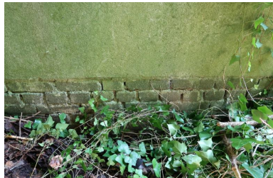
Vue du mur de protection de l'accès aux deux entrées : maçonnerie de brique et enduit Phot. Guillaume Lécueillier IVR53_20242910258NUCA
