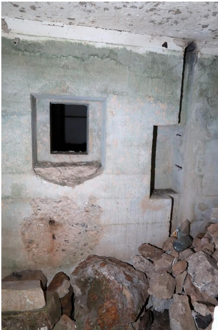
Vue de l'entrée est : couloir d'accès flanqué par un créneau de tir. Le créneau blindé n'a pas été posé. A droite, emplacement pour un puits d'antenne
