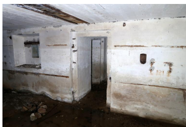
Vue intérieure : unique entrée des salles de garde est et ouest. La porte blindée ne semble pas avoir été posée (des gonds ont cependant été mis en place). De part et d'autre de la porte : créneau blindé [non posé] emplacement du ventilateur Phot. Guillaume Lécueillier IVR53_20242910295NUCA
