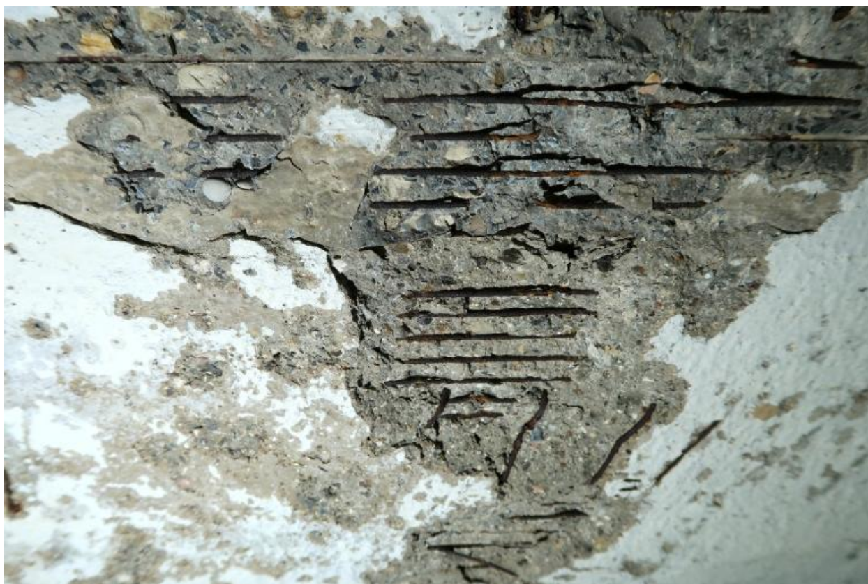
Vue du sas : détail du ferrailage du plafond. Il est blanchi à la chaux
