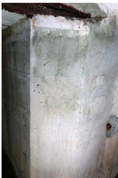
Vue du sas : angle biseauté favorisant le passage Phot. Guillaume Lécueillier IVR53_20242910292NUCA
