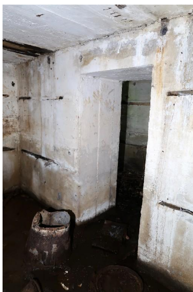
Vue de l'entrée de la petite pièce dédiée à la cloche blindée. Ce bunker aurait dû être doté d'une cloche blindée de type 89P9 Phot. Guillaume Lécueillier IVR53_20242910271NUCA
