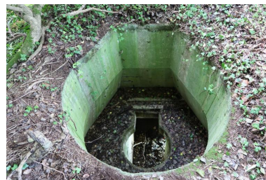
Vue de l'emplacement de la cloche blindée depuis l'extérieur. Ce bunker aurait dû être doté d'une cloche blindée de type 89P9 Phot. Guillaume Lécueillier IVR53_20242910266NUCA
