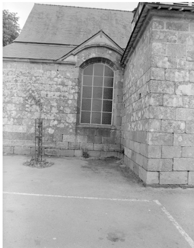
Nef, élévation sud : première fenêtre Phot. François Dagorn IVR53_19762200169X
