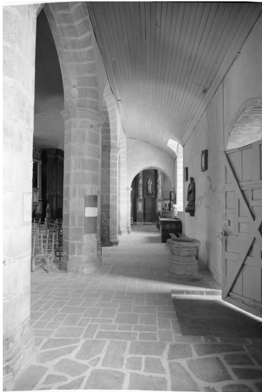
Bas-côté sud : vue axiale ouest-est Phot. François Dagorn IVR53_19692200729V
