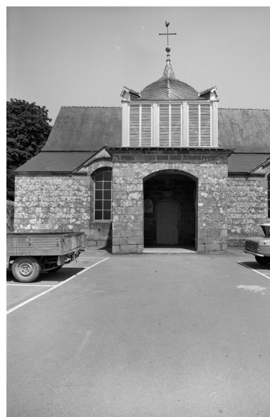
Façade sud, porche : face sud Phot. François Dagorn IVR53_19692200775V
