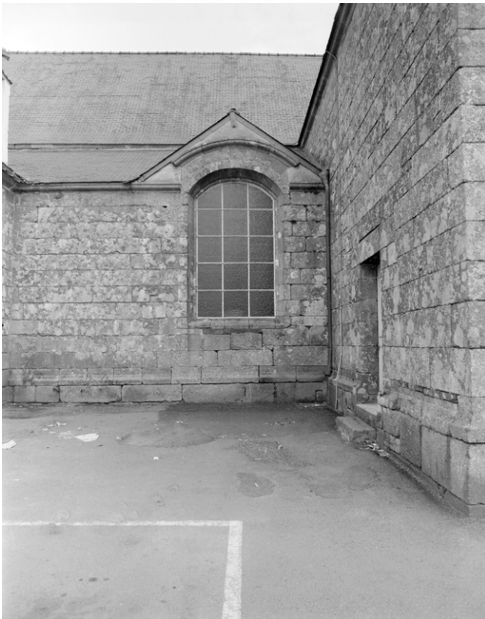
Nef, élévation sud, deuxième fenêtre est
