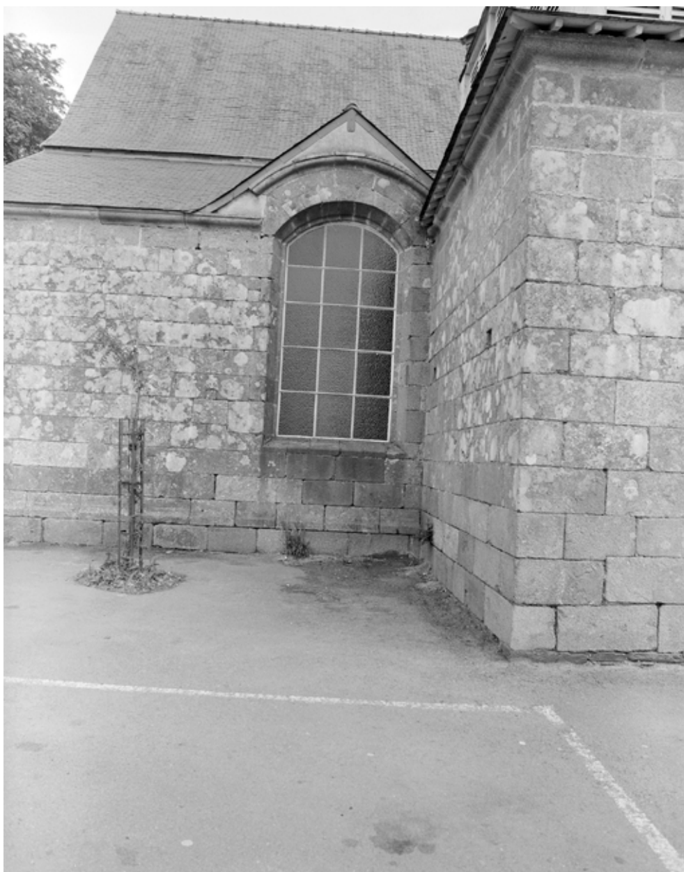
Nef, élévation sud : première fenêtre
