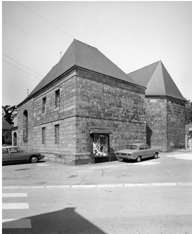
Façade sud et est, croisillon sud : sacristie et chevet Phot. François Dagorn IVR53_19692200777V
