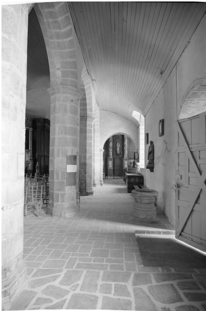
Bas-côté sud : vue axiale ouest-est
