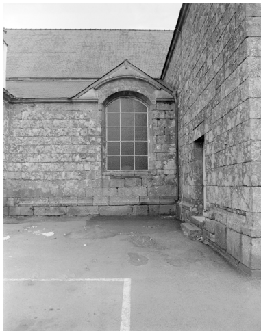
Nef, élévation sud, deuxième fenêtre est Phot. Service régional de l'Inventaire de Bretagne IVR53_19762200168X
