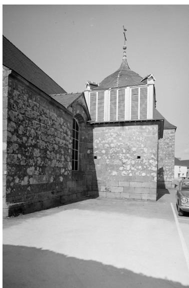
Façade sud, porche : face ouest Phot. François Dagorn IVR53_19692200795V
