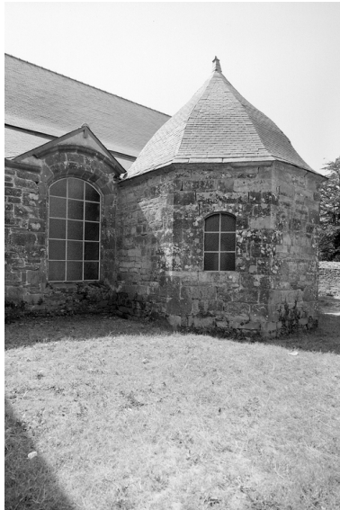
Façade nord : chapelle baptismale Phot. François Dagorn IVR53_19692200776V
