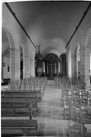
Nef et choeur : vue axiale ouest-est Phot. François Dagorn IVR53_19692200733V
