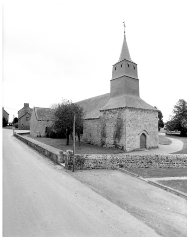
Elévation Nord-Ouest : vue générale Phot. Guy Artur, Phot. Norbert Lambart IVR53_19943500730X
