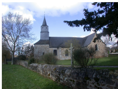
Vue générale Sud avec l'enclos Phot. Véronique Orain IVR53_20063506992NUC
