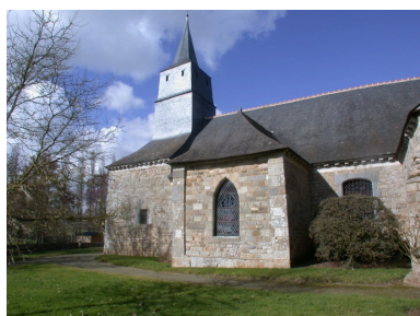
Façade Sud, ossuaire Phot. Véronique Orain IVR53_20063506999NUC
