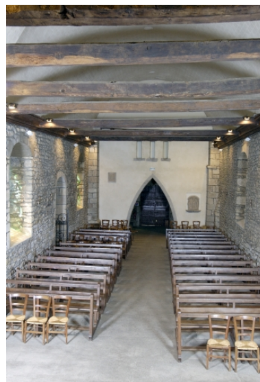
Vue intérieure prise du chœur vers la nef Phot. Alain Dagorn IVR53_20063500851NUCA
