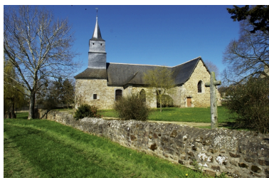
Vue générale Sud avec l'enclos et la croix Phot. Norbert Lambart IVR53_20063500491NUCA
