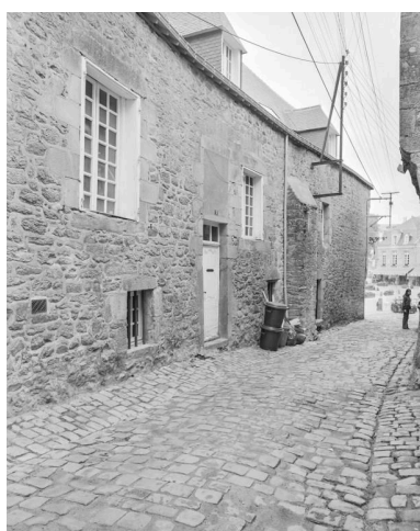
Vue générale de l'élévation latérale sur la rue du Petit Port Phot. François Dagorn IVR53_19785600601X
