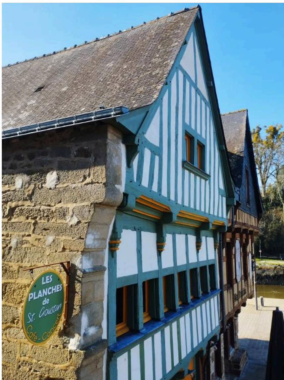
Détail du premier étage en encorbellement sur solives
