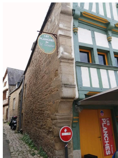
Détail du rez-de-chaussée et du mur gouttereau Phot. Eva Laurent IVR53_20245610633NUC
