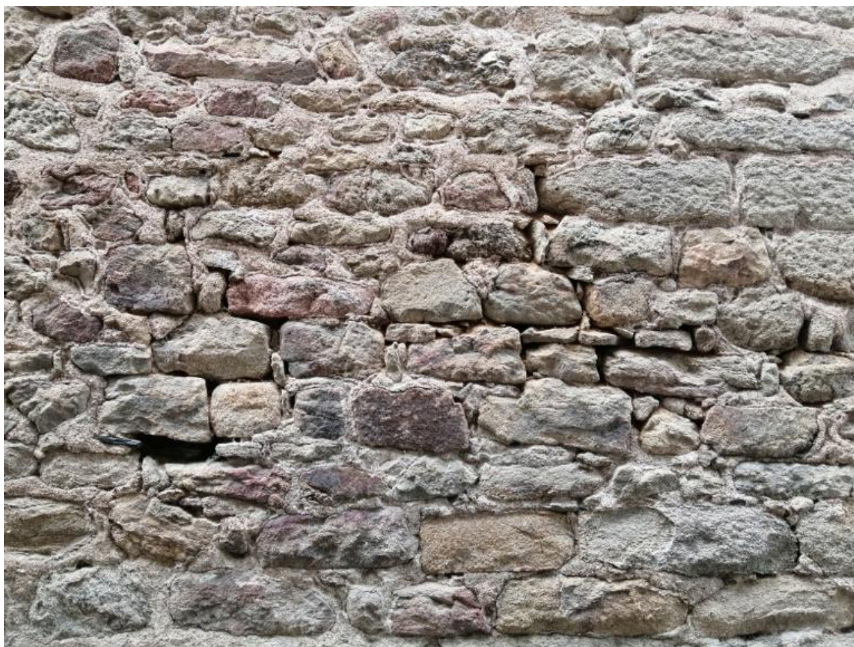
Détail des matériaux utilisés dans le mur sise Rue du Petit Port
