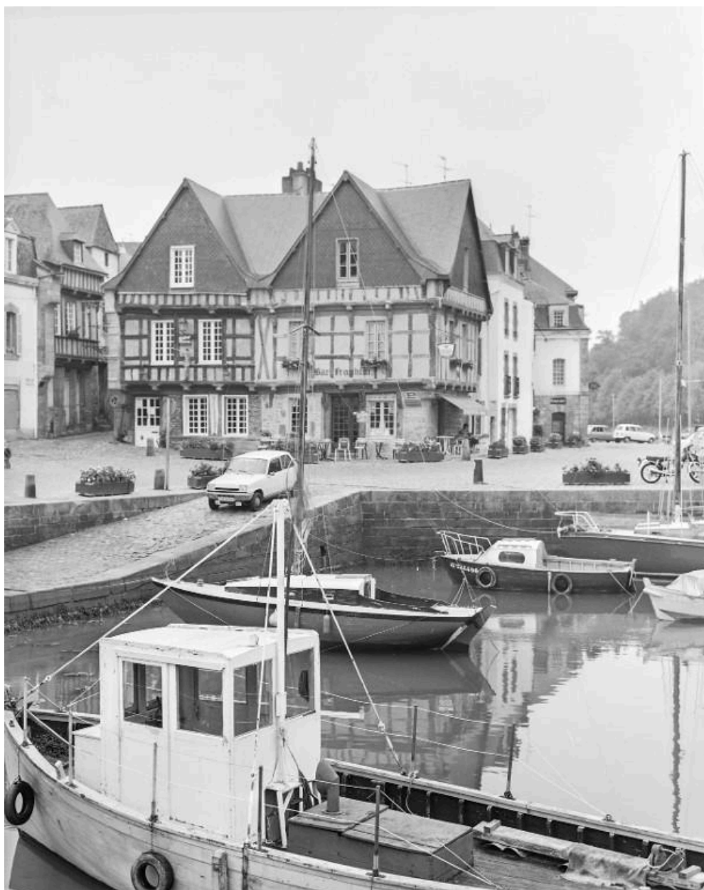
Vue de situation prise du nord.
