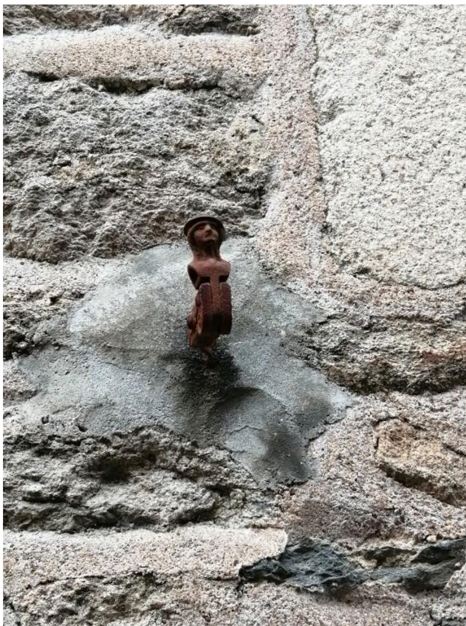
Détail des battants de volets dans le mur sise rue du Petit Port
