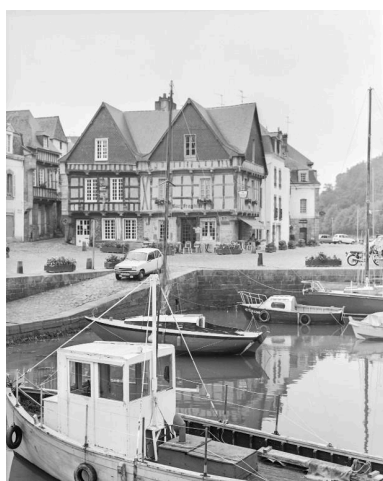
Vue de situation prise du nord. Phot. François Dagorn IVR53_19785600599X
