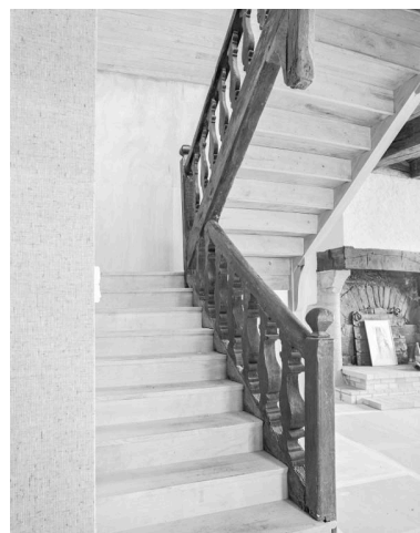
Escalier, garde corps à balustres découpés Phot. François Dagorn IVR53_19785600565X
