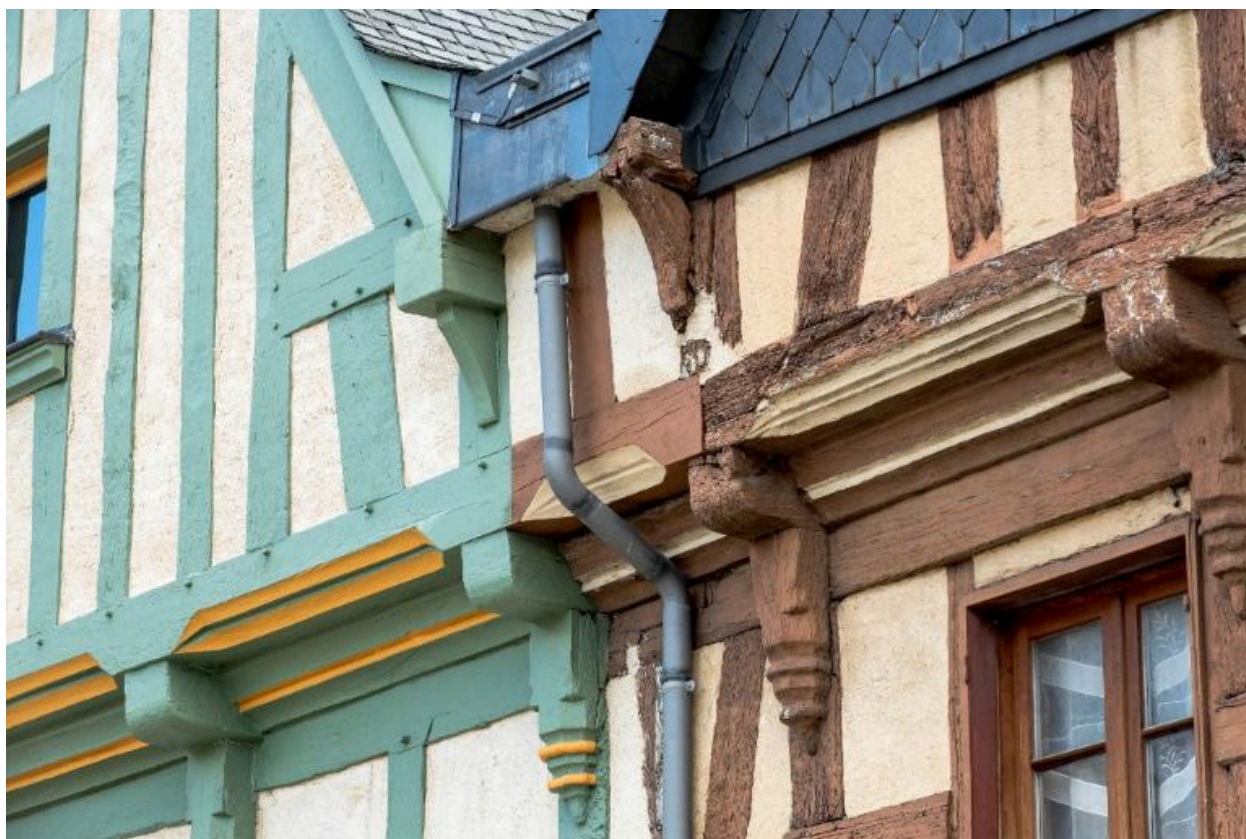
Jonction entre les deux maisons
