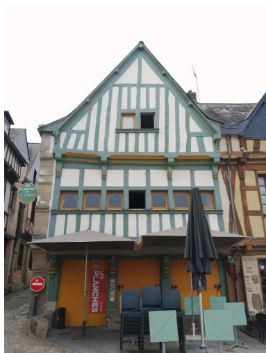
Façade principale en pan de bois avec encorbellement sur solives Phot. Eva Laurent IVR53_20245610629NUC
