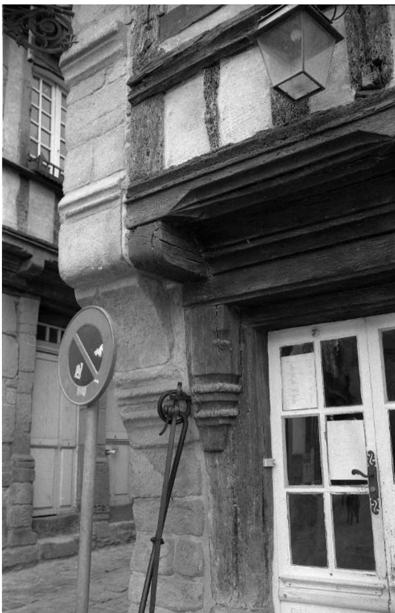
Détail dur mur pare-feu et du rez-de-chaussée
