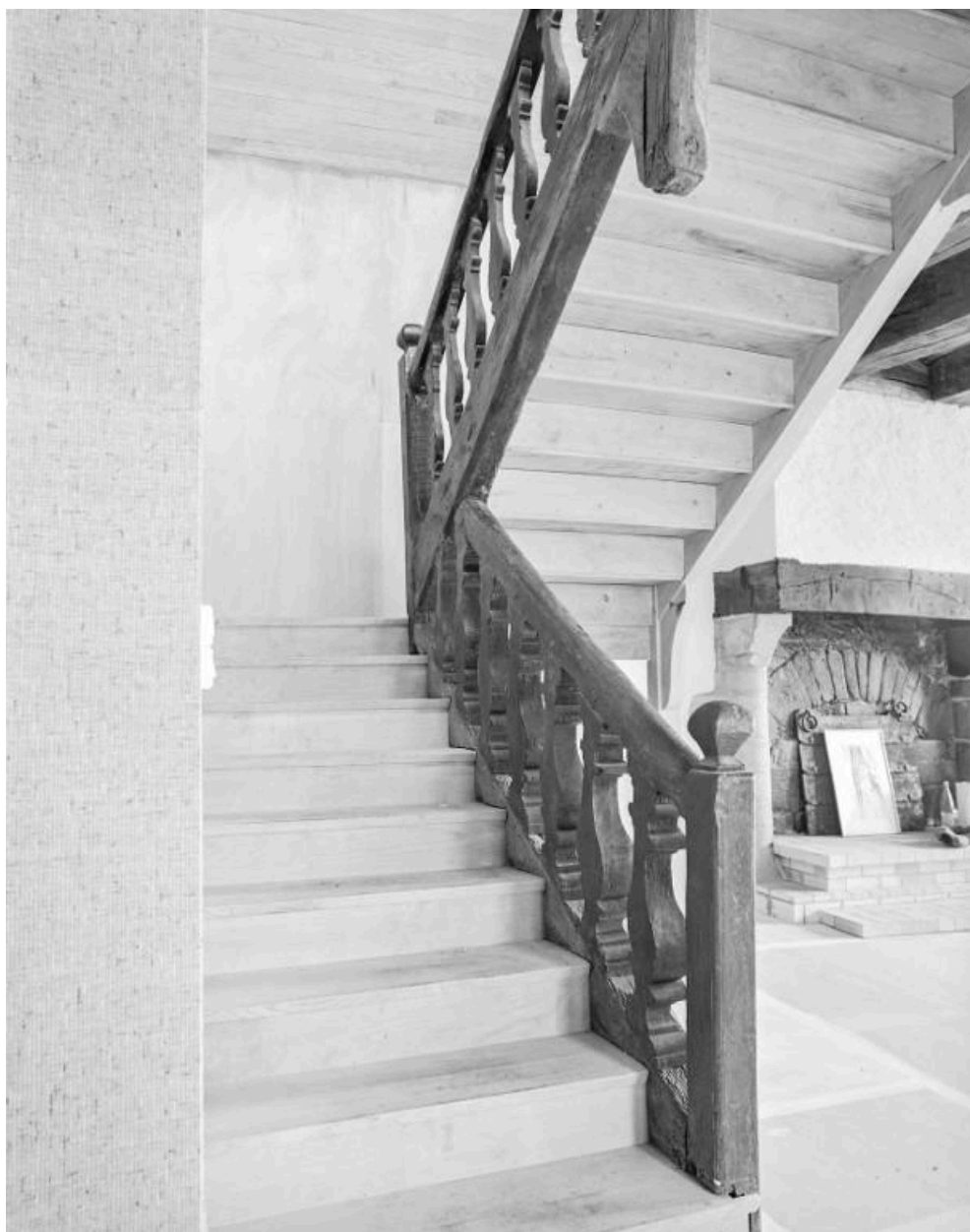
Escalier, garde corps à balustres découpés
