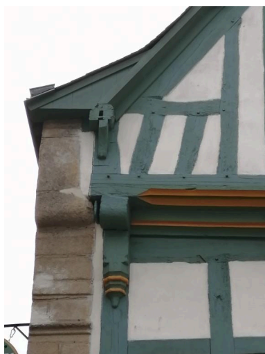
Détail de trous dans les poteaux et solives Phot. Eva Laurent IVR53_20245610636NUC
