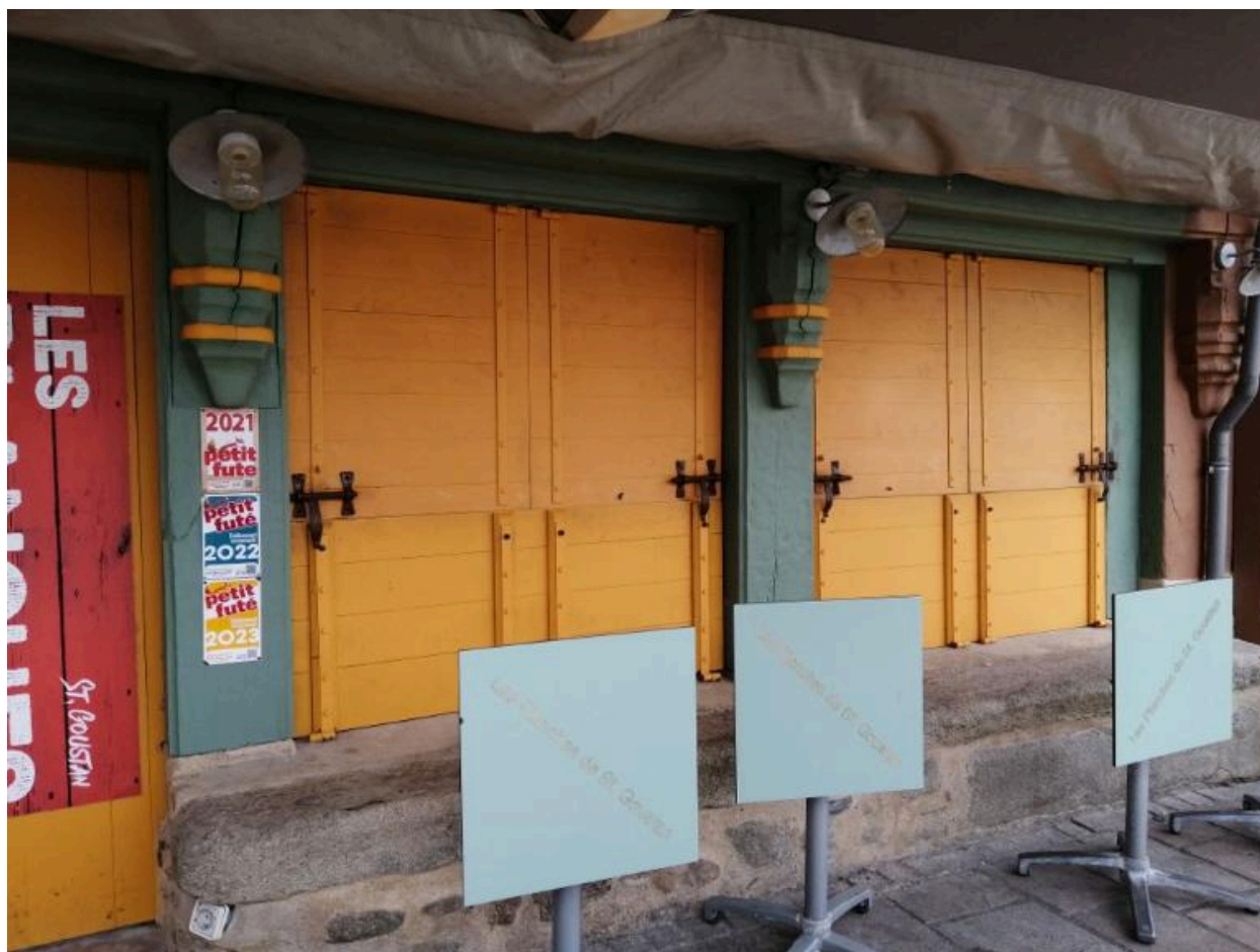
Détail des ouvertures du rez-de-chaussée
