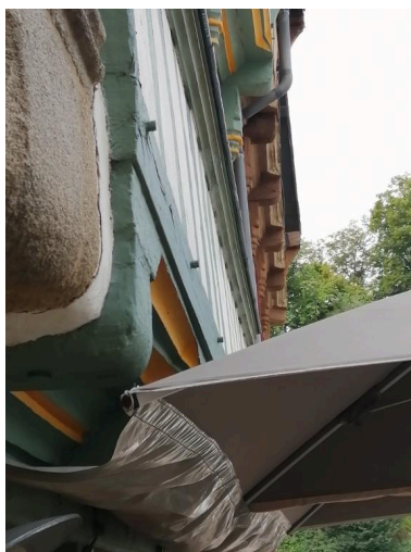
Détail des entretoises Phot. Eva Laurent IVR53_20245610632NUC
