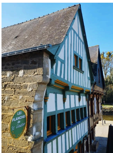
Détail du premier étage en encorbellement sur solives Phot. Hugo Fève IVR53_20245610627NUC
