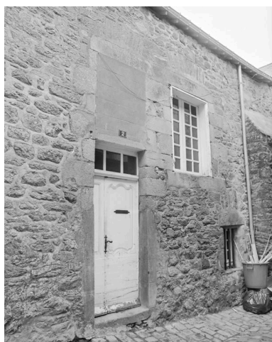
Elévation latérale sur la rue du Petit Port, détail de la porte Phot. François Dagorn IVR53_19785600602X
