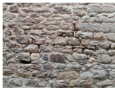
Détail des matériaux utilisés dans le mur sise Rue du Petit Port Phot. Eva Laurent IVR53_20245610635NUC
