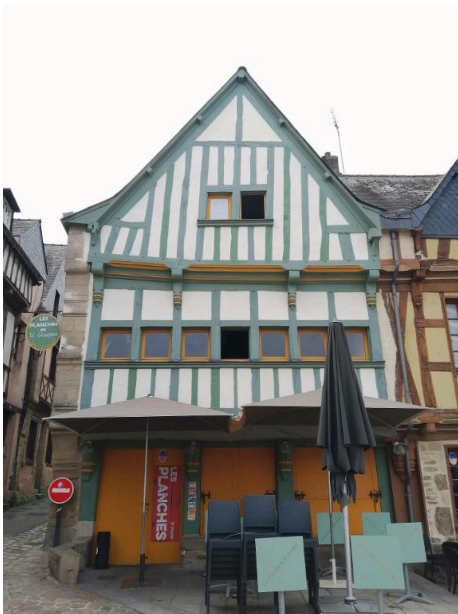
Façade principale en pan de bois avec encorbellement sur solives
