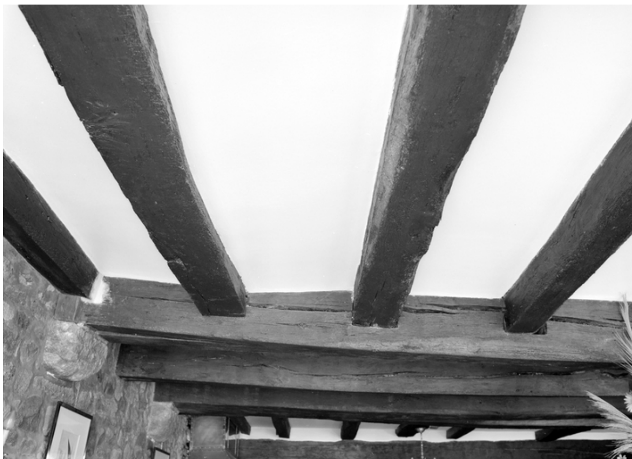
Intérieur, poutraison du rez-de-chaussée
