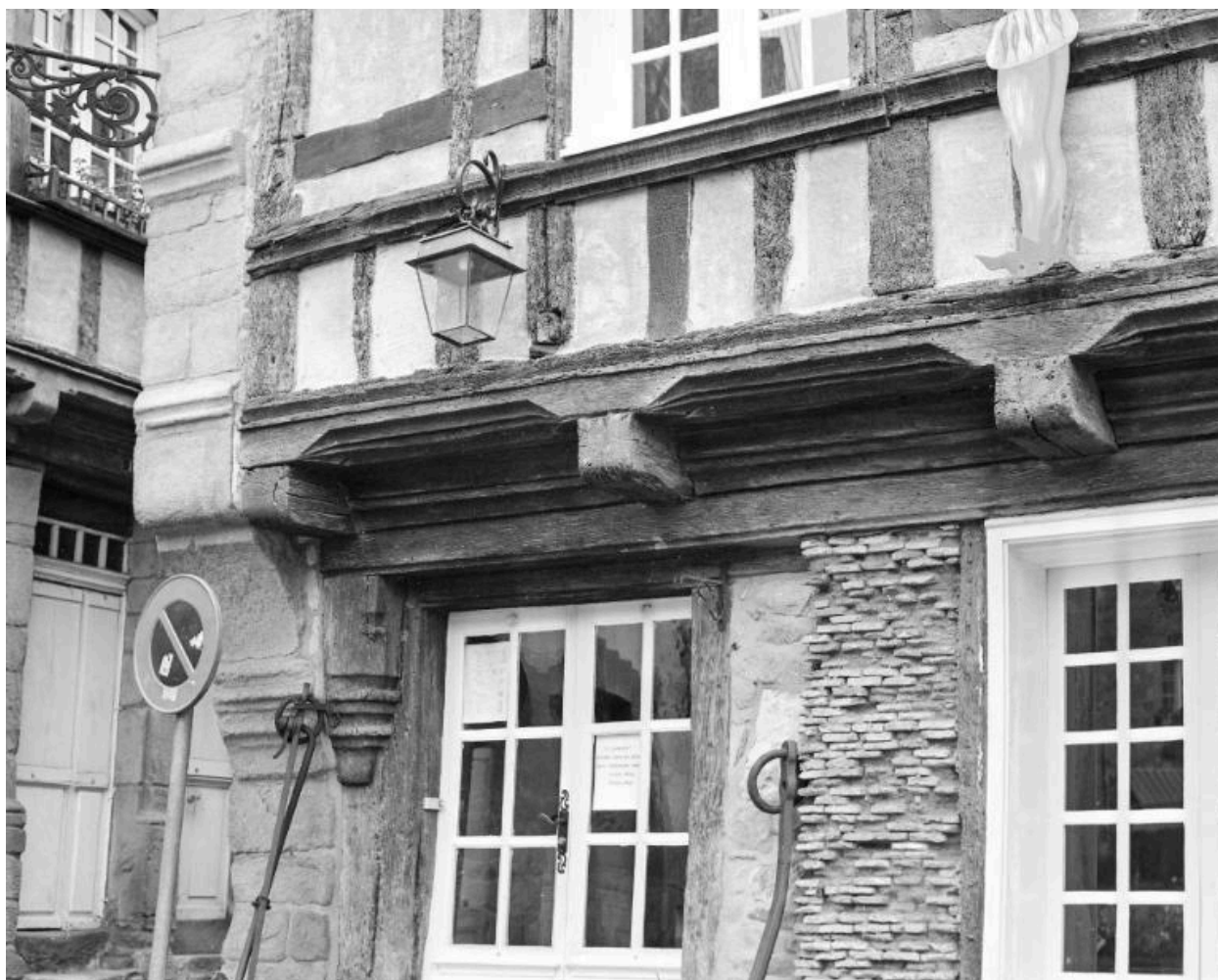
Elévation antérieure, détail de l'encorbellement inférieur, à consoles et entretoises moulurés
