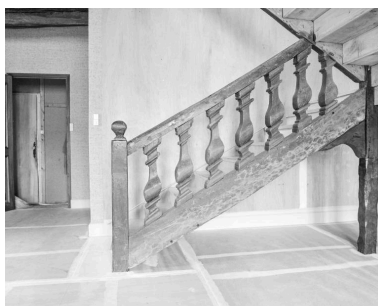
Escalier, garde corps à balustres de plan carré Phot. François Dagorn IVR53_19785600566X
