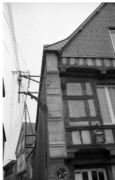
Détail dur mur pare-feu et des étages Phot. Auteur inconnu IVR53_19815605122Z
