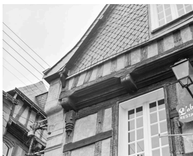
Elévation antérieure, détail de l'encorbellement supérieur Phot. François Dagorn IVR53_19785600604X
