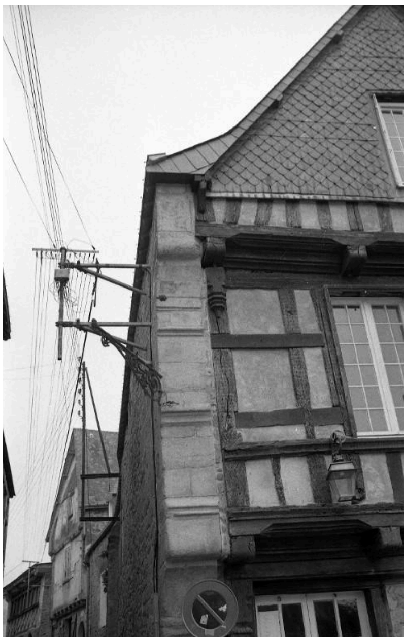
Détail dur mur pare-feu et des étages
