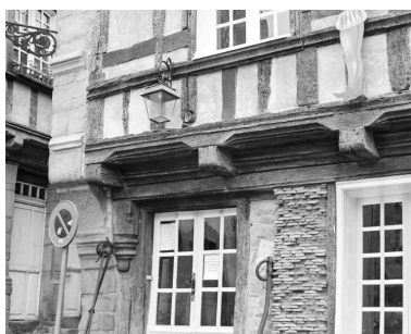
Elévation antérieure, détail de l'encorbellement inférieur, à consolés et entretoises moulurés Phot. François Dagorn IVR53_19785600605X
