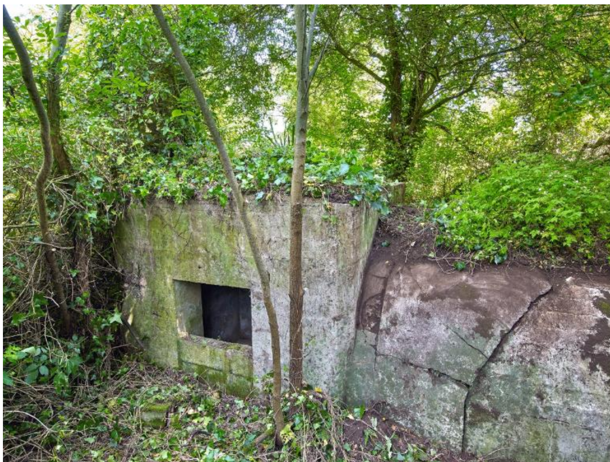
Vue du bunker - poste d'observation et de tir de type 58c dit Tobruk-Stand Est, accolé au bunker - abri de type 502 situé à l'extrémité Est de la pointe : entrée. Son entrée est partiellement murée par des parpaings. La tranchée d'accès des deux bunkers est remblayée par des déchets
