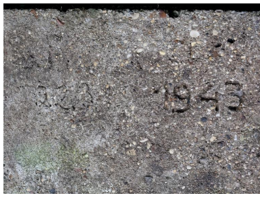
Vue du parapet du mur de clôture et de soutènement ceinturant le domaine : emplacement de tir situé à l'extrémité Est de la pointe près du bunker - casemate VF, date de construction dessinée dans le béton frais, 22.3.43 Phot. Bernard Bègne IVR53_20232200391NUCA
