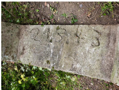
Vue du parapet du mur de clôture et de soutènement ceinturant le domaine : emplacement de tir situé à l'extrémité Est de la pointe près du bunker - casemate VF, date de construction dessinée dans le béton frais, 21.3.43 Phot. Bernard Bègne IVR53_20232200388NUCA
