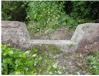
Vue du parapet du mur de clôture et de soutènement ceinturant le domaine : emplacement de tir situé à l'extrémité Est de la pointe près du bunker - casemate VF Phot. Bernard Bègne IVR53_20232200385NUCA
