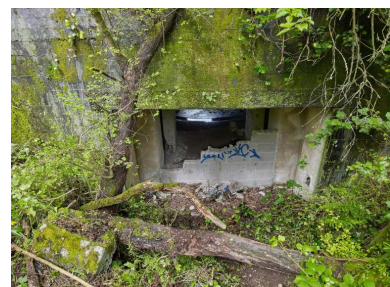
Vue du bunker - casemate de type 612 pour un canon de campagne ou obusier de 7,62 cm ou 10,5 cm situé à l'extrémité Est de la pointe : entrée (photographiée de l'extérieur). L'entrée du bunker est partiellement murée par des parpaings Phot. Bernard Bègne IVR53_20232200286NUCA
