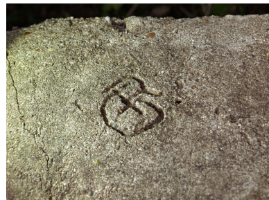
Vue du parapet du mur de clôture et de soutènement ceinturant le domaine : emplacement de tir situé à l'extrémité Est de la pointe près du bunker - casemate VF, inscription - acronyme dessinée dans le béton frais (initiales entrelacées GR pour Grenadier-Regiment, régiment de grenadier ?) Phot. Bernard Bègne IVR53_20232200389NUCA
