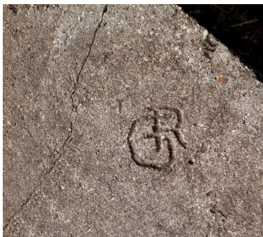
Vue du parapet du mur de clôture et de soutènement ceinturant le
