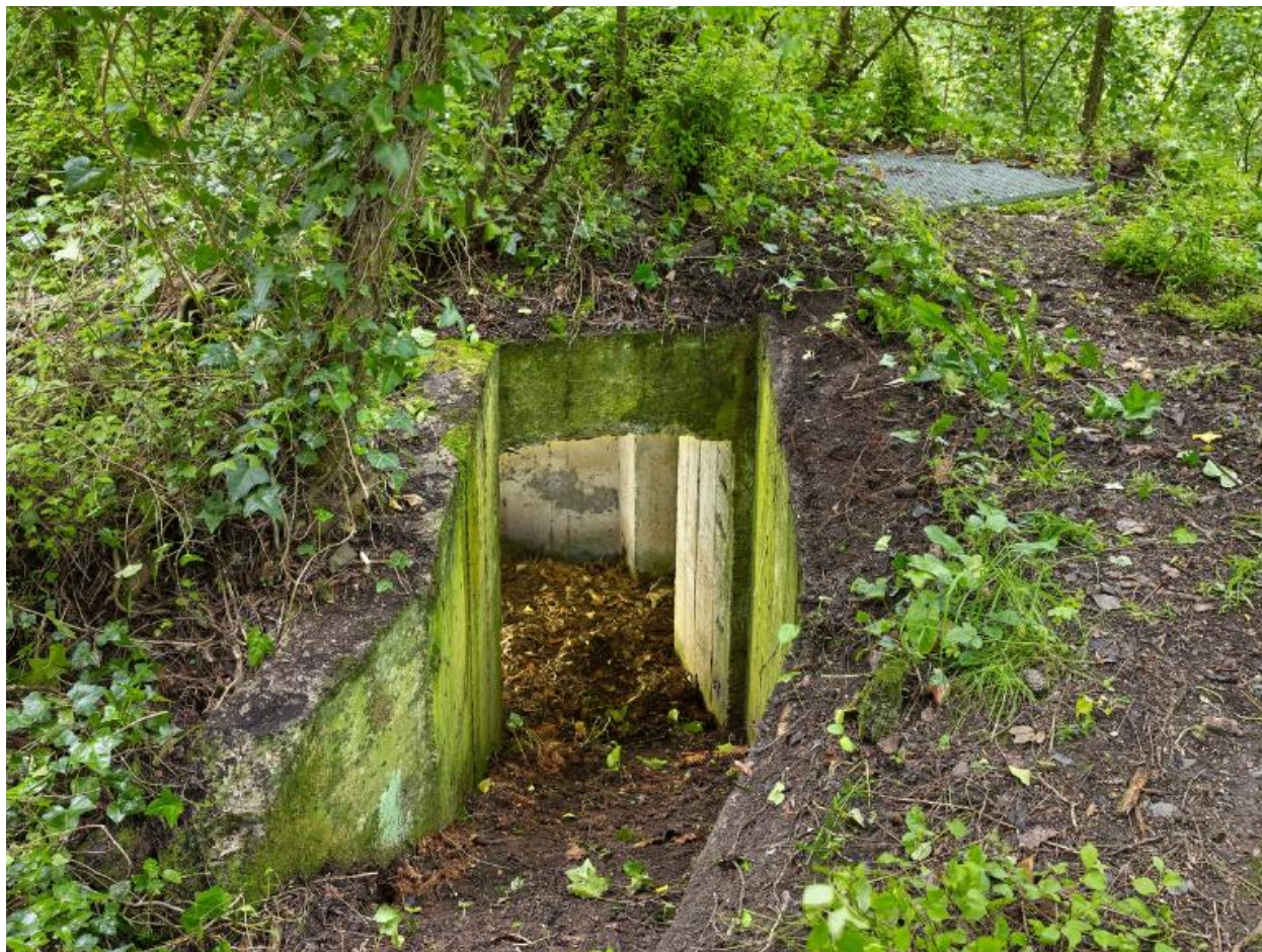
Vue du bunker - poste d'observation et de tir de type 58c dit Tobruk-Stand implanté au sommet du versant Nord vers le Gouët. Une grille protège le poste d'observation et de tir circulaire des risques de chute
