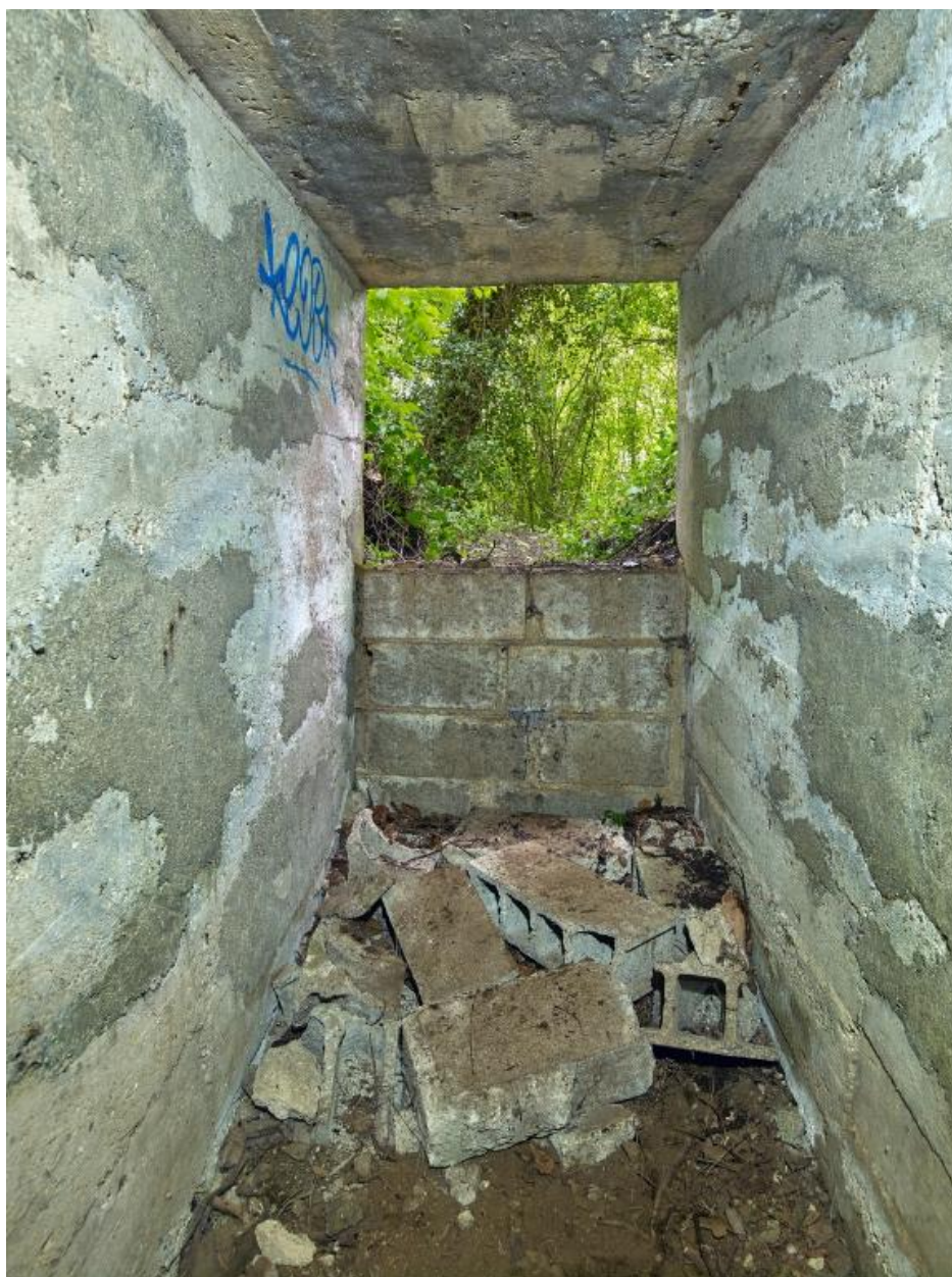
Vue du bunker - casemate de flanquement implanté sur le versant Nord vers le Gouët : entrée du tunnel. Normalement de plain-pied, l'entrée du tunnel est partiellement murée par des parpaings
