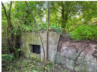
Vue du bunker - poste d'observation et de tir de type 58c dit Tobruk-Stand Est, accolé au bunker - abri de type 502 situé à l'extrémité Est de la pointe : entrée. Son entrée est partiellement murée par des parpaings. La tranchée d'accès des deux bunkers est remblayée par des déchets Phot. Bernard Bègne IVR53_20232200399NUCA
