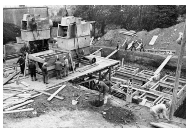
Exemple de chantier de construction d'un bunker à Brest (1 100 m3). Au centre, les deux bétonnières Regulus Großmischer (type B, 20 m3 ou C, 15 m3 ?) fabriquées par Seelemann & Söhne à Neustadt-Orla sont positionnées pour la coulée du béton Autr. Auteur inconnu IVR53_20222905965NUCA
