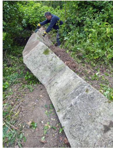
Vue du parapet du mur de clôture et de soutènement ceinturant le domaine : emplacement de tir situé à l'extrémité Est de la pointe près du bunker - casemate VF. L'ensemble a basculé : les traces d'un impact sont visibles. Sur cette photographie, Guillaume Lécueillier, chargé d'études Phot. Bernard Bègne IVR53_20232200387NUCA
