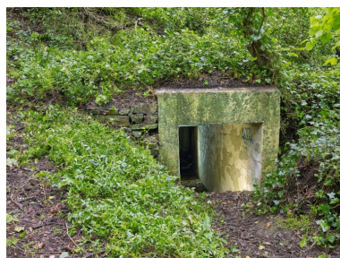
Vue du bunker - casemate de flanquement implanté sur le versant Nord vers le Gouët : entrée du tunnel. Normalement de plain-pied, l'entrée du tunnel est partiellement murée par des parpaings Phot. Bernard Bègne IVR53_20232200275NUCA
