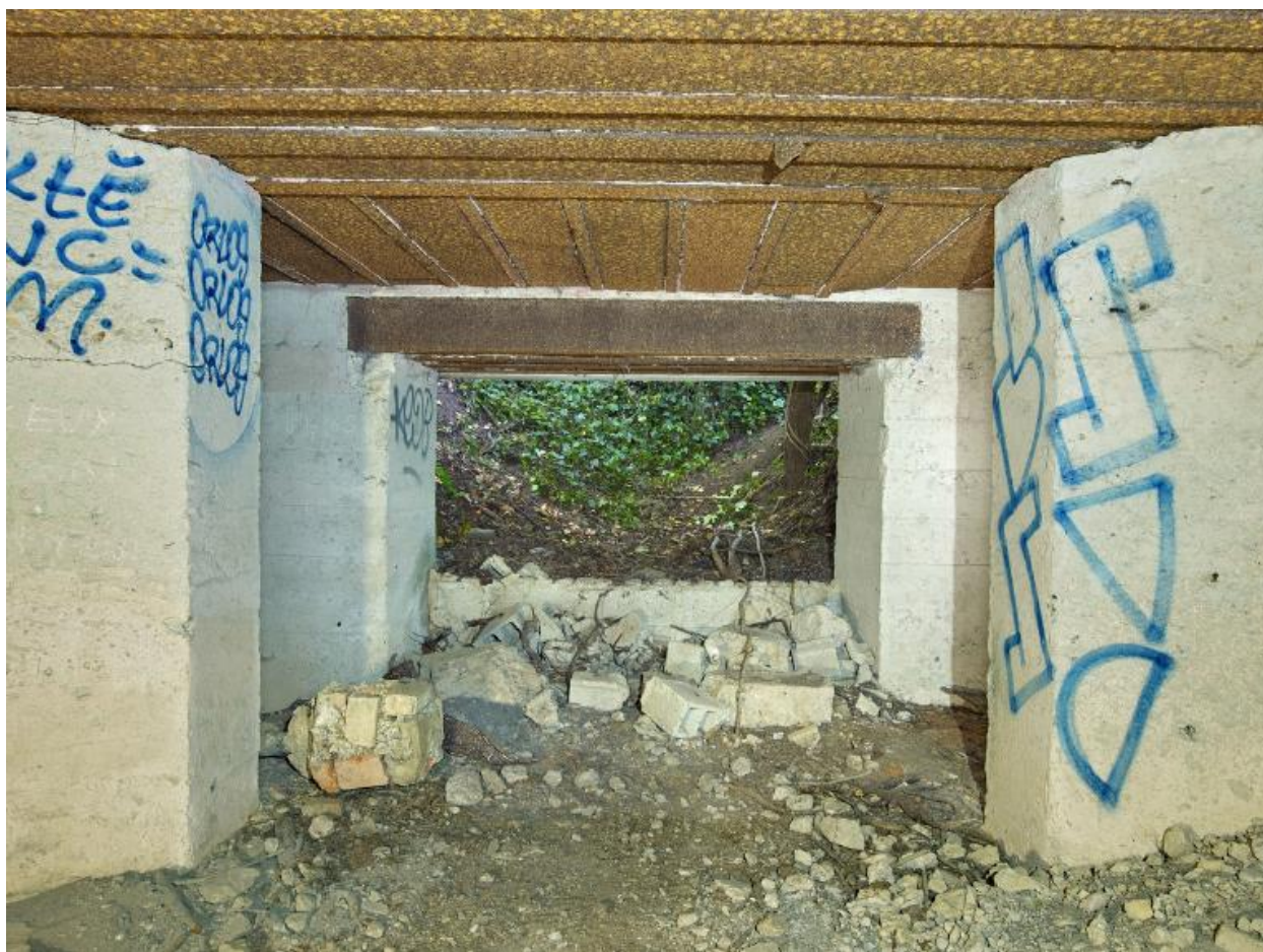
Vue du bunker - casemate de type 680 pour un canon de 7,5 cm ou 7,62 cm situé au Sud : chambre de tir (depuis l'embrasure vers la porte du bunker partiellement murée par des parpaings). De part et d'autre du passage d'entrée sont situées les deux soutes à munitions
