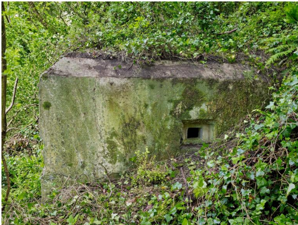
Vue du bunker - casemate de flanquement implanté sur le versant Nord vers le Gouët. Ses deux ouvertures de tir permettaient un tir perpendiculaire à la pente (ici, celle orientée vers l'Ouest)
