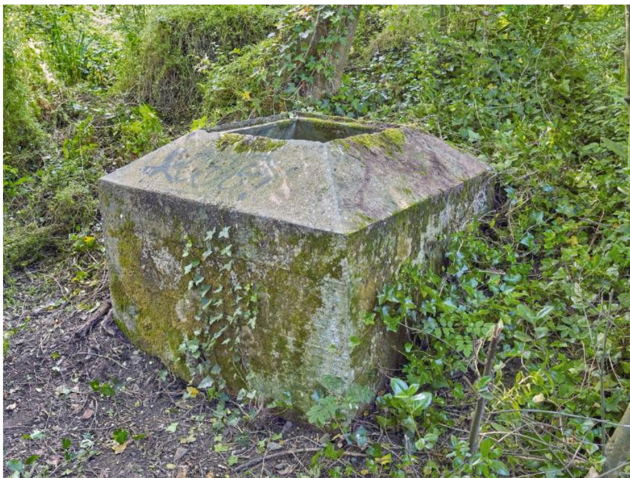
Vue de la niche à munitions en béton (puis citerne ?) situé au Sud (déplacée ?). L'orifice de plan carré était fermé par une trappe (65 cm x 65 cm)
