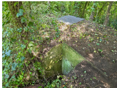
Vue du bunker - poste d'observation et de tir de type 58c dit Tobruk-Stand implanté au Sud près du bunker - casemate de type 680. Son entrée est murée par des parpaings. Une grille protège le poste d'observation et de tir circulaire des risques de chute Phot. Bernard Bègne IVR53_20232200492NUCA
