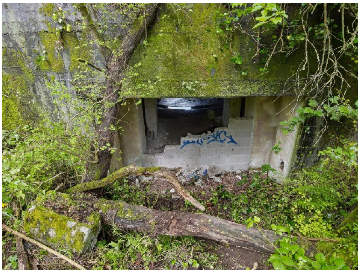
Vue du bunker - casemate de type 612 pour un canon de campagne ou obusier de 7,62 cm ou 10,5 cm situé à l'extrémité Est de la pointe : entrée (photographiée de l'extérieur). L'entrée du bunker est partiellement murée par des parpaings
