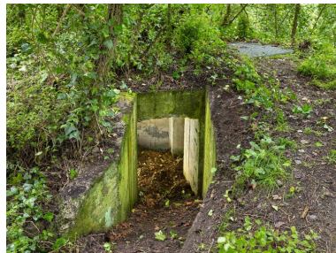
Vue du bunker - poste d'observation et de tir de type 58c dit Tobruk-Stand implanté au sommet du versant Nord vers le Gouët. Une grille protège le poste d'observation et de tir circulaire des risques de chute Phot. Bernard Bègne IVR53_20232200273NUCA
