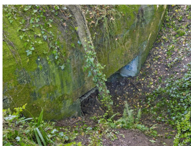
Vue du bunker - casemate de type 680 pour un canon de 7,5 cm ou 7,62 cm situé au Sud : emplacement de l'entrée (photographiée de l'extérieur). Son entrée est partiellement murée par des parpaings et remblayée. Enterré dans le sol, le bunker est masqué par la végétation Phot. Bernard Bègne IVR53_20232200422NUCA
