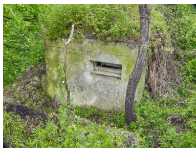
Vue du bunker - poste d'observation et de tir situé à l'extrémité Est de la pointe : embrasure orientée vers le Nord-nord-ouest (vers le bunker - casemate de type 612). Le bunker est adossé au parapet du mur de clôture du domaine Phot. Bernard Bègne IVR53_20232200302NUCA
