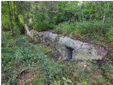
Vue du bunker - abri de type 502 situé à l'extrémité Est de la pointe : entrée Sud (ce type de bunker est dotée de deux entrées). La tranchée d'accès au bunker est remblayée par des déchets. A l'extrémité Nord se trouve, un poste d'observation et de tir de type 58c dit Tobruk-Stand Phot. Bernard Bègne IVR53_20232200416NUCA
