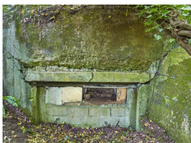
Vue du bunker - casemate de type 680 pour un canon de 7,5 cm ou 7,62 cm situé au Sud : embrasure (photographiée de l'extérieur). L'embrasure est partiellement murée par des parpaings Phot. Bernard Bègne IVR53_20232200429NUCA
