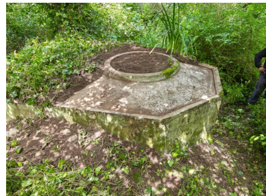
Vue du bunker - poste d'observation et de tir de type 58c dit Tobruk-Stand Est, accolé au bunker - abri de type 502 situé à l'extrémité Est de la pointe : une mince dalle de béton protège le poste d'observation et de tir circulaire des risques de chute Phot. Bernard Bègne IVR53_20232200397NUCA
