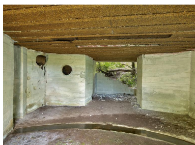
Vue du bunker - casemate de type 612 pour un canon de campagne ou obusier de 7,62 cm ou 10,5 cm situé à l'extrémité Est de la pointe : entrée (photographiée de l'intérieur). L'entrée du bunker est partiellement murée par des parpaings Phot. Bernard Bègne IVR53_20232200297NUCA
