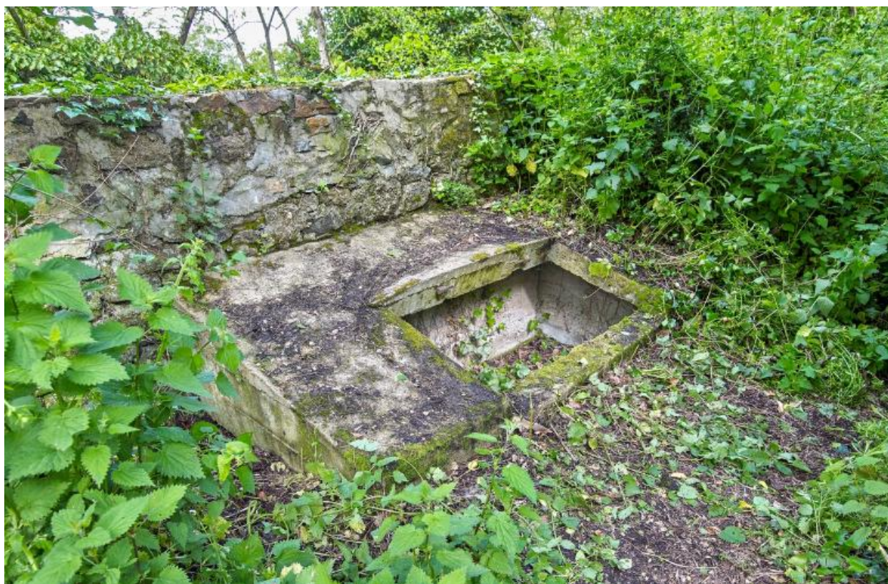
Vue de la niche à munitions en béton situé à l'extrémité Est de la pointe, derrière le parapet du mur de clôture du domaine
