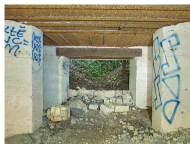
Vue du bunker - casemate de type 680 pour un canon de 7,5 cm ou 7,62 cm situé au Sud : chambre de tir (depuis l'embrasure vers la porte du bunker partiellement murée par des parpaings). De part et d'autre du passage d'entrée sont situées les deux soutes à munitions Phot. Bernard Bègne IVR53_20232200428NUCA
