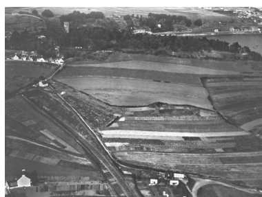
Vue aérienne oblique de l'ensemble fortifié de la Pointe de Cesson, extrait du rapport Pinczon du Sel, photo n° 33, vers 1946-1947 (collection : Alain Bohée) Repro. Service Historique de la Défense, Phot. Alain Bohée IVR53_20232205318NUCA
