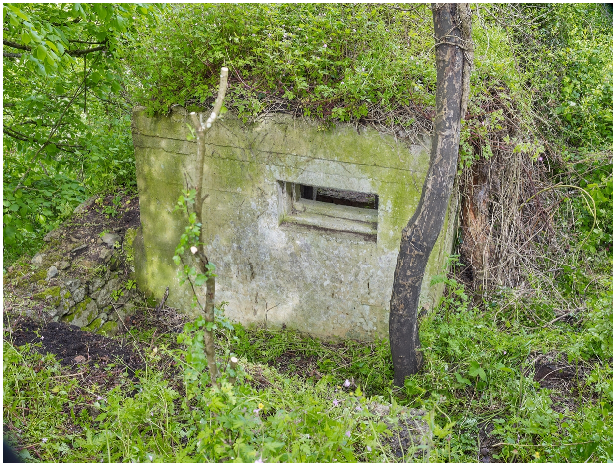
Vue du bunker - poste d'observation et de tir situé à l'extrémité Est de la pointe : embrasure orientée vers le Nord-nord-ouest (vers le bunker - casemate de type 612). Le bunker est adossé au parapet du mur de clôture du domaine
