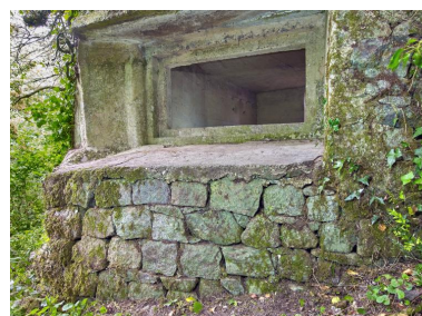
Vue du bunker - casemate de type VF pour un canon de 50 mm situé à l'extrémité Est de la pointe : embrasure rectangulaire en gradin (photographiée de l'extérieur). Le bunker est intégré dans le mur de clôture - soutènement du domaine Phot. Bernard Bègne IVR53_20232200379NUCA
