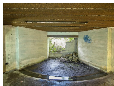
Vue du bunker - casemate de type 612 pour un canon de campagne ou obusier de 7,62 cm ou 10,5 cm situé à l'extrémité Est de la pointe : chambre de tir (vers l'embrasure) : au centre, embrasure rectangulaire. L'embrasure est partiellement murée par des parpaings Phot. Bernard Bègne IVR53_20232200293NUCA
