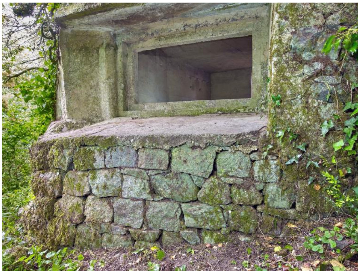
Vue du bunker - casemate de type VF pour un canon de 50 mm situé à l'extrémité Est de la pointe : embrasure rectangulaire en gradin (photographiée de l'extérieur). Le bunker est intégré dans le mur de clôture - soutènement du domaine
