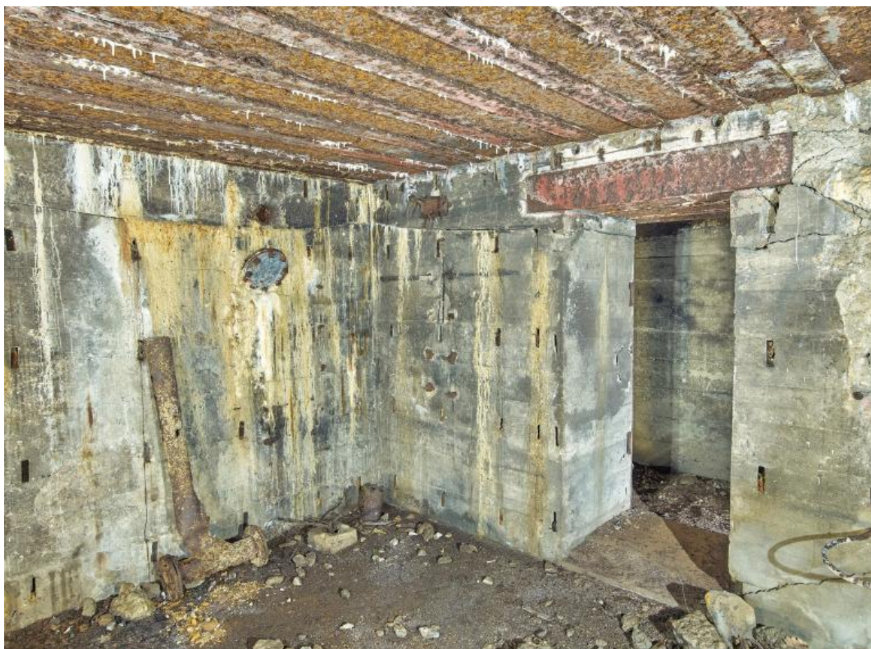
Vue du bunker - abri de type 502 situé à l'extrémité Est de la pointe : pièce de vie - chambre Sud
