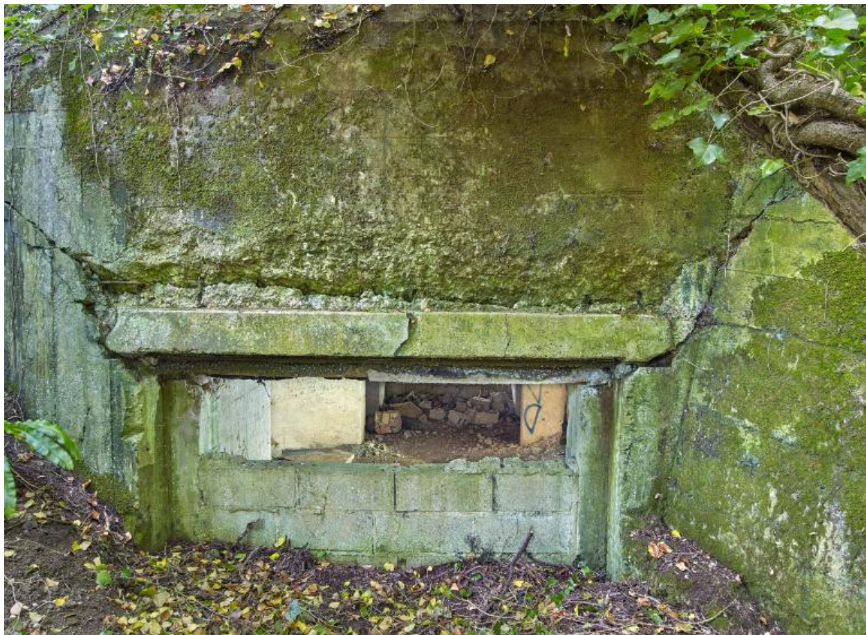
Vue du bunker - casemate de type 680 pour un canon de 7,5 cm ou 7,62 cm situé au Sud : embrasure (photographiée de l'extérieur). L'embrasure est partiellement murée par des parpaings
