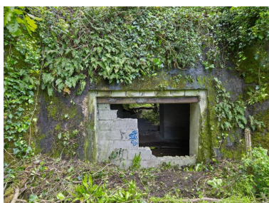
Vue du bunker - casemate de type 612 pour un canon de campagne ou obusier de 7,62 cm ou 10,5 cm situé à l'extrémité Est de la pointe : embrasure (photographiée de l'extérieur). L'embrasure est partiellement murée par des parpaings Phot. Bernard Bègne IVR53_20232200298NUCA
