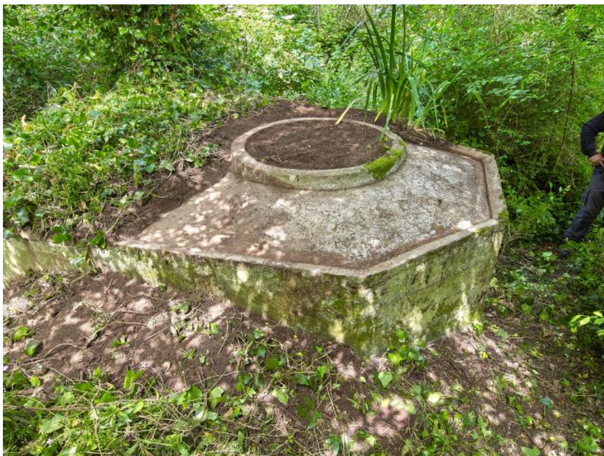
Vue du bunker - poste d'observation et de tir de type 58c dit Tobruk-Stand Est, accolé au bunker - abri de type 502 situé à l'extrémité Est de la pointe : une mince dalle de béton protège le poste d'observation et de tir circulaire des risques de chute
