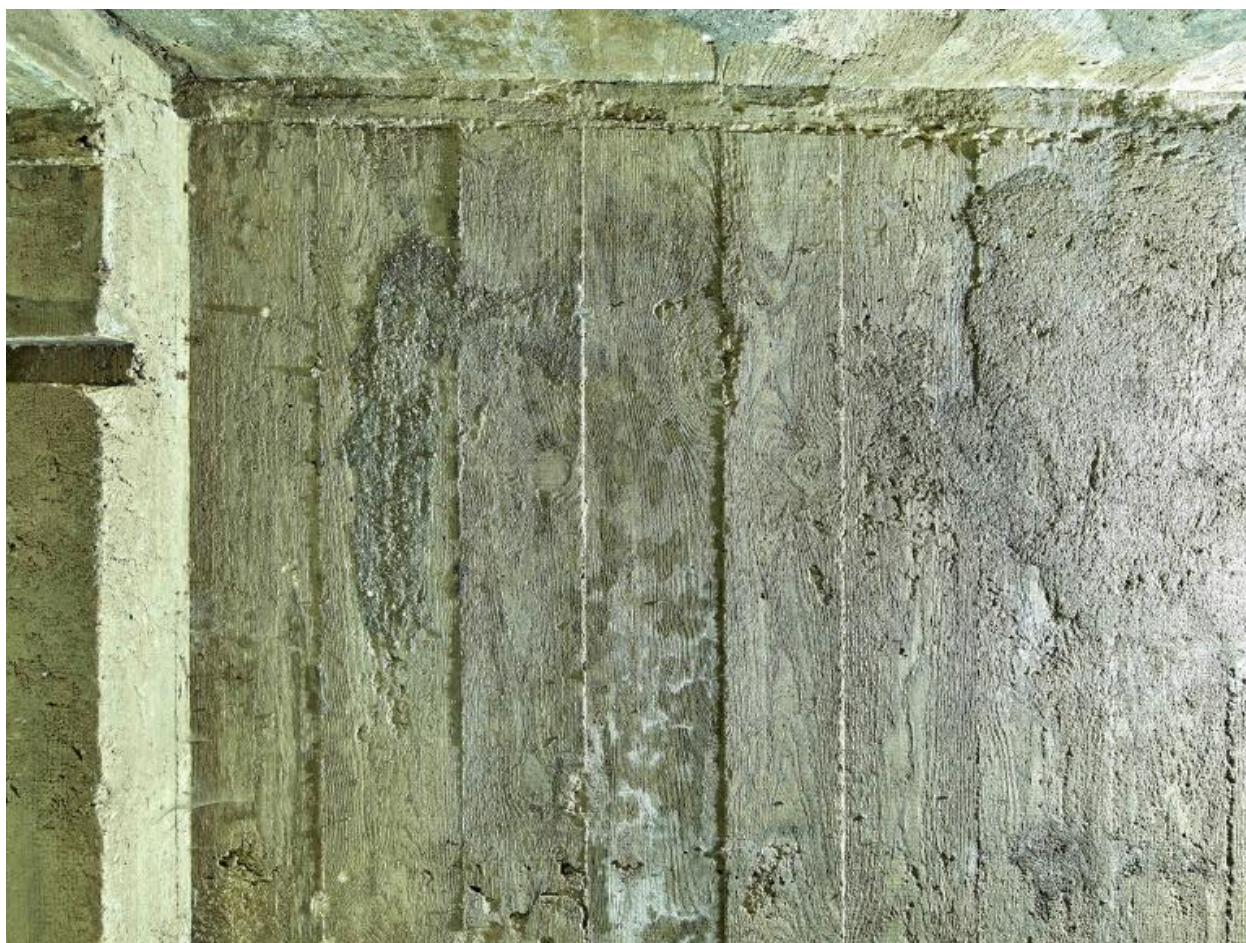
Vue des traces du coffrage sur le béton du vestibule : il s'agit de planches de sapin (Bunker - casemate de flanquement implanté sur le versant Nord vers le Gouët)
