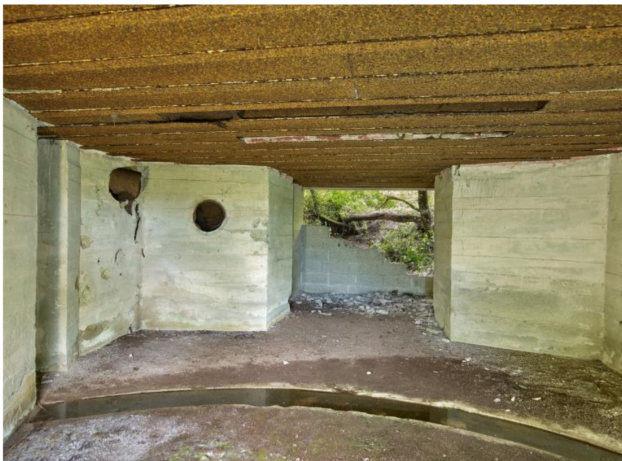
Vue du bunker - casemate de type 612 pour un canon de campagne ou obusier de 7,62 cm ou 10,5 cm situé à l'extrémité Est de la pointe : entrée (photographiée de l'intérieur). L'entrée du bunker est partiellement murée par des parpaings
