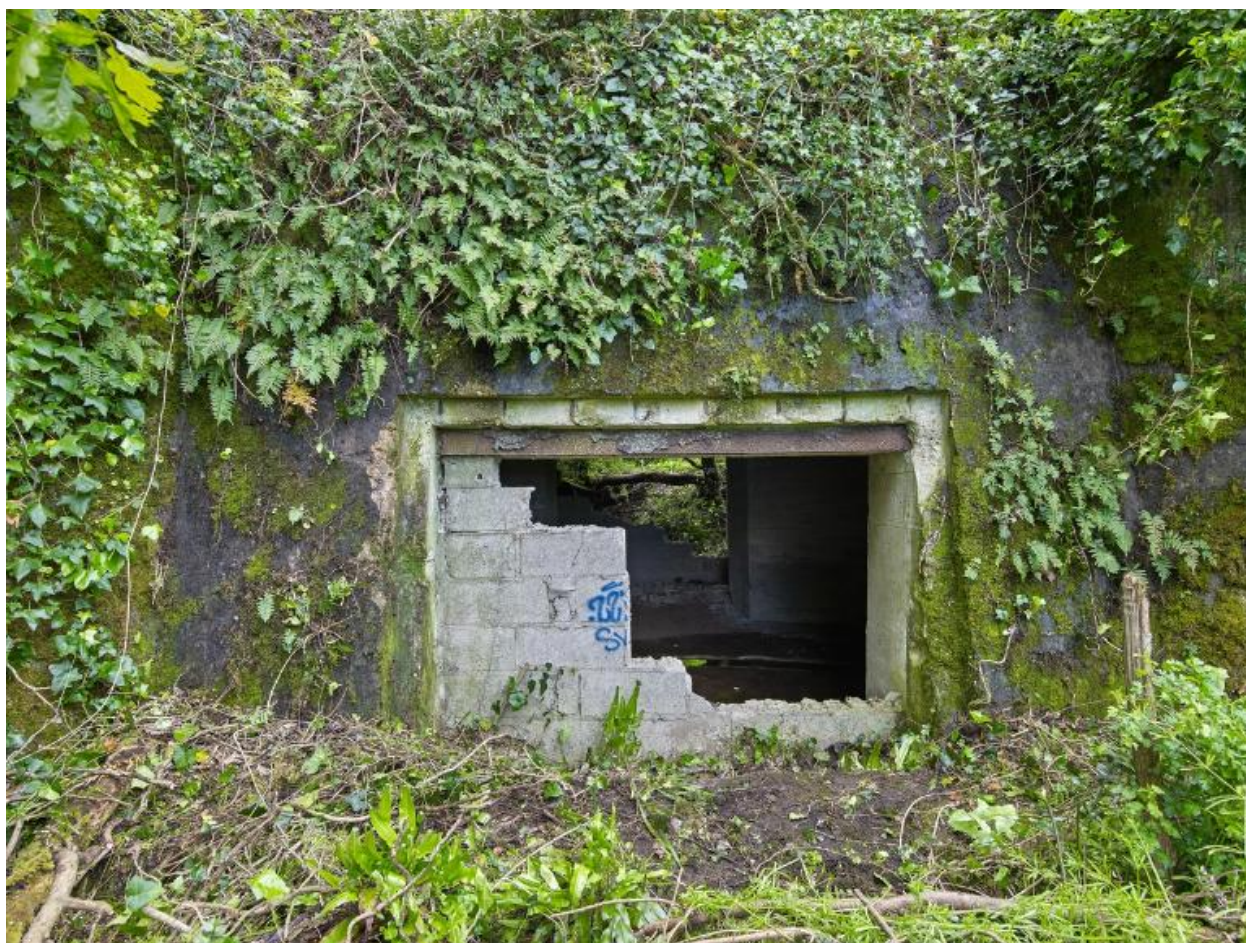
Vue du bunker - casemate de type 612 pour un canon de campagne ou obusier de 7,62 cm ou 10,5 cm situé à l'extrémité Est de la pointe : embrasure (photographiée de l'extérieur). L'embrasure est partiellement murée par des parpaings
