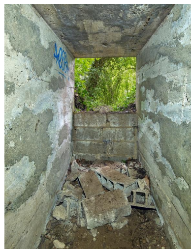
Vue du bunker - casemate de flanquement implanté sur le versant Nord vers le Gouët :
