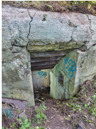
Vue du bunker - abri de type 502 situé à l'extrémité Est de la pointe : entrée Sud (ce type de bunker est dotée de deux entrées ; la seconde est murée). L'entrée Sud du bunker est partiellement murée par des parpaings (en partie basse). La tranchée d'accès est remblayée par des déchets Phot. Bernard Bègne IVR53_20232200404NUCA
