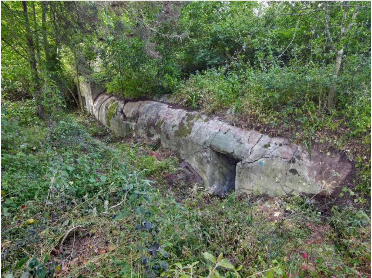
Vue du bunker - abri de type 502 situé à l'extrémité Est de la pointe : entrée Sud (ce type de bunker est dotée de deux entrées). La tranchée d'accès au bunker est remblayée par des déchets. A l'extrémité Nord se trouve, un poste d'observation et de tir de type 58c dit Tobruk-Stand
