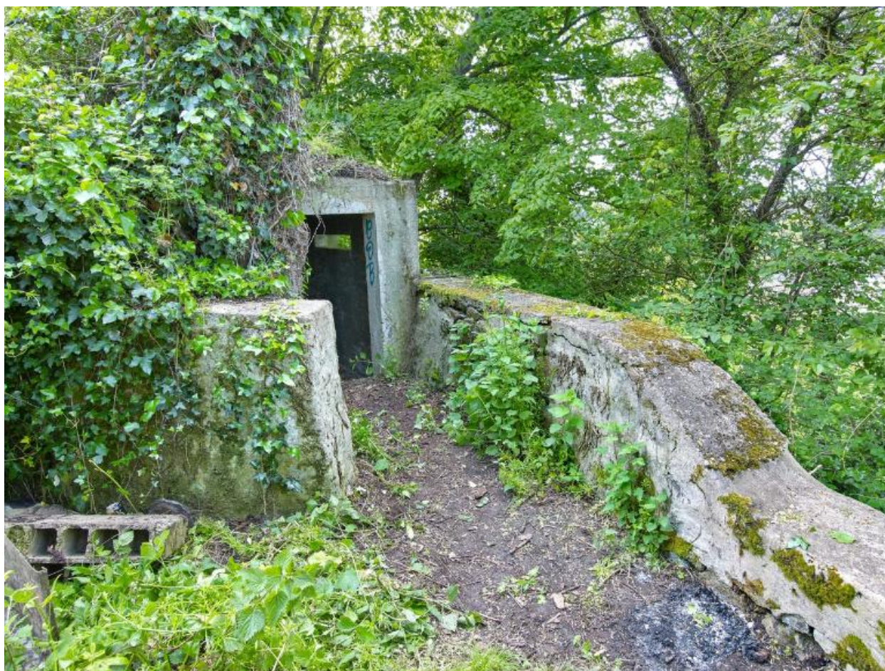
Vue du bunker - poste d'observation et de tir situé à l'extrémité Est de la pointe : entrée. Le bunker est adossé au parapet du mur de clôture du domaine
