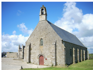
Plougonvelin, chapelle Notre-Dame-des-Grâces : vue générale sud-ouest Phot. Gwénaél Fauchille IVR53_20082906249NUCA
