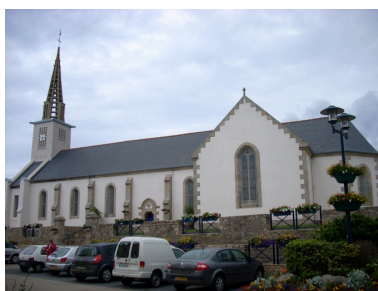
Plouguerneau, église de Lilia : vue générale sud-est Phot. Gwénaél Fauchille IVR53_20082906119NUCA
