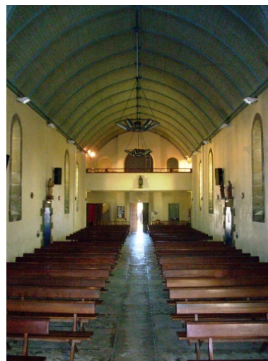
Plouguerneau, église de Lilia : vue axiale ouest Phot. Gwénaél Fauchille IVR53_20082906123NUCA
