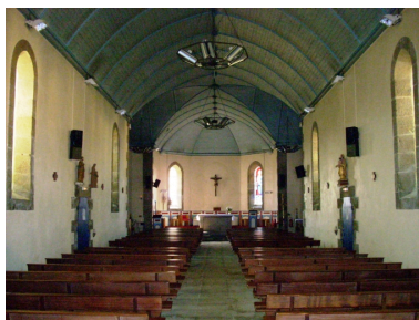
Plouguerneau, église de Lilia : vue axiale est Phot. Gwénaél Fauchille IVR53_20082906122NUCA
