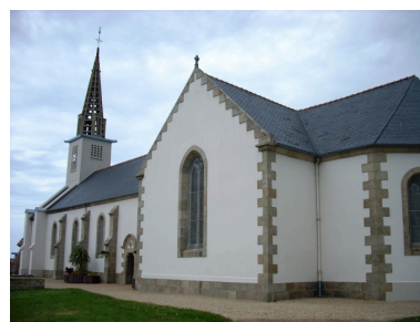
Plouguerneau, église de Lilia : vue générale sud-est Phot. Gwénaél Fauchille IVR53_20082906120NUCA
