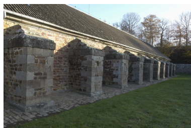
Vue du du magasin à poudre : détail de l'élévation sud avec ses contreforts Phot. Norbert Lambart IVR53_20063502644NUCA
