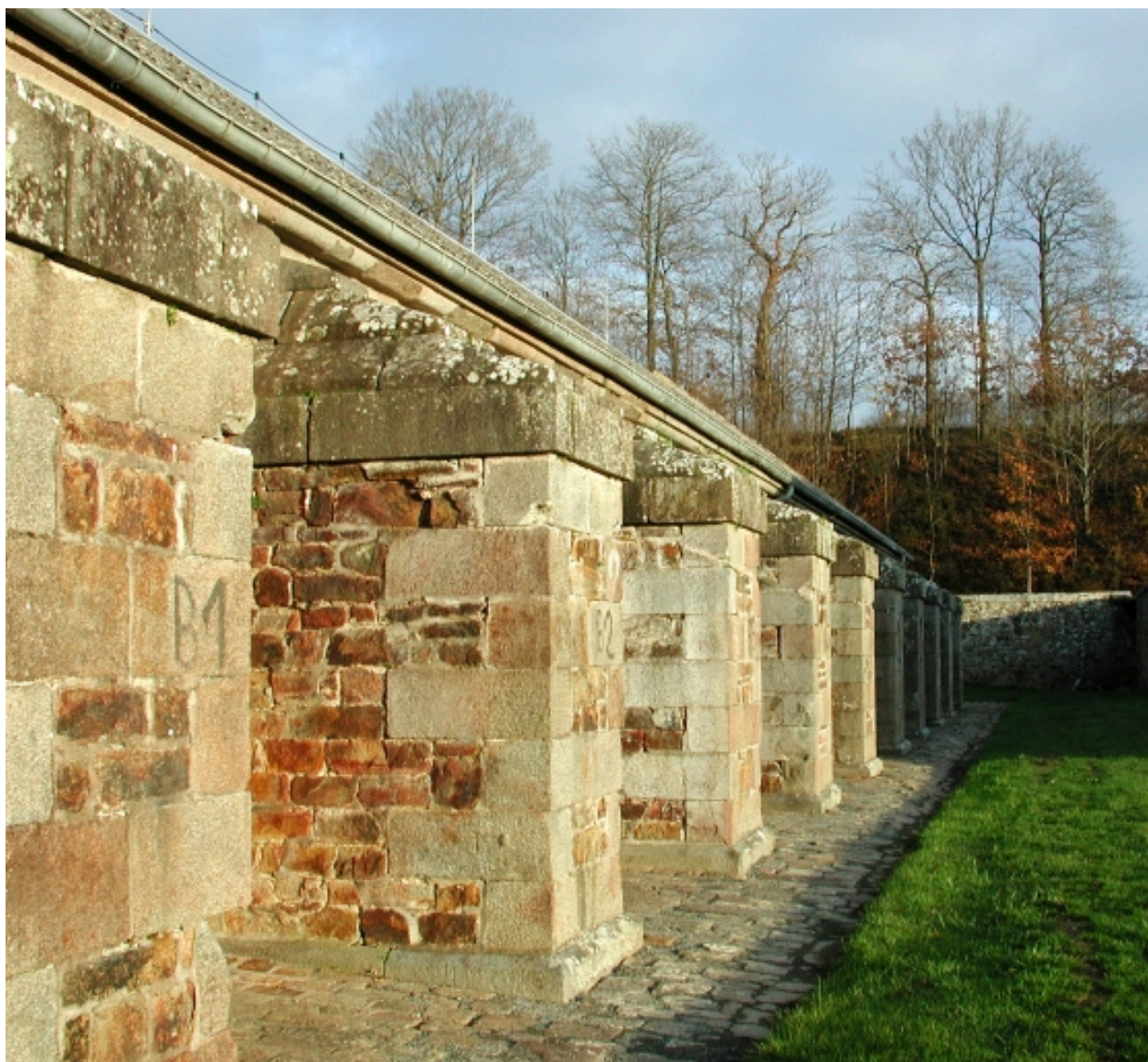
Vue du du magasin à poudre : détail de l'élévation sud avec ses contreforts
