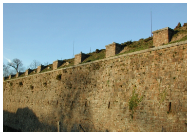
Vue générale du front sud. Les souches de cheminée des casemates émergent du rempart. A intervalle régulier sont disposés des créneaux de fusillade Phot. Guillaume Lécueillier IVR53_20043521144NUCA
