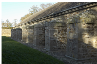
Vue du du magasin à poudre : détail de l'élévation nord avec ses contreforts Phot. Norbert Lambart IVR53_20063502646NUCA
