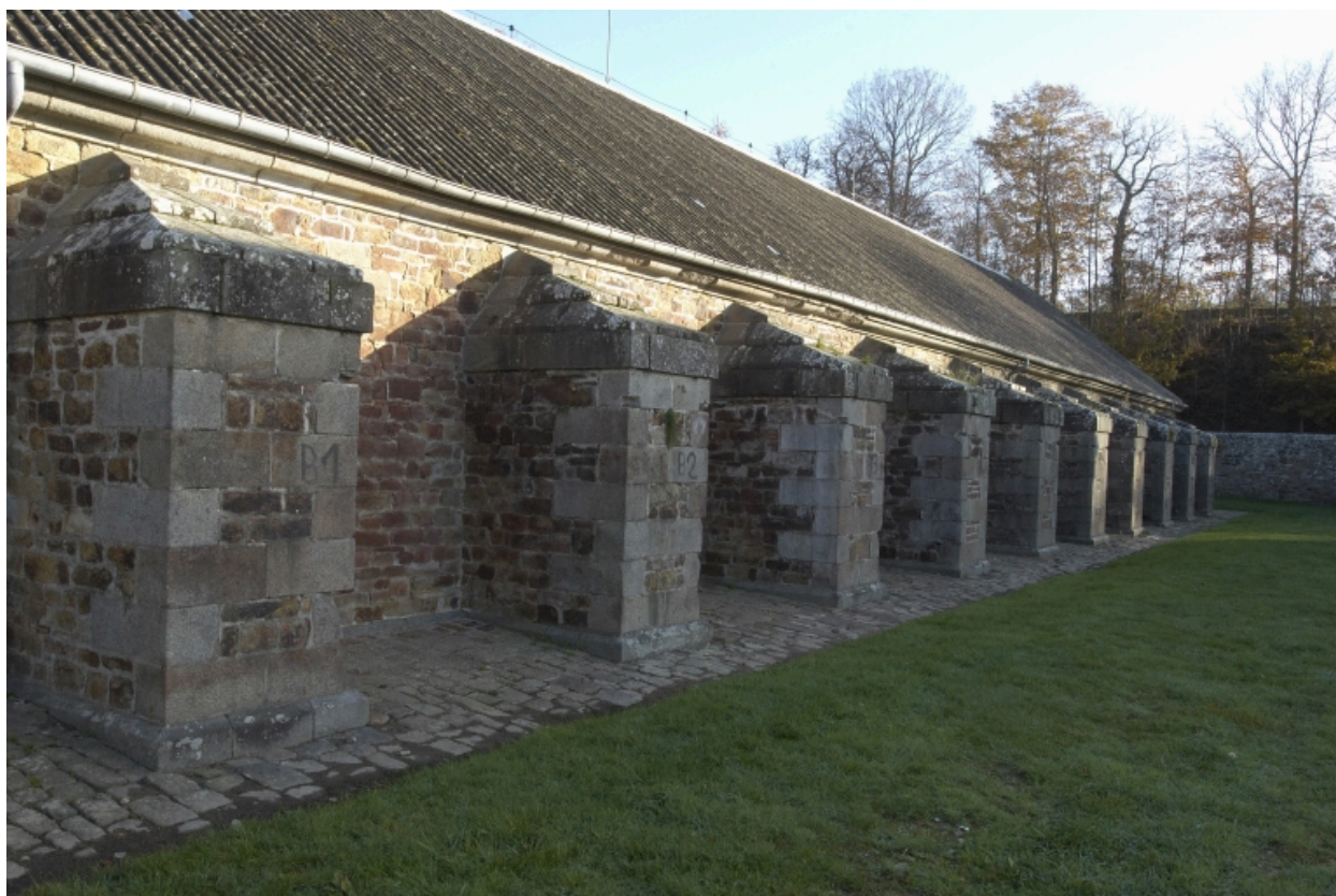
Vue du du magasin à poudre : détail de l'élévation sud avec ses contreforts
