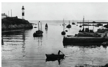
Phare aval dans les années 1950 Repro. Johan Vincent, Autr. Auteur inconnu IVR53_20092909044NUCB
