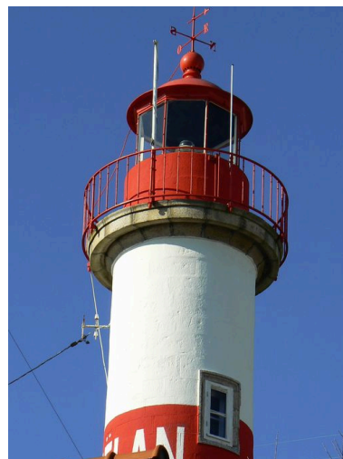
Détail du phare amont de Doëlan Phot. Johan Vincent IVR53_20092909060NUCA
