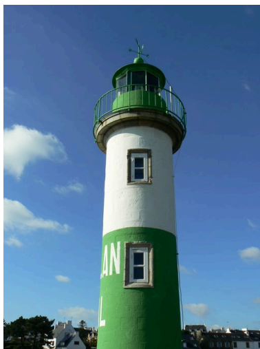
Détail du phare aval de Doëlan Phot. Johan Vincent IVR53_20092909058NUCA
