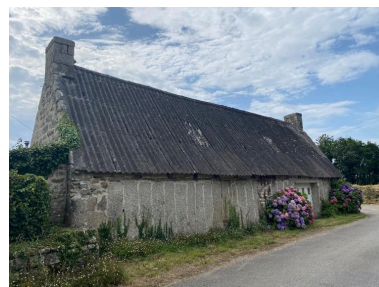
Vue de l'élévation nord. Phot. EMMA POYER IVR53_20242930905NUCA
