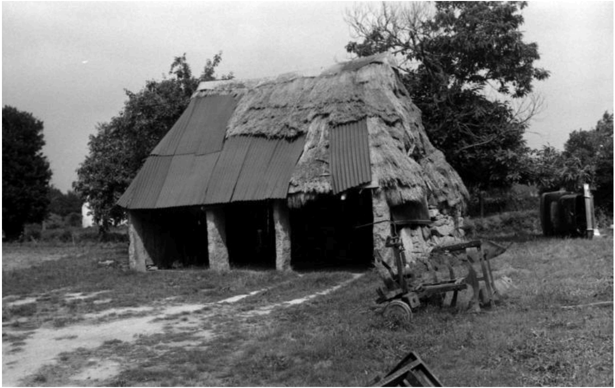
Vue d'ensemble d'une remise agricole sur piliers de granit faisant référence à la technique constructive en orthostates
