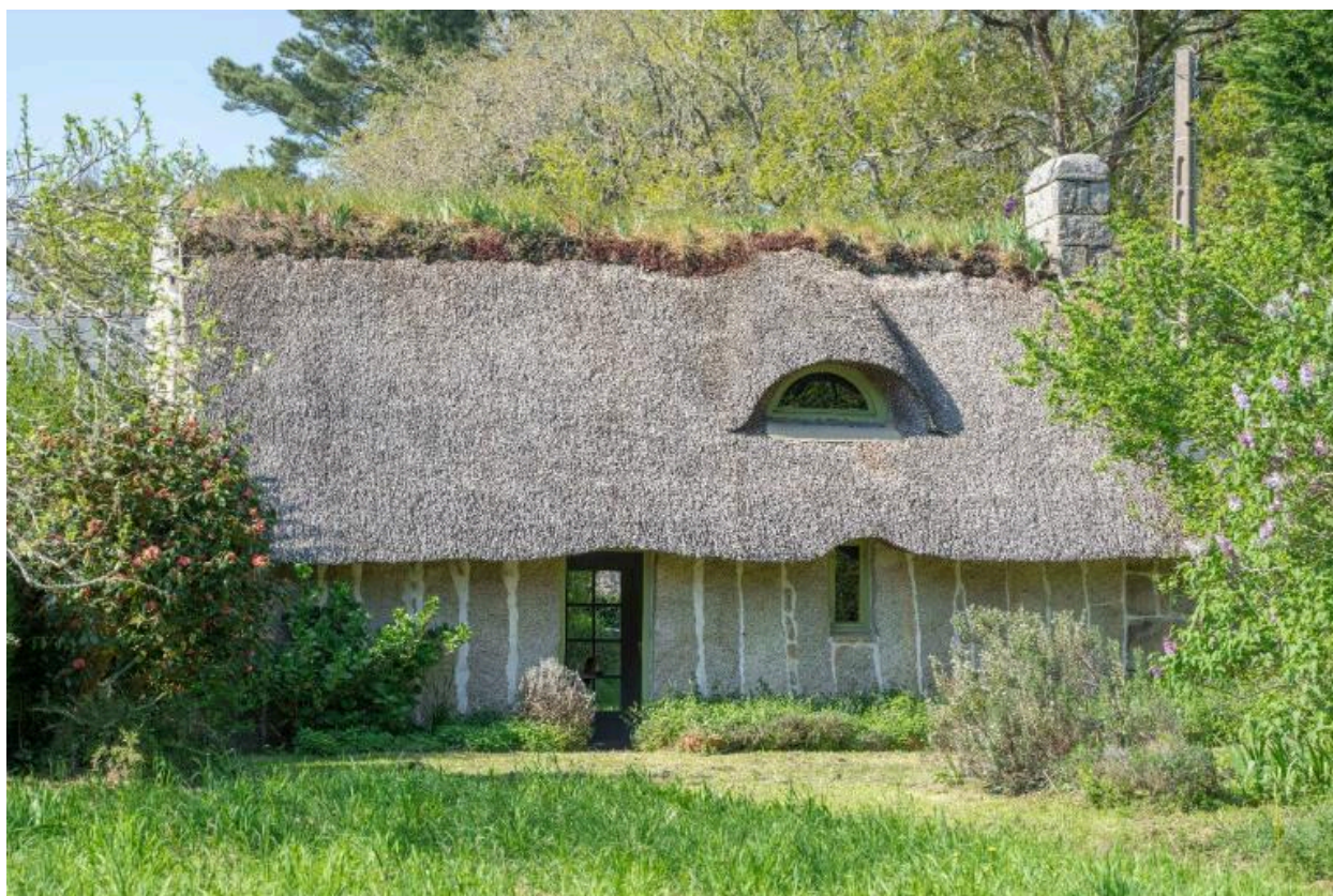
Vue générale de l'élévation antérieure.
