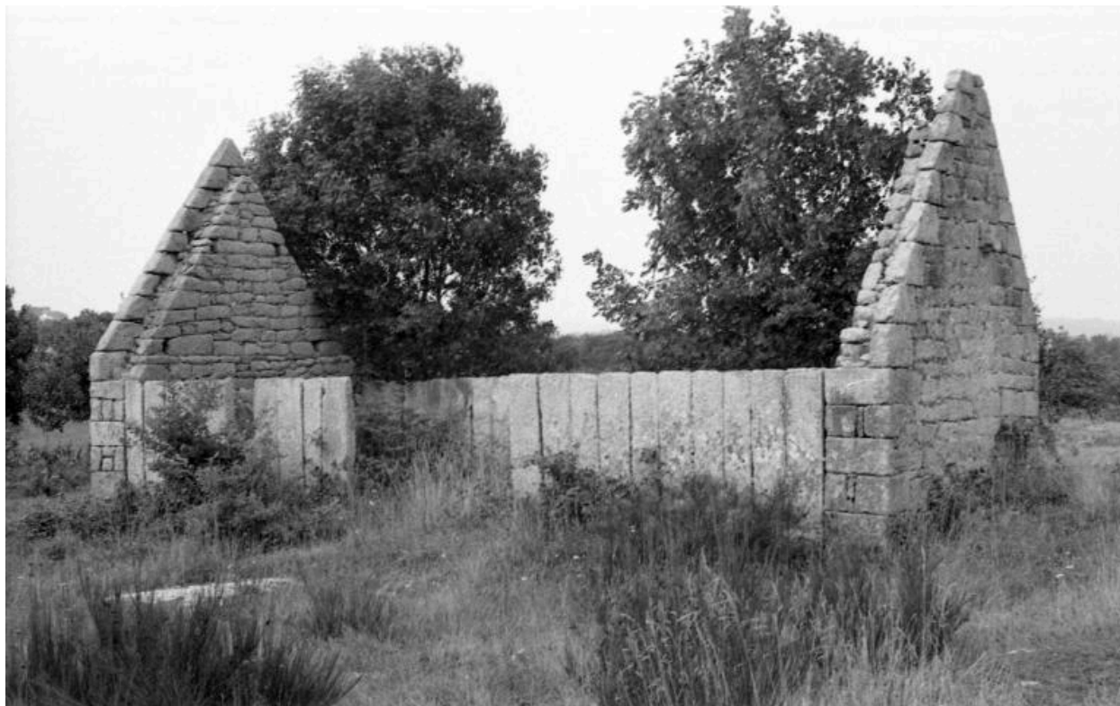
Ancienne grange avec élévations en orthostates pour les murs gouttereaux.
