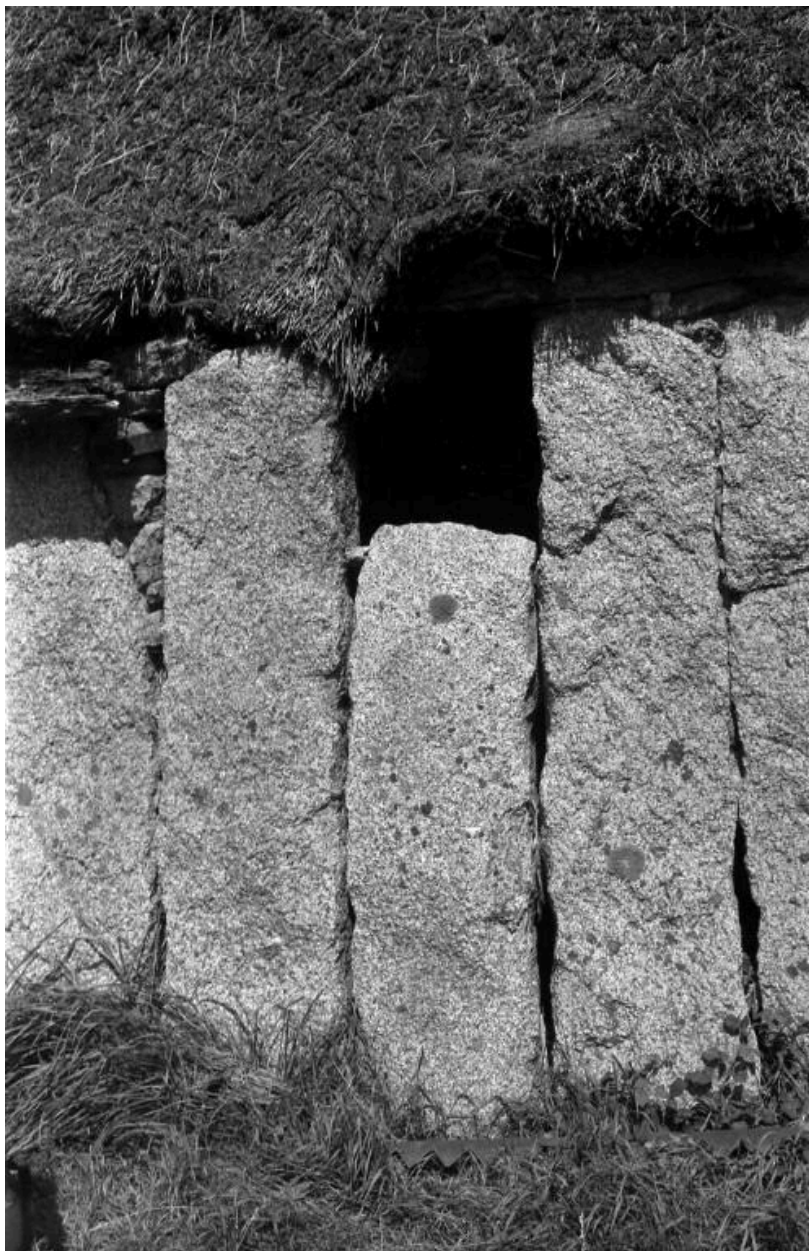
Vue de détail d'une élévation avec orthostates.
