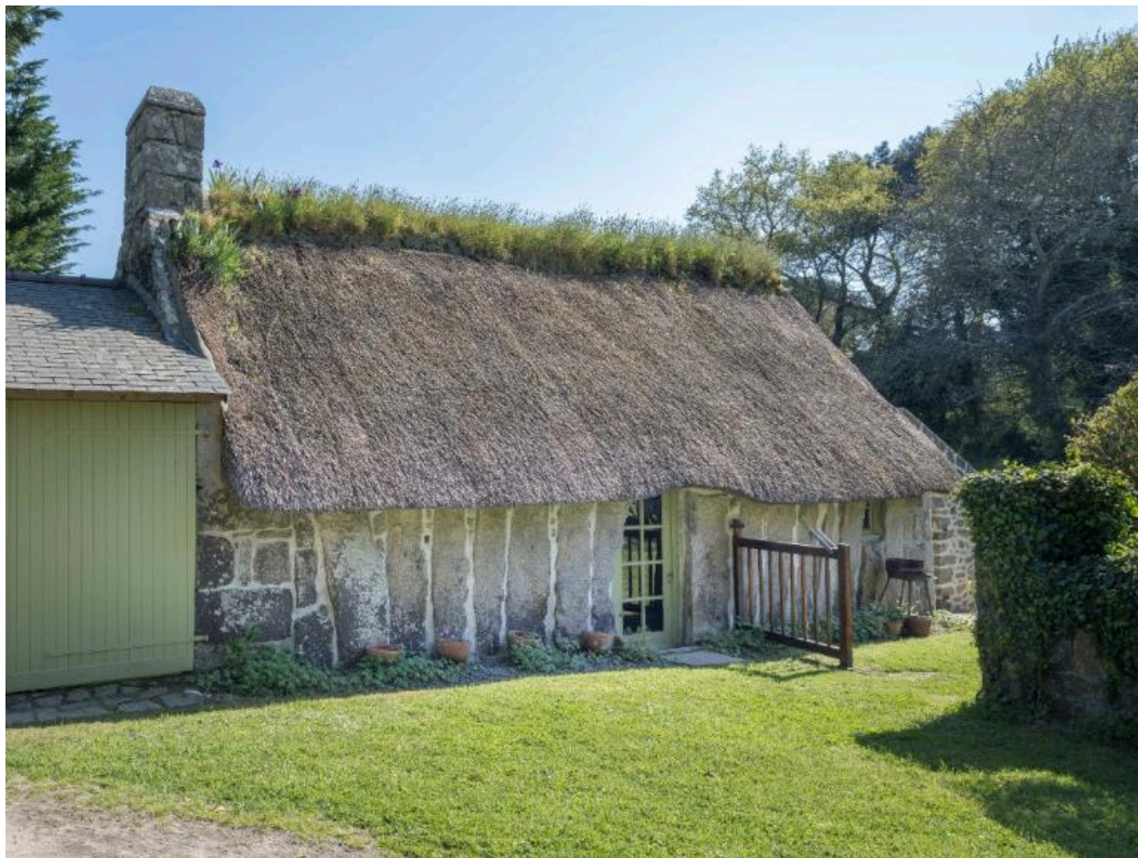
Vue générale de l'élévation postérieure.
