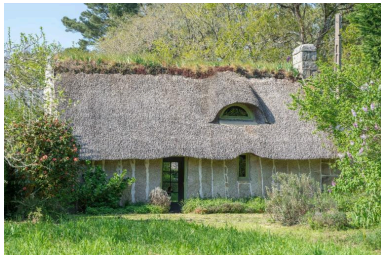
Vue générale de l'élévation antérieure. Phot. Charlotte Barraud IVR53_20252900841NUCA
