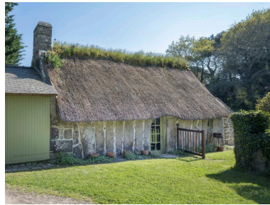
Vue générale de l'élévation postérieure. Phot. Charlotte Barraud IVR53_20252900838NUCA
