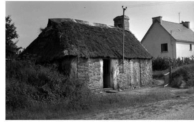
Vue d'ensemble d'un édifice alliant la technique constructive en orthostates à celle d'une maçonnerie en moellons de granite. Phot. J.-P. Leclecq IVR53_19712906024Z
