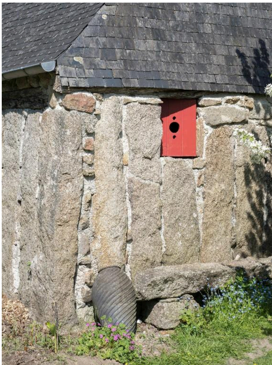
Vue de détail de la mise en oeuvre de l'angle avec orthostates.
