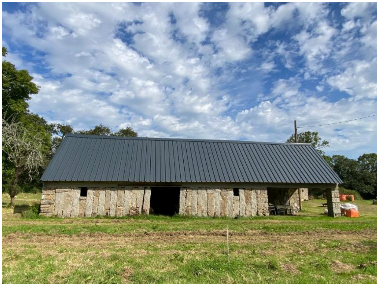
Vue générale de l'élévation sud.
