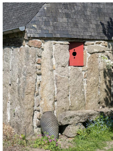
Vue de détail de la mise en oeuvre de l'angle avec orthostates. Phot. Charlotte Barraud IVR53_20252900848NUCA
