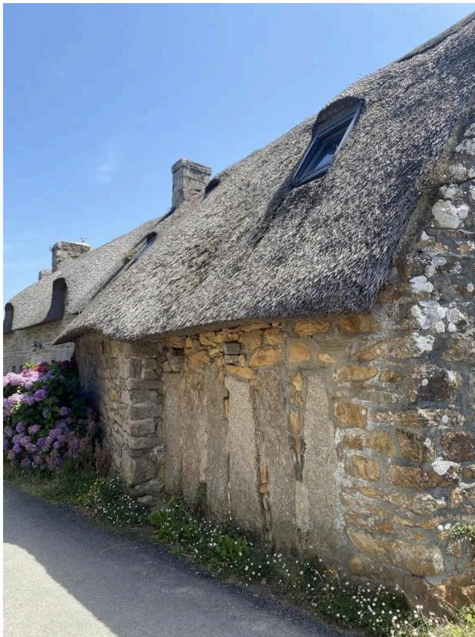
Vue de détail de l'élévation nord.
